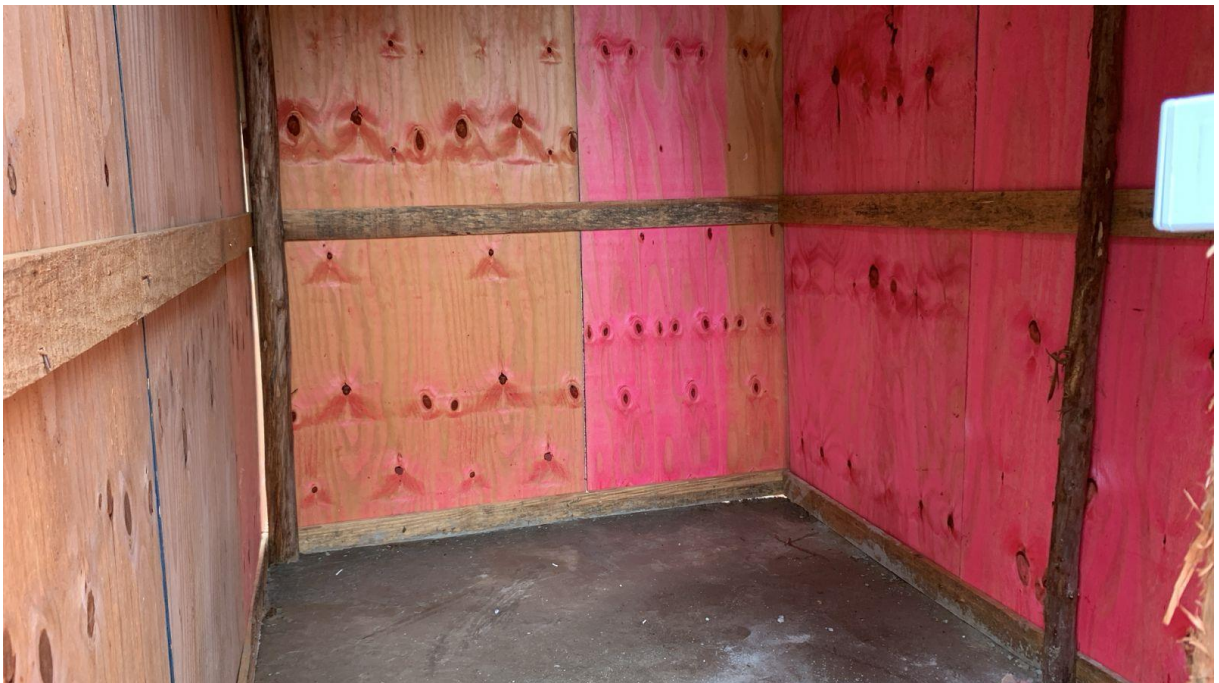
Imagem 03: Detalhe para a execução do barracão para almoxarifado.
