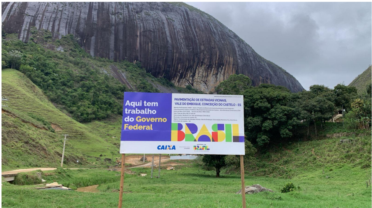
Imagem 01: Detalhe para o fornecimento e instalação de placa de obra com chapa galvanizada e estrutura de madeira.
