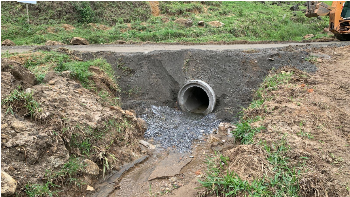
Imagem 06: Detalhe para a execução da escavação mecanizada de vala no trecho de assentamento dos tubos de concreto para redes coletoras de águas pluviais de diâmetro de 800 mm.
