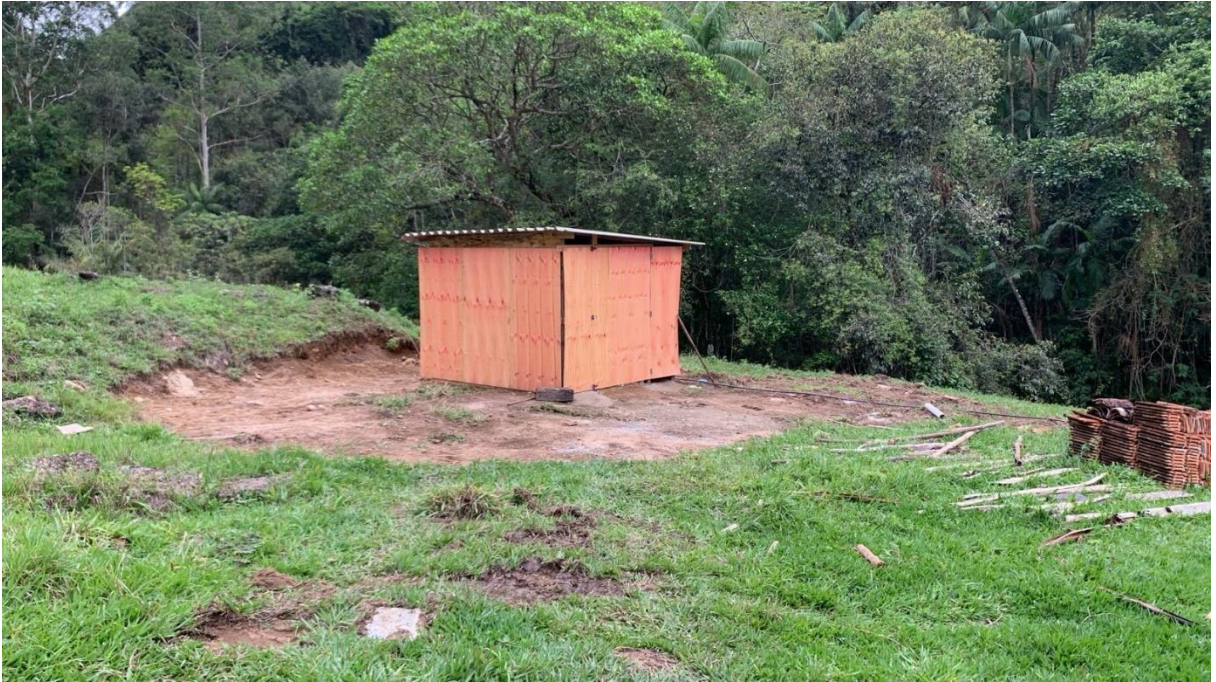
Imagem 02: Detalhe para a execução do barracão para almoxarifado.
