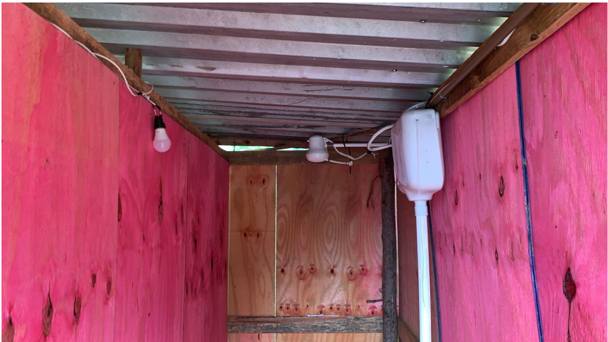
Imagem 05: Detalhe para a execução de sanitário e vestiário, rede de luz, rede de água e rede de esgoto.
