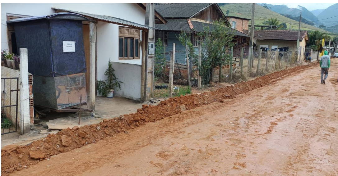
Figura 04: Detalhe para a demolição da calçada, limpeza e carga.
