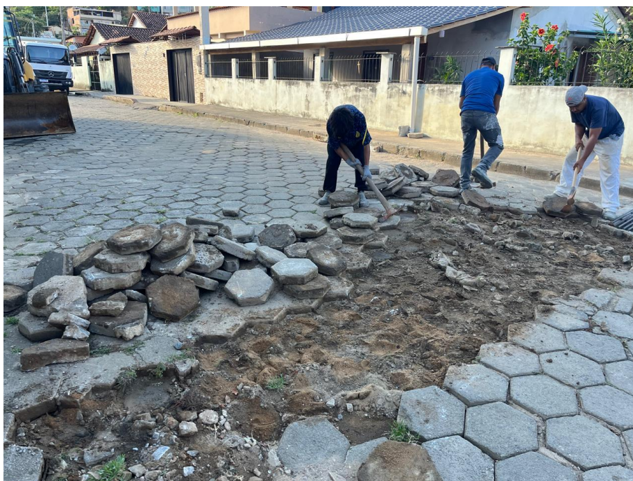
Figura 02: Detalhe para a retirada manual de blocos pré-moldados em concreto (Blokret) e meios fios.
