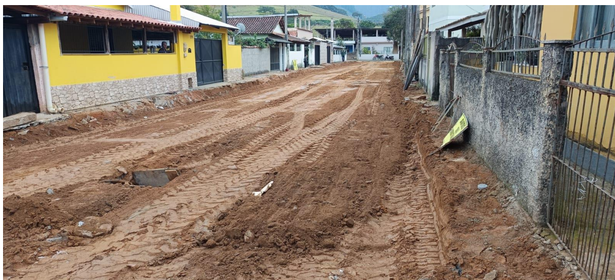
Figura 07: Detalhe para a demolição da calçada, limpeza e carga.
