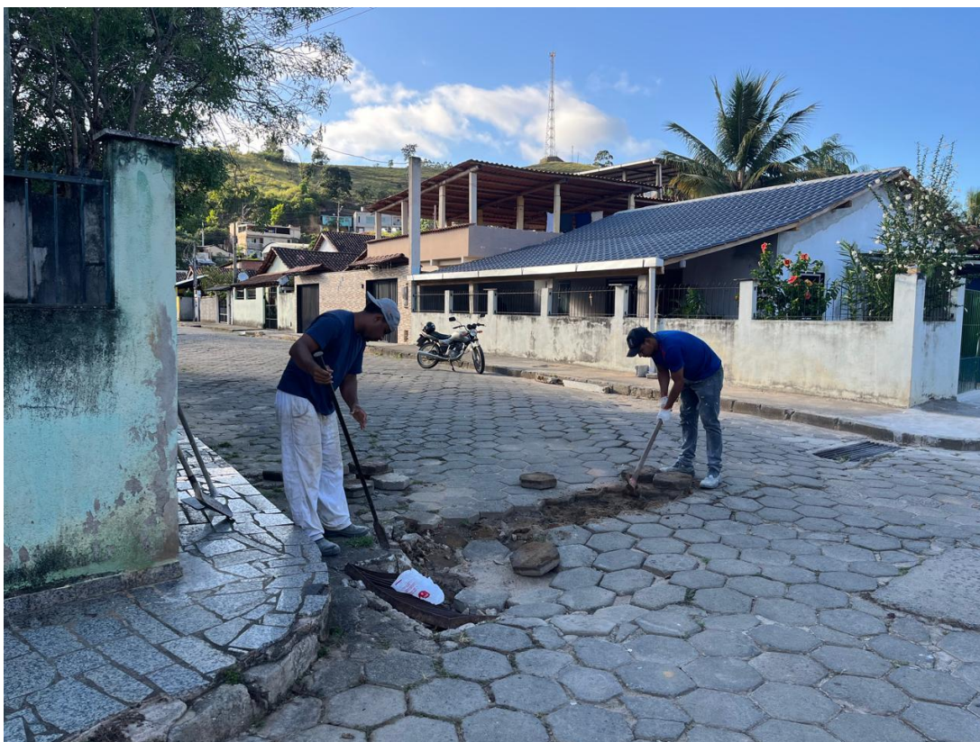
Figura 03: Detalhe para a retirada manual de blocos pré-moldados em concreto (Blokret) e meios fios.
