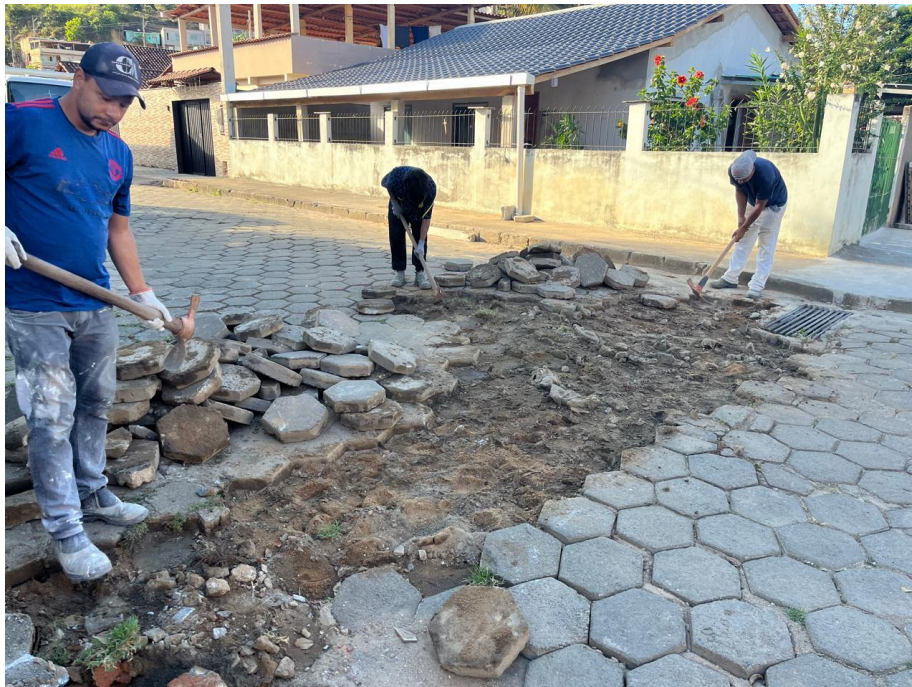
Figura 01: Detalhe para a retirada manual de blocos pré-moldados em concreto (Blokret) e meios fios.
