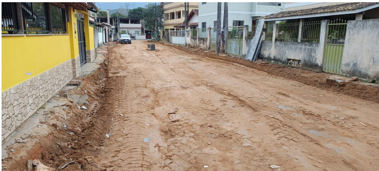
Figura 05: Detalhe para a demolição da calçada, limpeza e carga.
