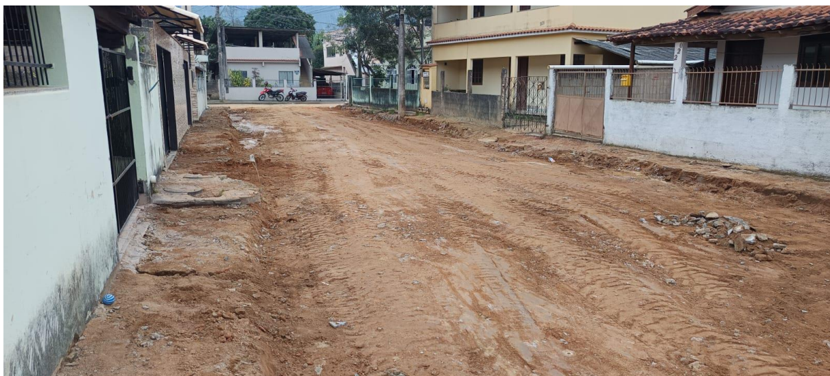
Figura 06: Detalhe para a demolição da calçada, limpeza e carga.
