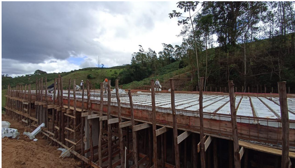
Figura 8 - Detalhe para preparação da laje para concretagem
