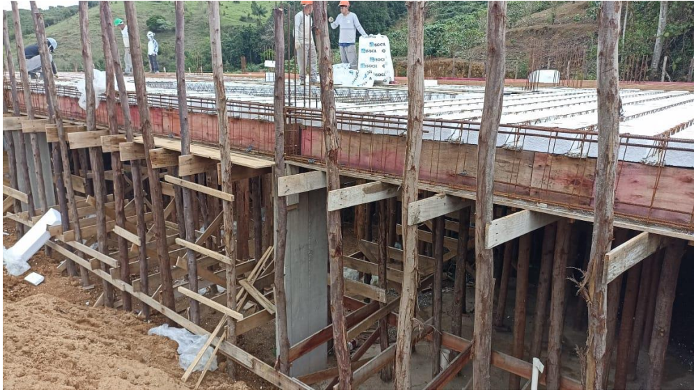
Figura 3 – Detalhe para montagem das armaduras das vigas superiores
