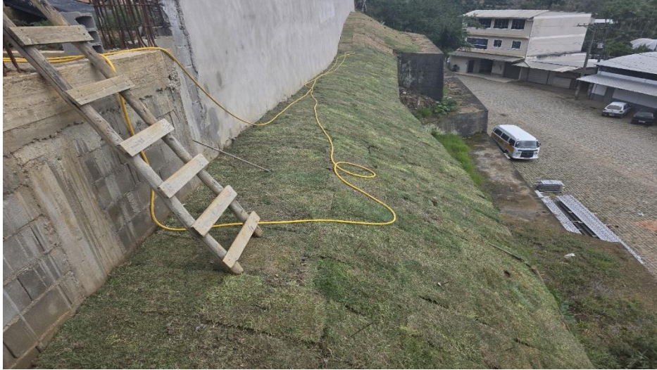
Figura 15 - Detalhe para plantio de grama
