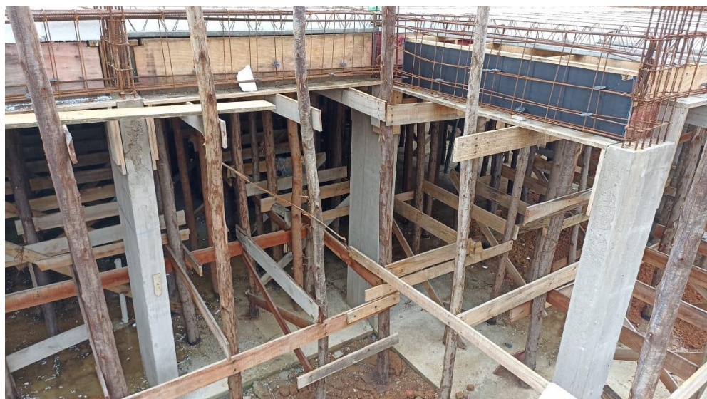
Figura 2 – Detalhe para montagem das armaduras das vigas superiores
