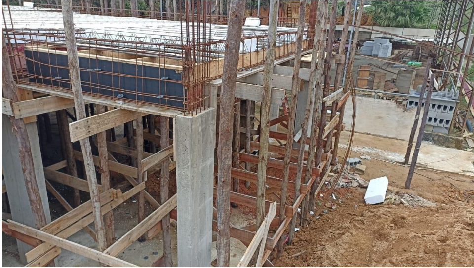
Figura 5 - Detalhe para montagem das armaduras das vigas superiores
