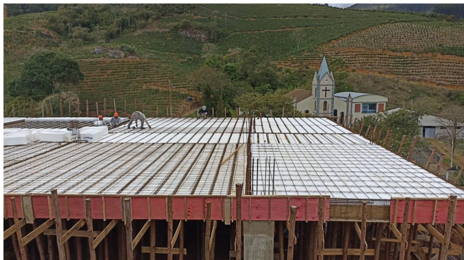
Figura 12 – Detalhe para preparação da laje para concretagem
