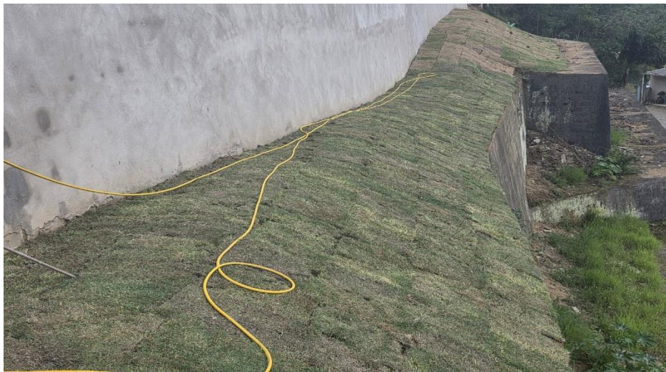
Figura 16 – Detalhe para plantio de grama
