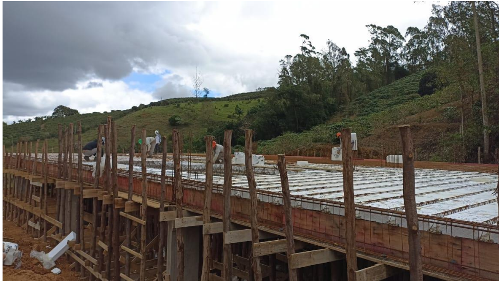
Figura 4- Detalhe para montagem das armaduras das vigas superiores
