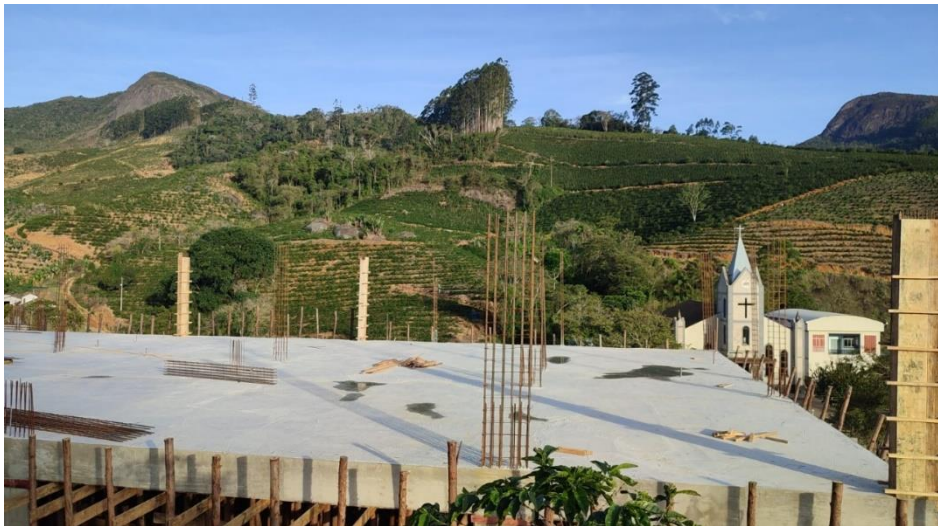
Figura 14 – Detalhe para concretagem da laje do térreo
