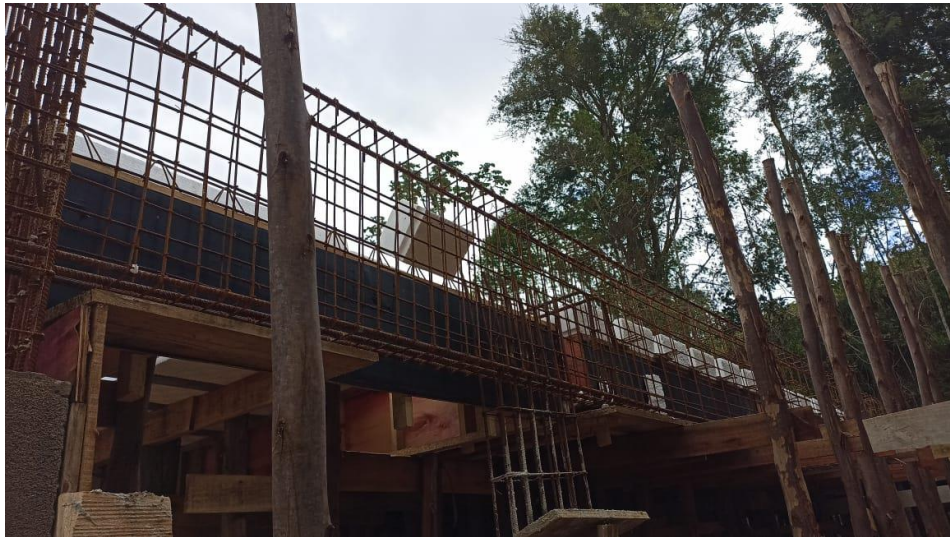
Figura 6 - Detalhe para montagem das armaduras das vigas superiores
