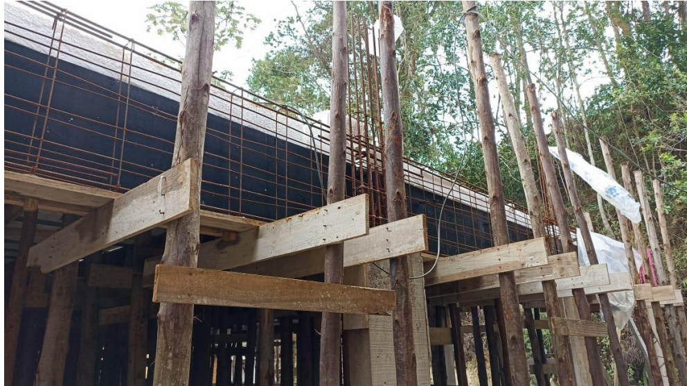
Figura 1 – Detalhe para montagem das armaduras das vigas superiores
