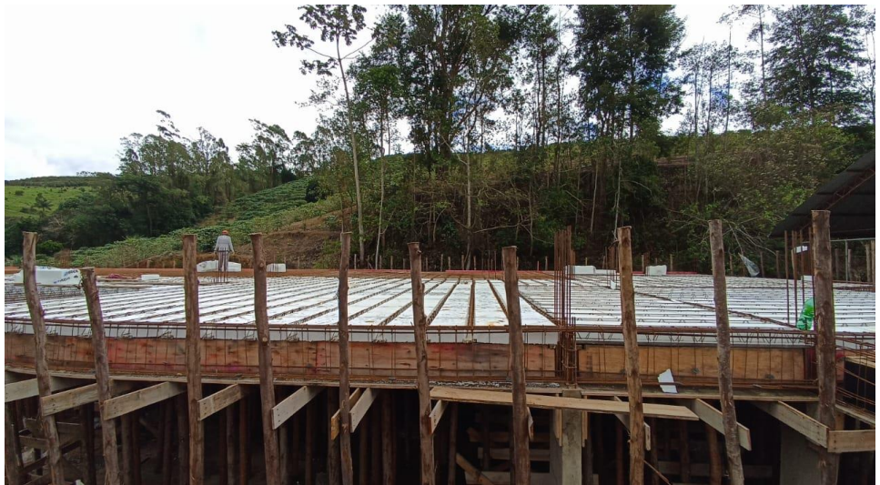
Figura 10 – Detalhe para preparação da laje para concretagem
