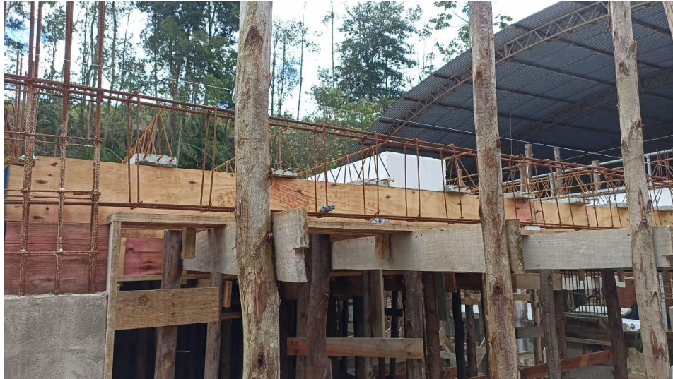
Figura 7 - Detalhe para montagem das armaduras das vigas superiores
