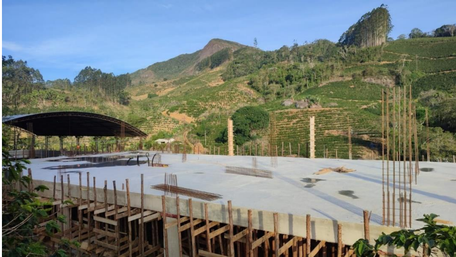
Figura 13 – Detalhe para concretagem da laje do térreo
