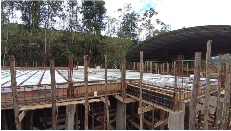
Figura 9 – Detalhe para preparação da laje para concretagem
