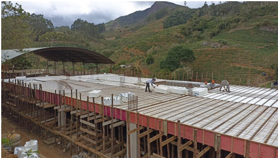
Figura 11 – Detalhe para preparação da laje para concretagem
