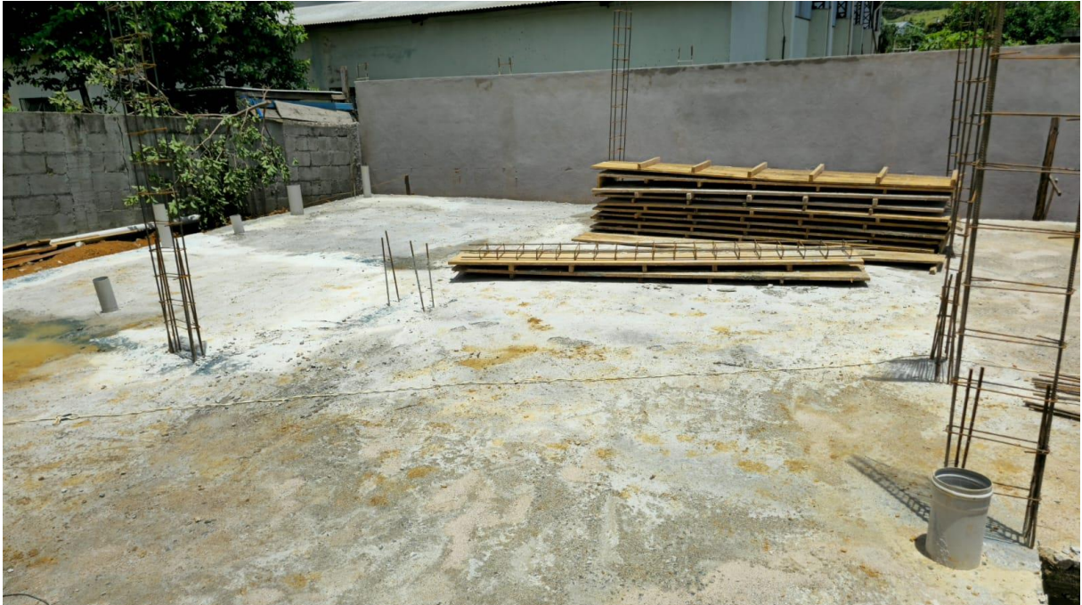
Imagem 06: Detalhe para a execução da etapa de fundação da área de ampliação.
