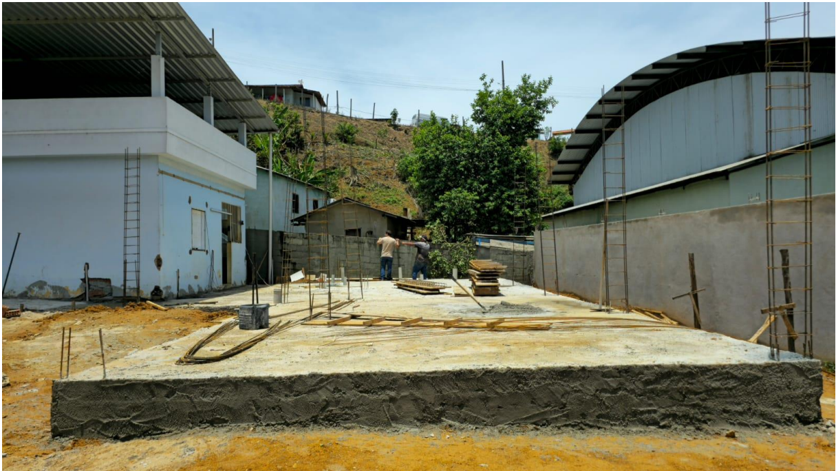
Imagem 02: Detalhe para a execução da etapa de fundação da área de ampliação, bem como das atividades de retirada e demolição referentes à área existente do refeitório.
