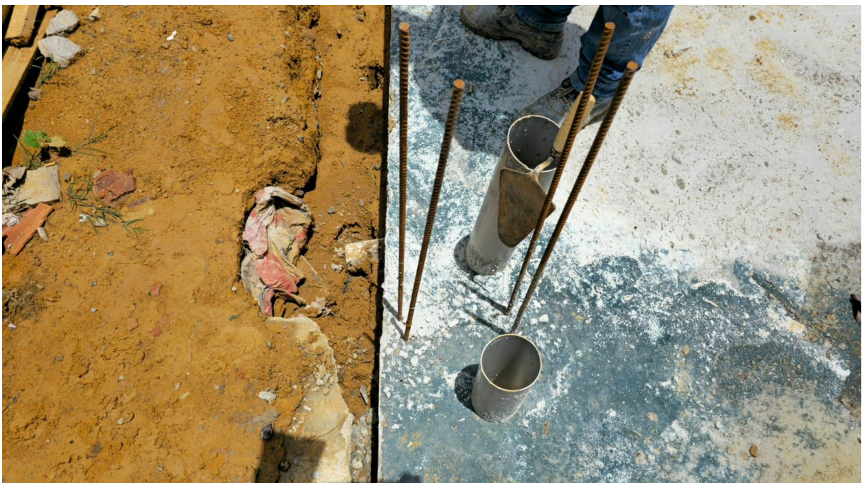
Imagem 09: Detalhe para a execução dos pontos referentes ao sistema hidrossanitário.
