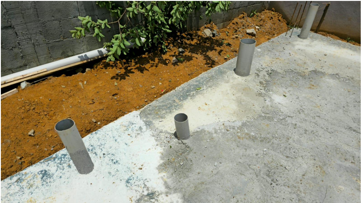
Imagem 08: Detalhe para a execução dos pontos referentes ao sistema hidrossanitário.
