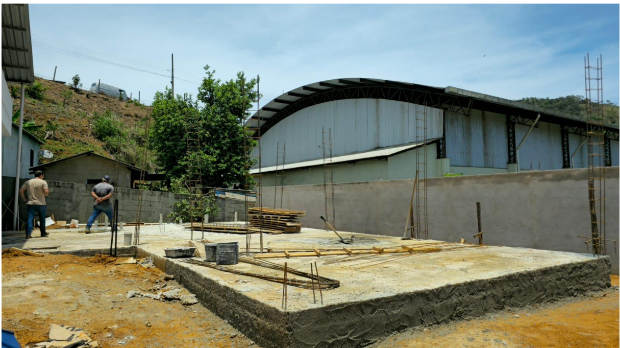
Imagem 03: Detalhe para a execução da etapa de fundação da área de ampliação, bem como das atividades de retirada e demolição referentes à área existente do refeitório.
