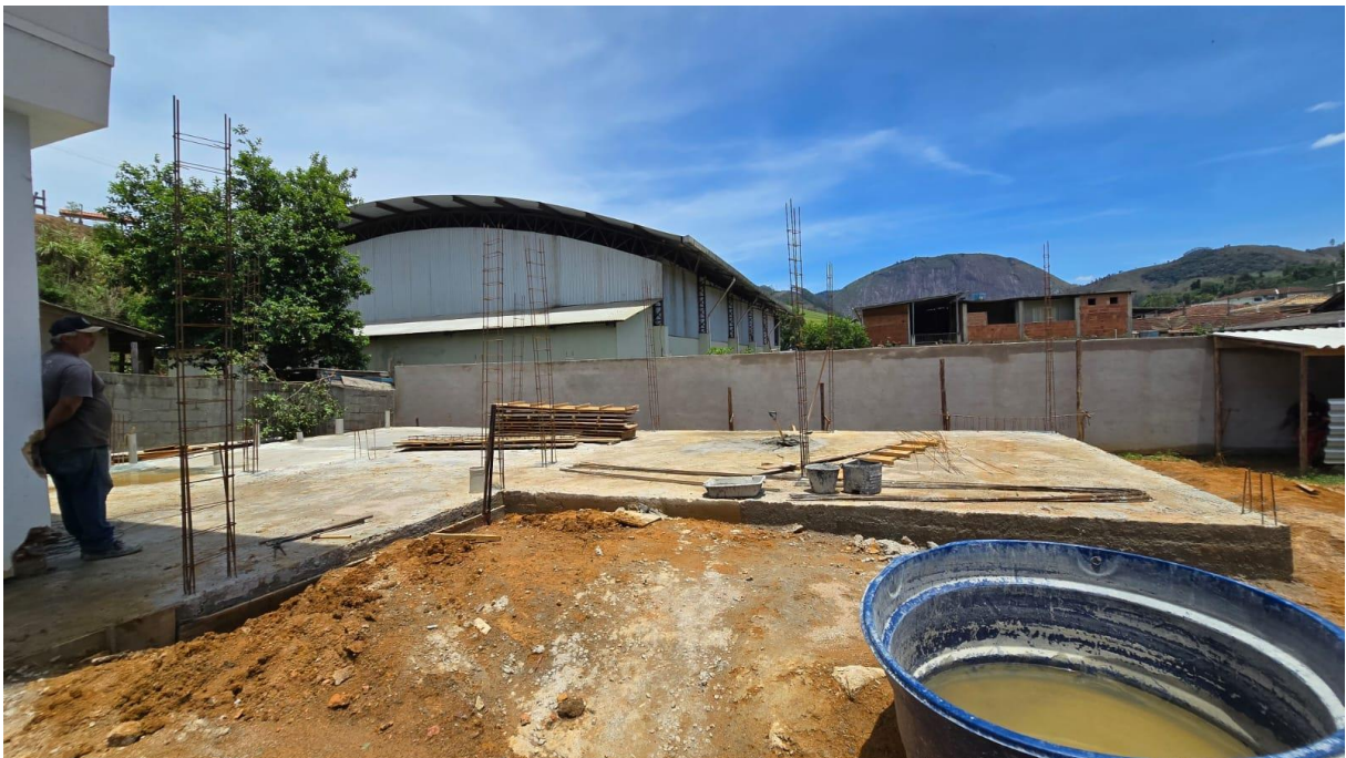
Imagem 01: Detalhe para a execução da etapa de fundação da área de ampliação, bem como das atividades de retirada e demolição referentes à área existente do refeitório.
