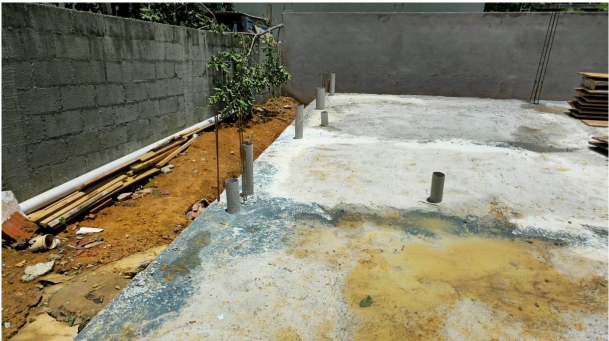
Imagem 07: Detalhe para a execução dos pontos referentes ao sistema hidrossanitário.
