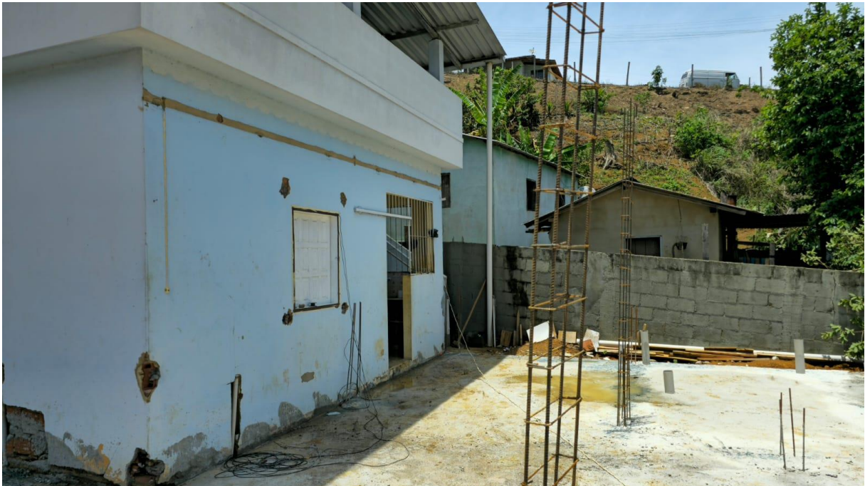
Imagem 04: Detalhe para a execução da etapa de fundação da área de ampliação, bem como das atividades de retirada e demolição referentes à área existente do refeitório.
