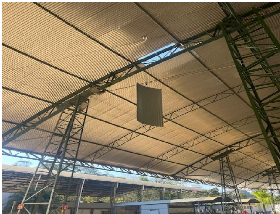
Figura 18 - Detalhe para substituição das telhas metálicas danificadas
