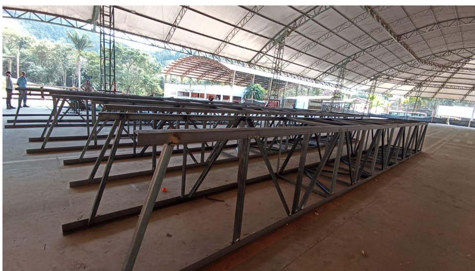
Figura 8 - Detalhe para montagem das estruturas metálica (torres)
