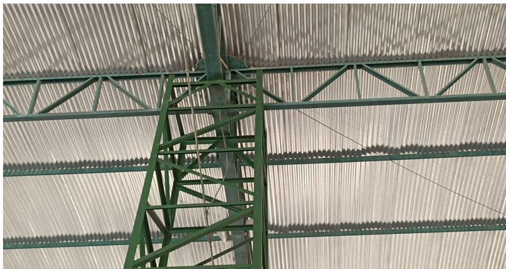
Figura 9 – Detalhe para das estruturas metálica (torres) fixas no topo e na base e devidamente pintadas
