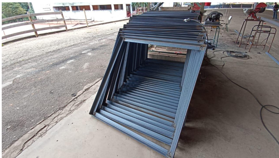
Figura 3 - Detalhe para montagem das bases das estruturas metálicas (torres).
