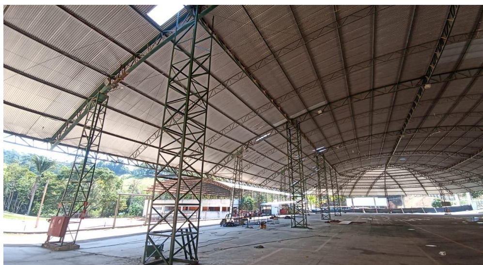
Figura 11 - Detalhe para das estruturas metálica (torres) fixas no topo e na base e devidamente pintadas
