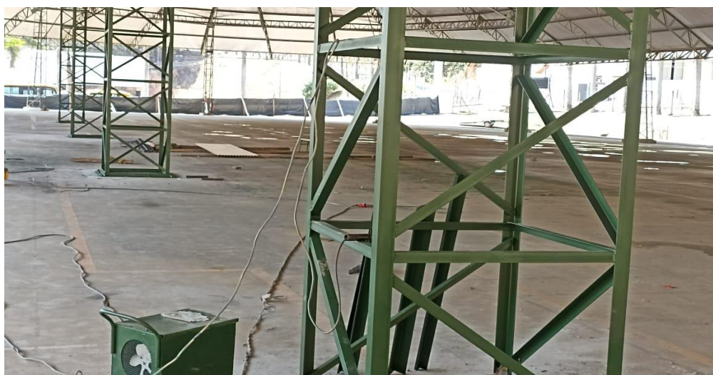
Figura 10 - Detalhe para das estruturas metálica (torres) fixas no topo e na base e devidamente pintadas
