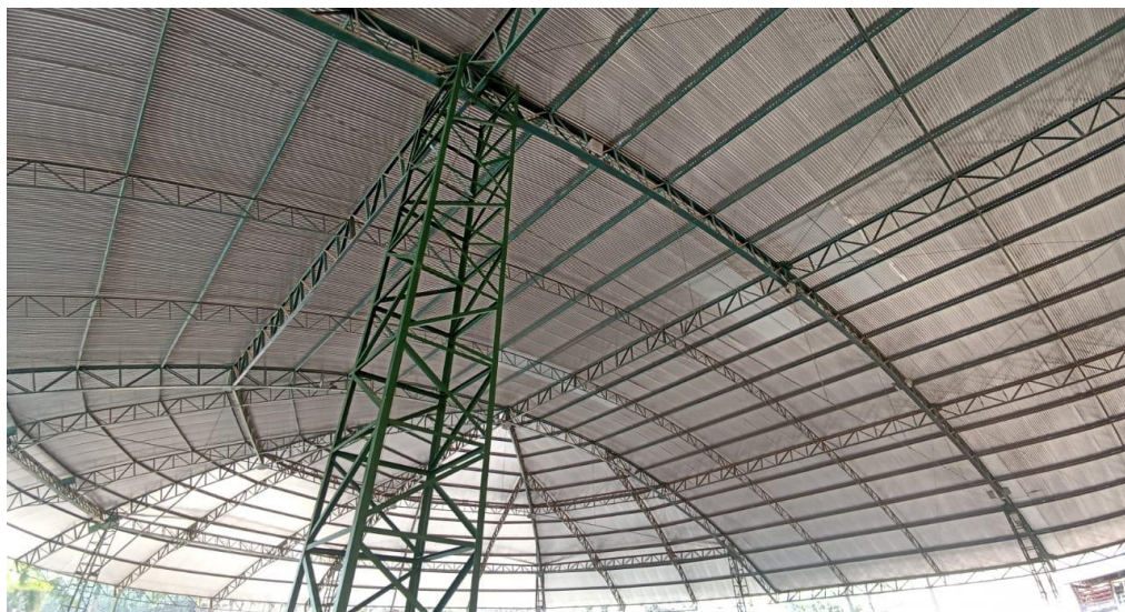
Figura 12 - Detalhe para das estruturas metálica (torres) fixas no topo e na base e devidamente pintadas
