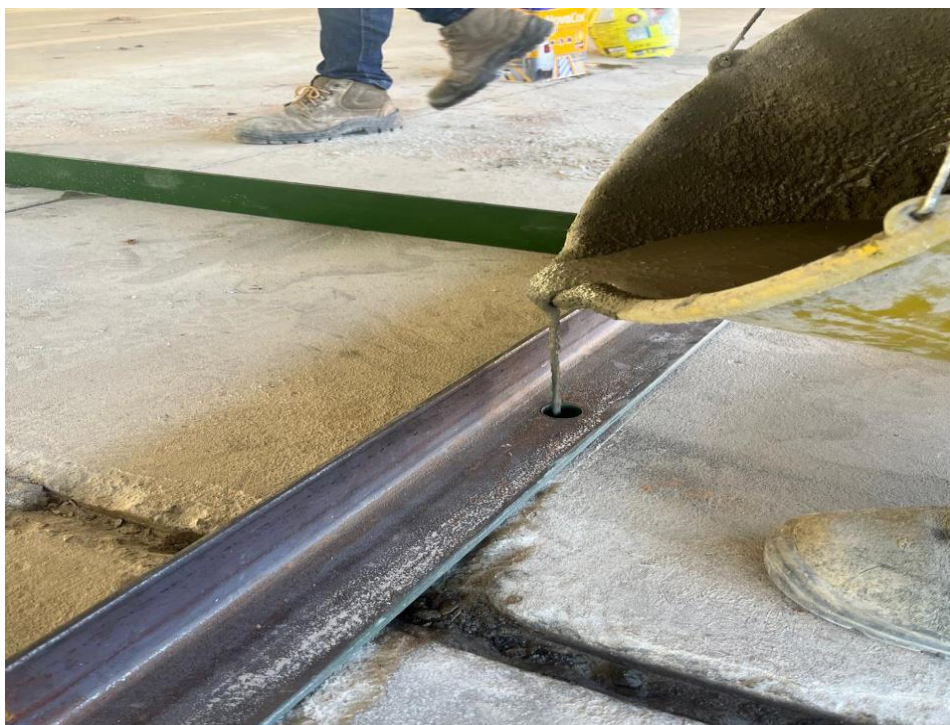
Figura 4- Detalhe para aplicação de graute na base de fixação das estruturas metálicas (torres)
