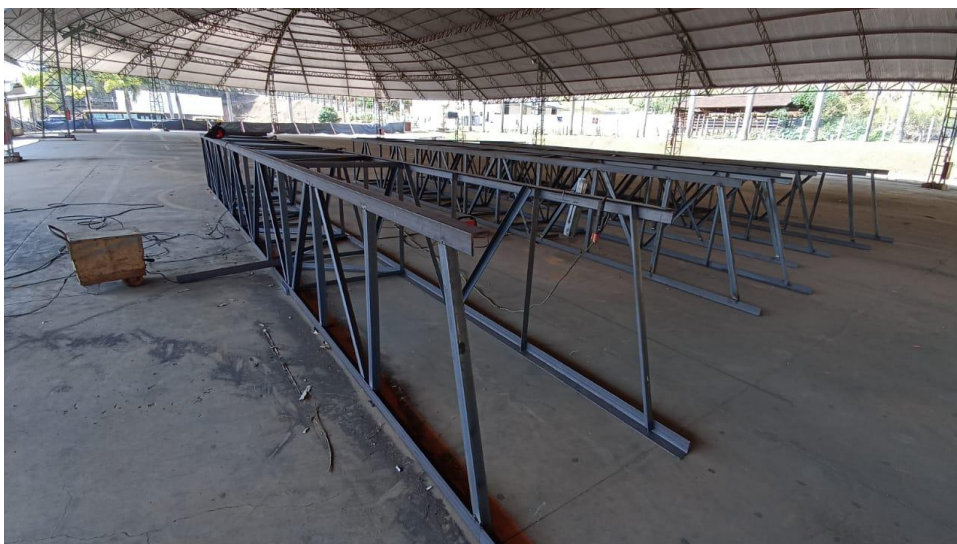
Figura 7 - Detalhe para montagem das estruturas metálica (torres)
