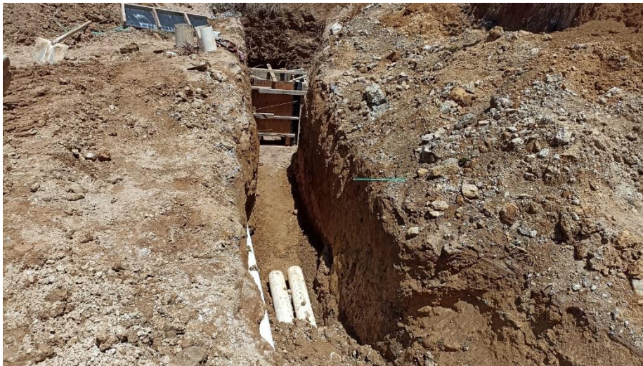
Figura 25 - Detalhe para escavação e tubulações drenagem águas pluviais
