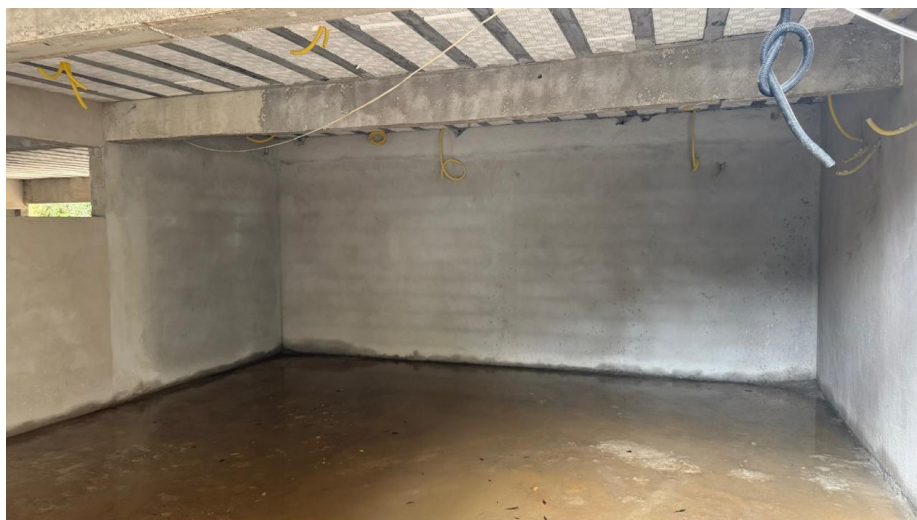
Figura 30 - Detalhe para reboco das paredes internas
