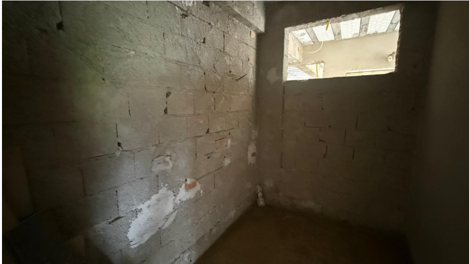
Figura 11 – Detalhe para chapisco das paredes
