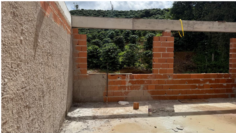
Figura 6 - Detalhe para alvenaria de vedação pavimento superior
