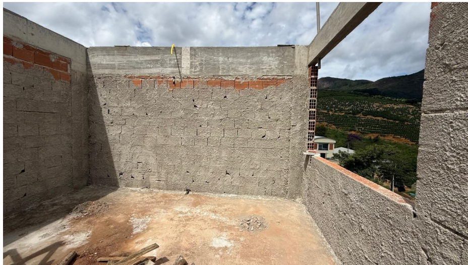
Figura 14 – Detalhe para chapisco das paredes
