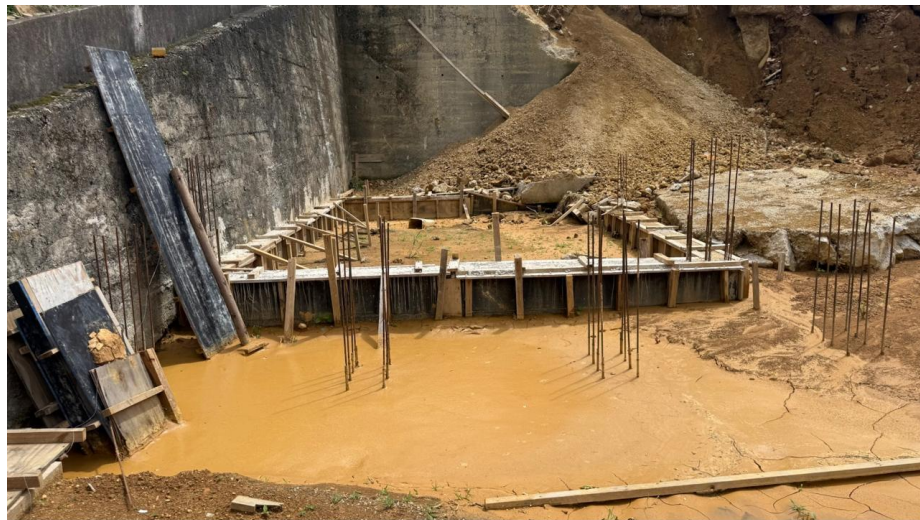
Figura 16 – Detalhe para vigas baldrame da casa de bombas
