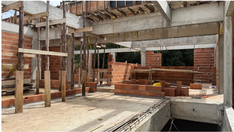
Figura 3 – Detalhe para alvenaria de vedação pavimento superior
