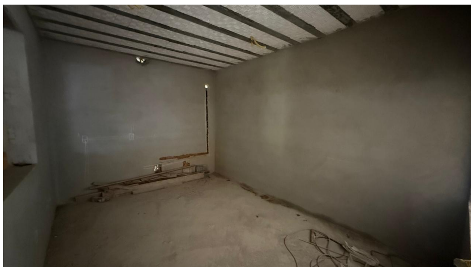
Figura 27 - Detalhe para reboco das paredes internas
