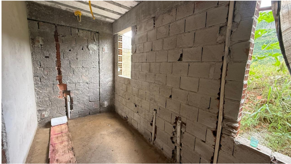
Figura 9 – Detalhe para chapisco das paredes
