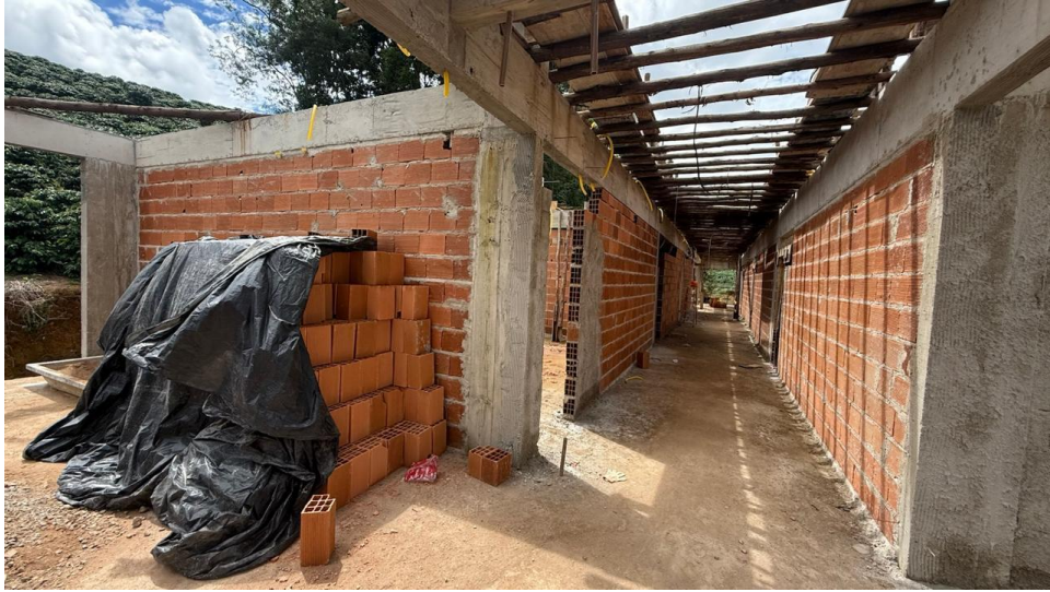
Figura 5- Detalhe para alvenaria de vedação pavimento superior
