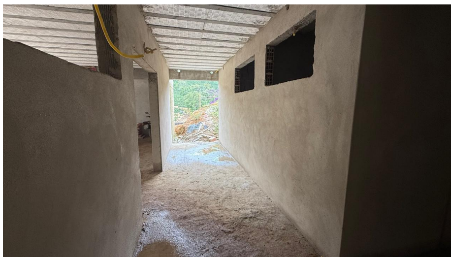
Figura 33 - Detalhe para reboco das paredes internas
