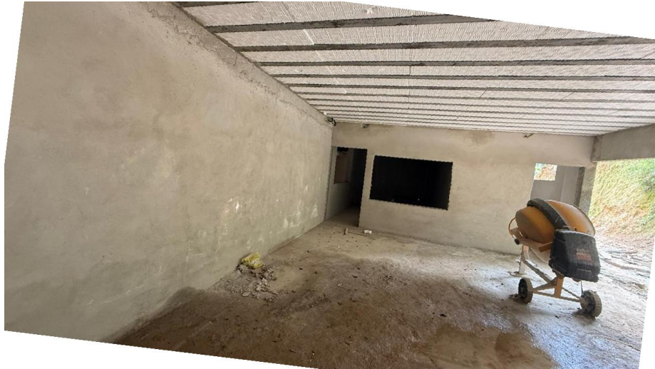
Figura 35 - Detalhe para reboco das paredes internas
