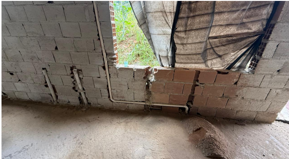
Figura 10 – Detalhe para chapisco das paredes
