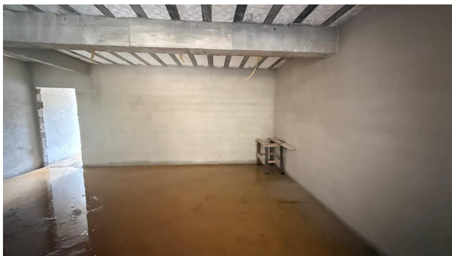
Figura 28 - Detalhe para reboco das paredes internas
