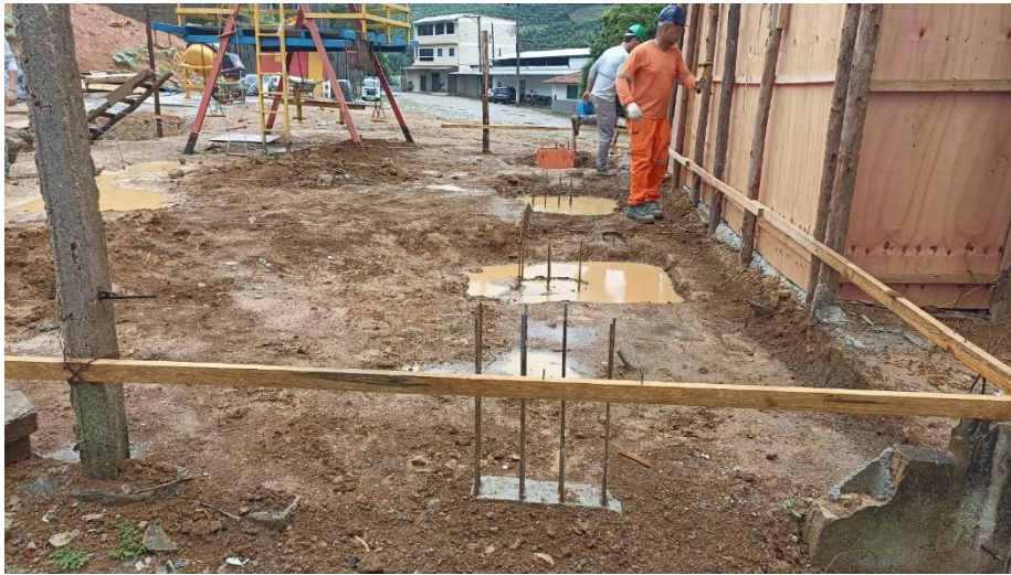
Figura 21 - Detalhe para escavação e elementos de fundação da rampa
