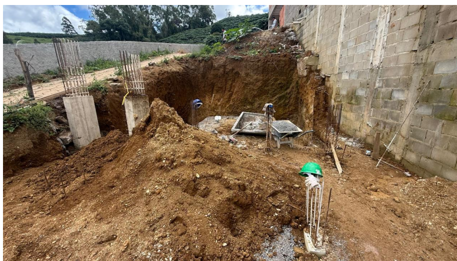
Figura 24 - Detalhe para escavação e elementos de fundação da rampa
