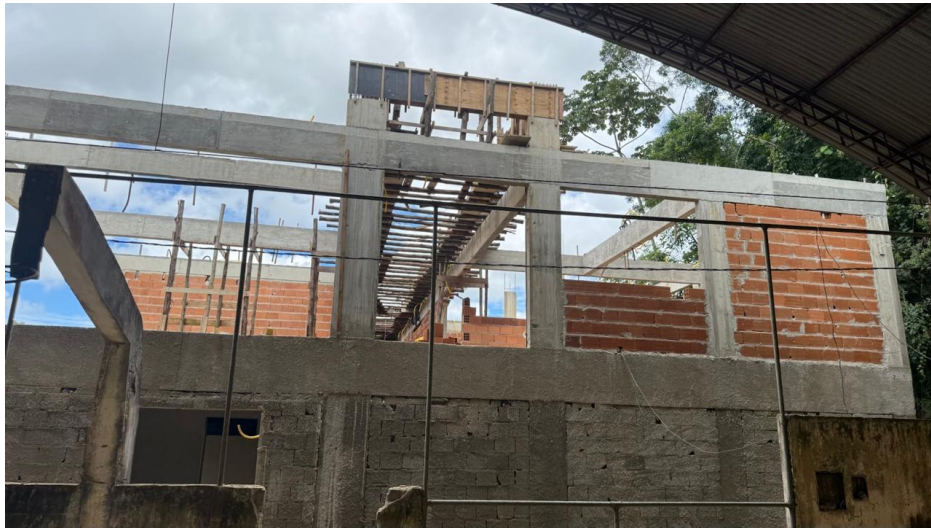
Figura 15 - Detalhe para chapisco das paredes e alvenaria de vedação
