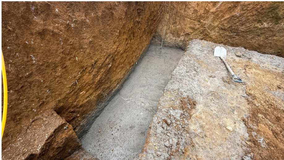
Figura 18 – Detalhe escavação e aplicação concreto magro da fundação do reservatório inferior
