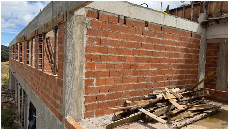
Figura 4- Detalhe para alvenaria de vedação pavimento superior
