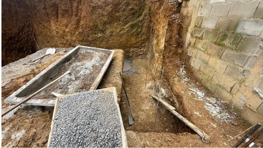
Figura 17 – Detalhe para escavação da fundação do reservatório inferior
