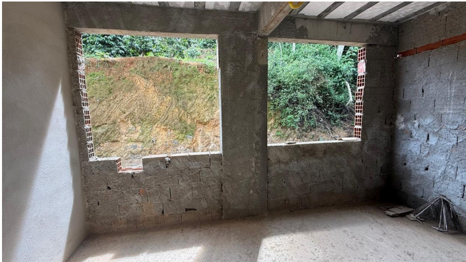
Figura 12 – Detalhe para chapisco das paredes
