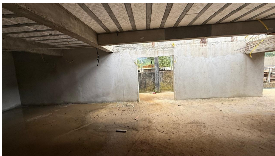
Figura 32 - Detalhe para reboco das paredes internas
