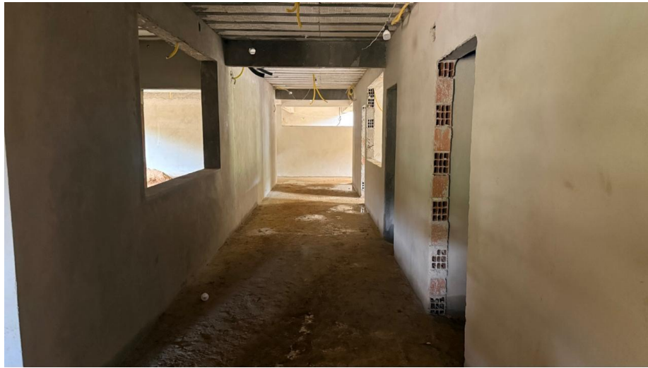
Figura 29 - Detalhe para reboco das paredes internas
