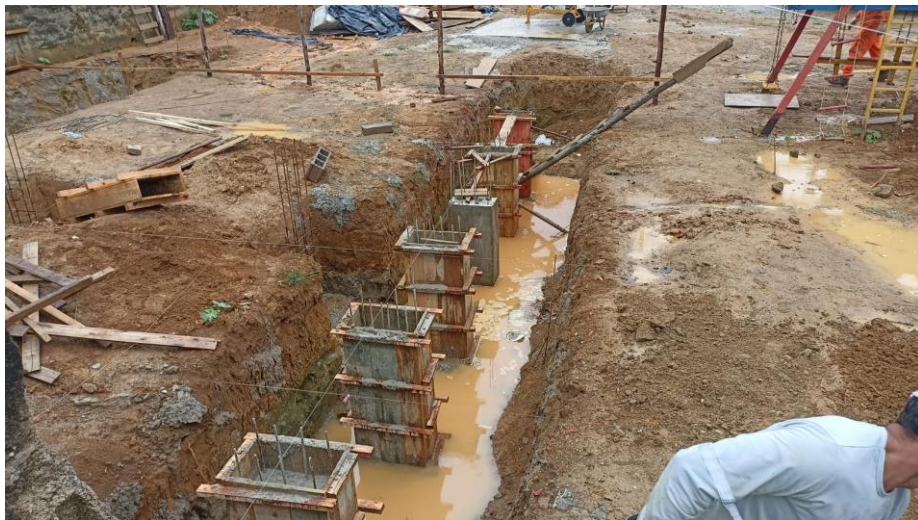
Figura 20 - Detalhe para escavação e elementos de fundação da rampa
