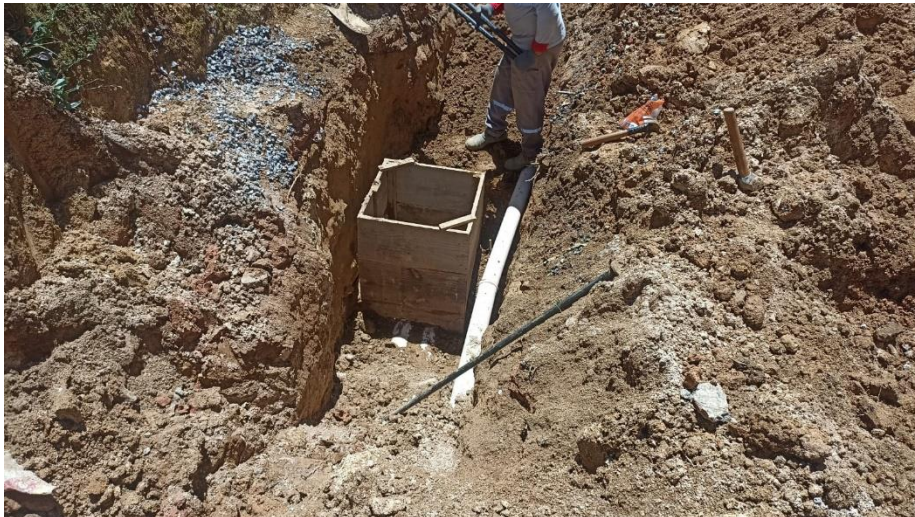
Figura 26 - Detalhe para escavação e tubulações drenagem águas pluviais
