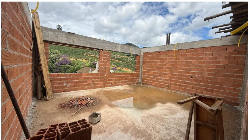
Figura 8 - Detalhe para alvenaria de vedação pavimento superior
