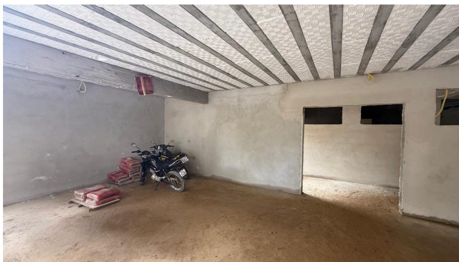
Figura 31 - Detalhe para reboco das paredes internas
