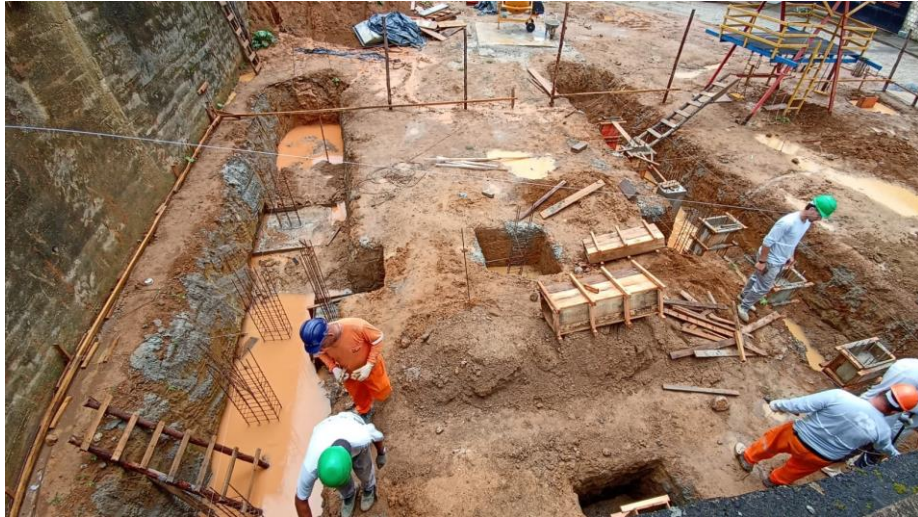
Figura 19 - Detalhe para escavação e elementos de fundação da rampa
