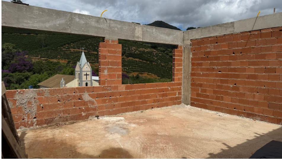
Figura 7 - Detalhe para alvenaria de vedação pavimento superior
