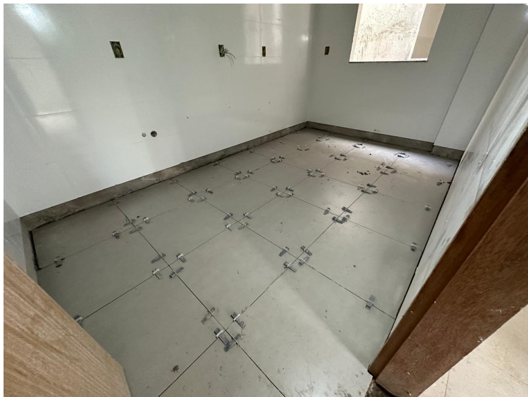
Execução de revestimento em paredes e piso
