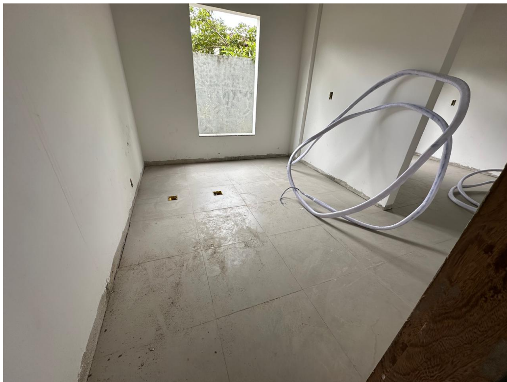
Execução de emassamento de paredes
