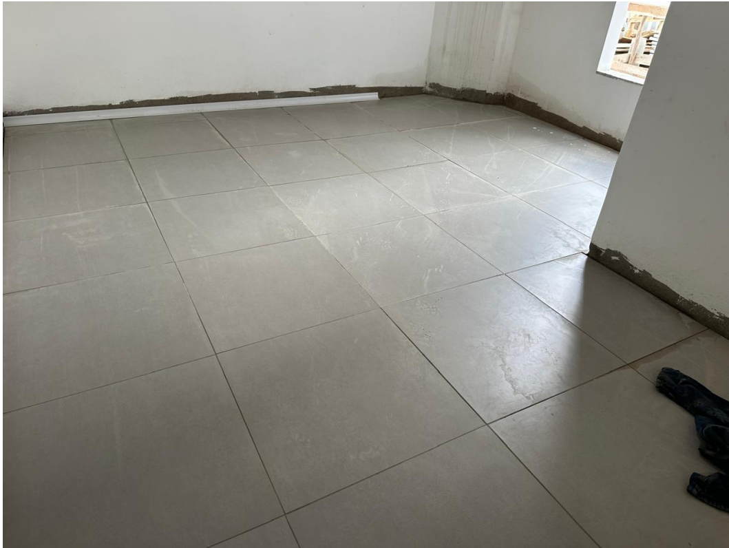
Execução de revestimento em piso
