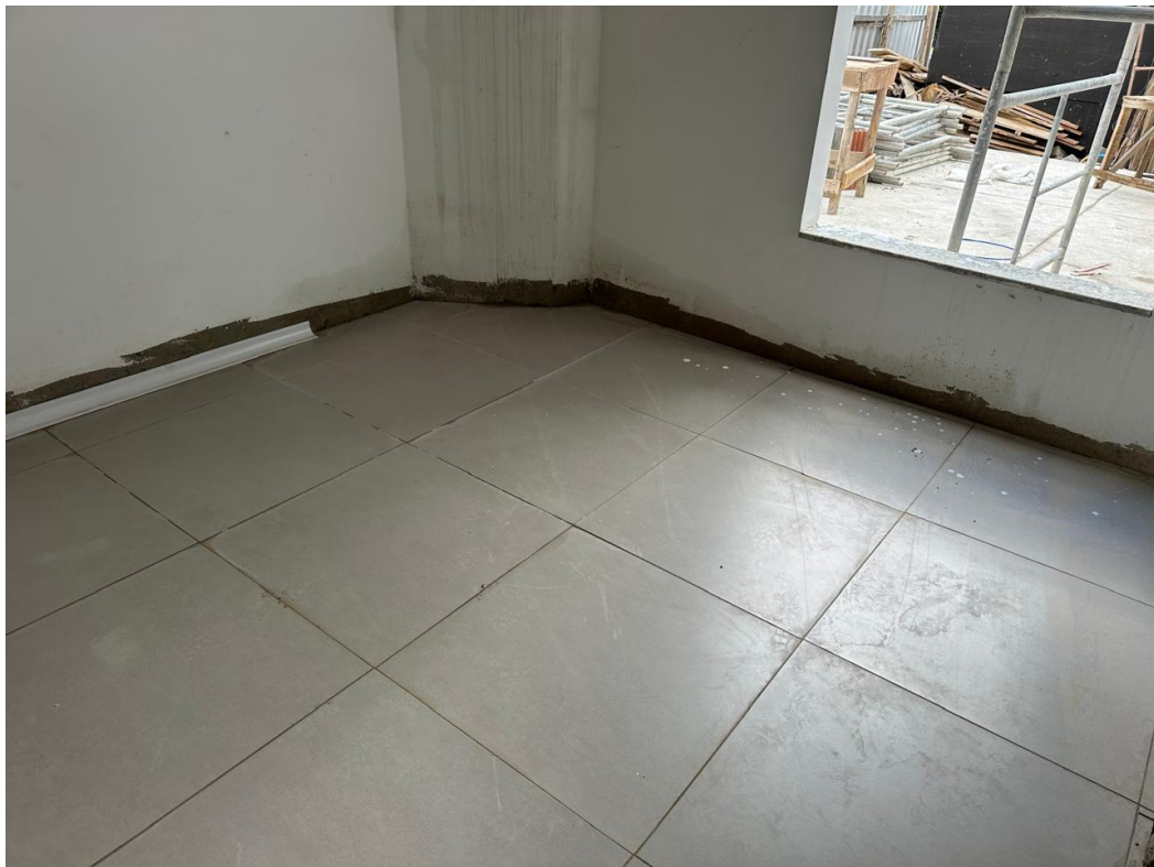
Execução de revestimento em piso
