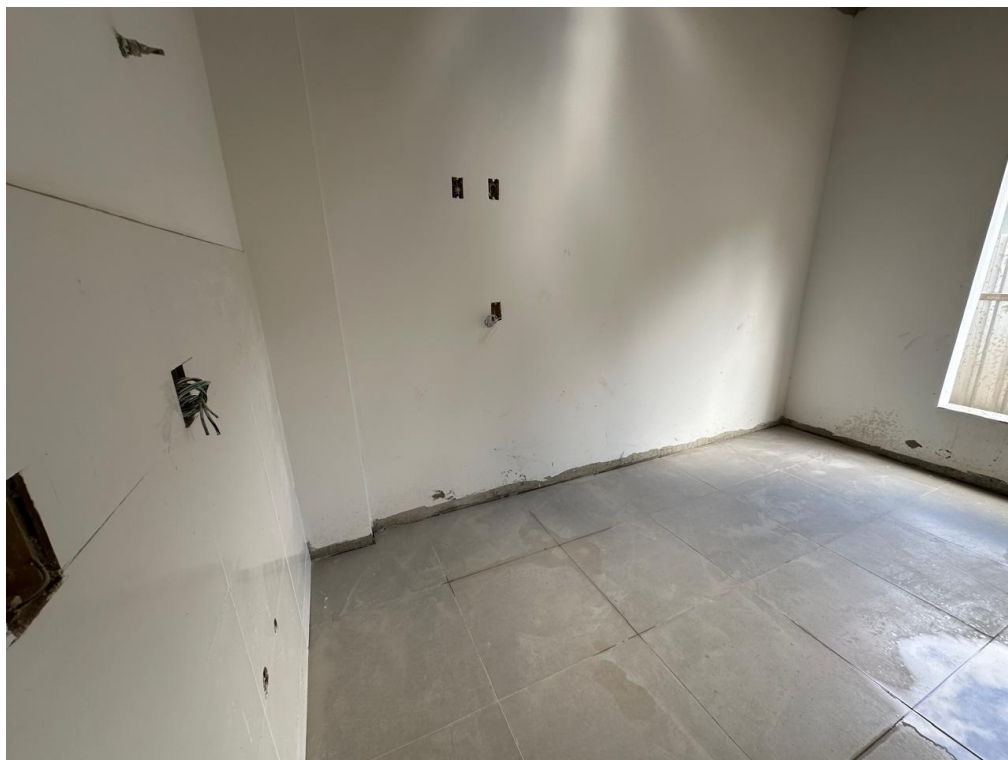
Execução de revestimento em piso, emassamento de paredes e instalações elétricas
