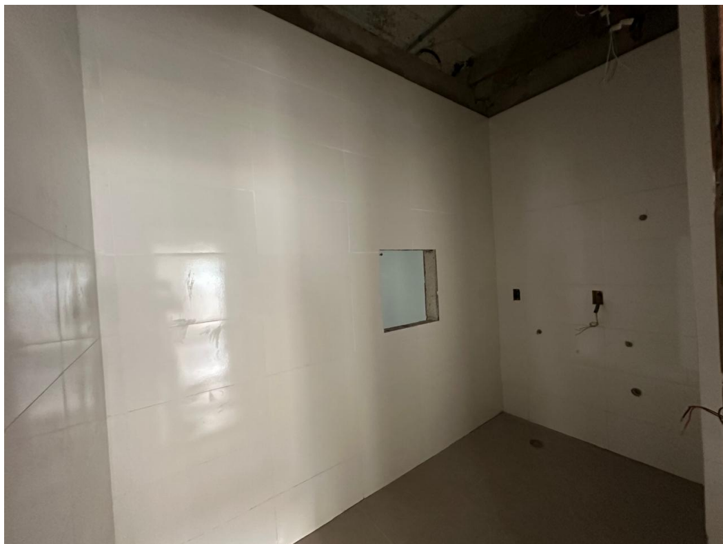
Execução de revestimento em paredes e piso
