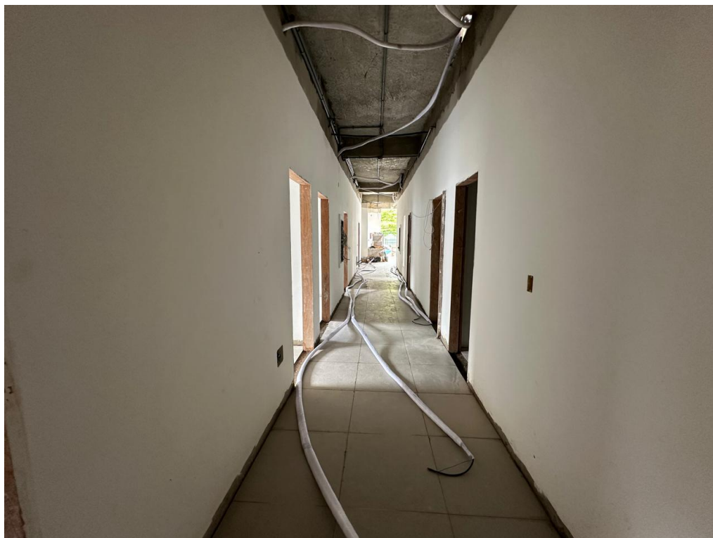
Execução de emassamento de paredes e instalações elétricas
