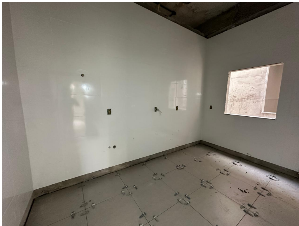
Execução de revestimento em paredes e piso
