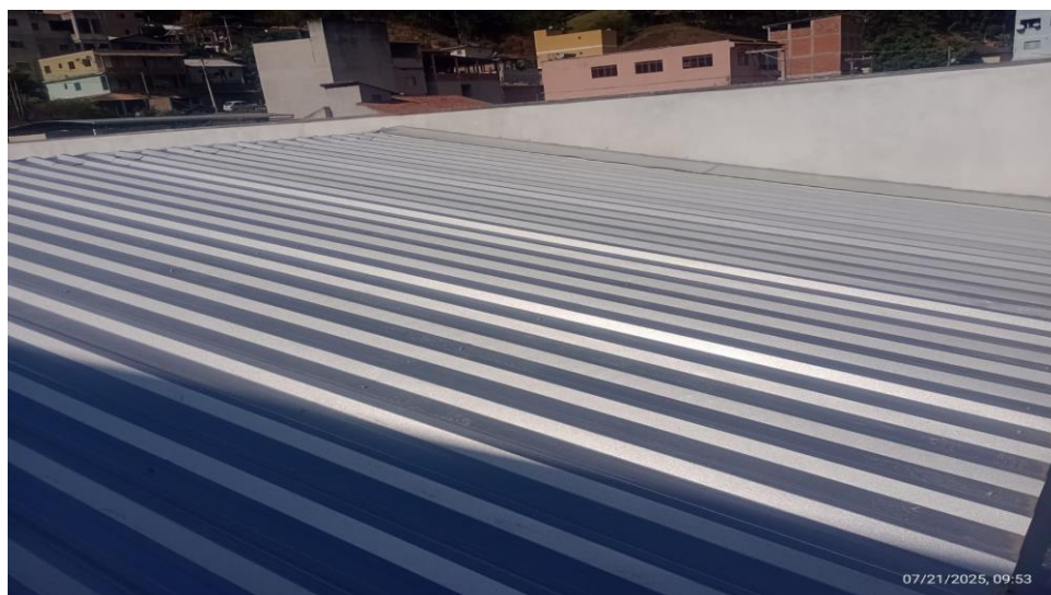
Figura 6 - Detalhe para telhamento em aço – cobertura
