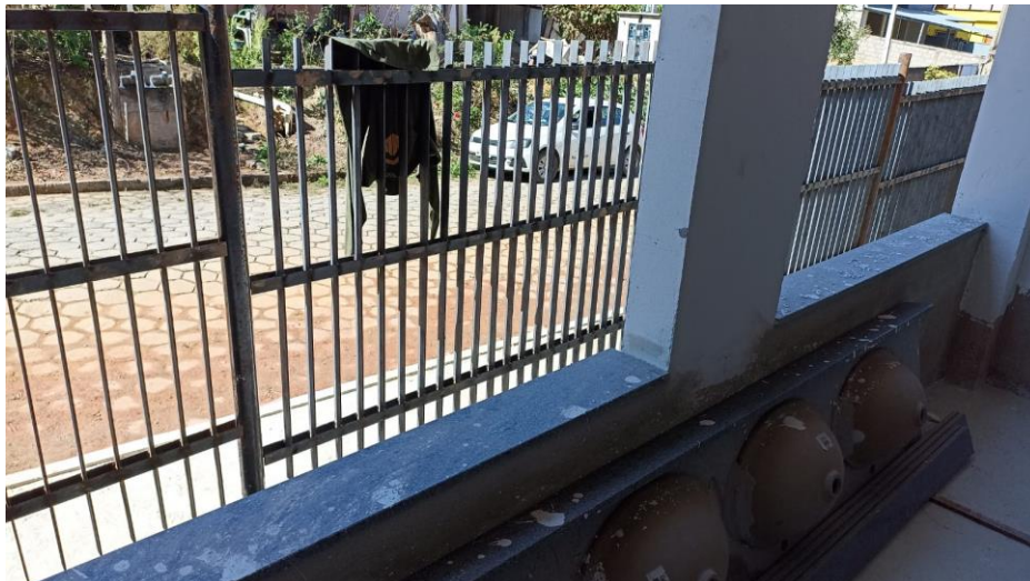
Figura 2 – Detalhe para soleiras das janelas – pavimento superior
