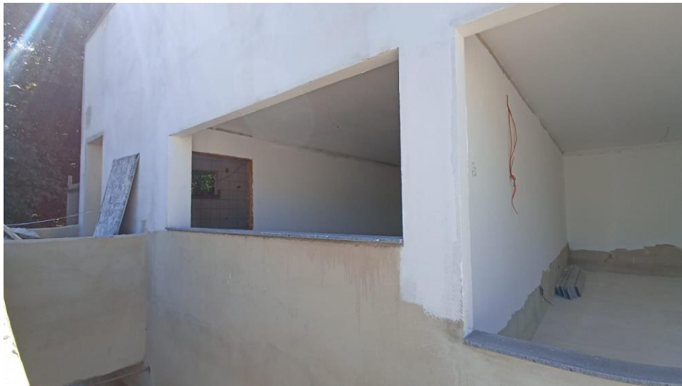
Figura 3 – Detalhe para soleiras das janelas – pavimento superior
