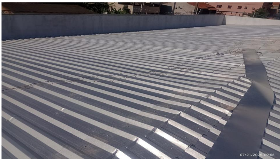
Figura 7 - Detalhe para telhamento em aço – cobertura
