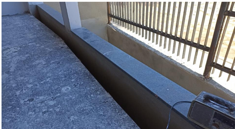
Figura 1 – Detalhe para soleiras das janelas – pavimento superior
