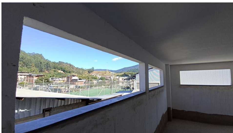
Figura 5 - Detalhe para soleiras das janelas – pavimento superior
