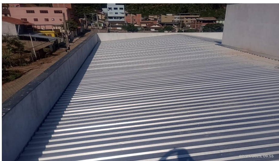
Figura 8 - Detalhe para telhamento em aço e chapim das platibandas – cobertura
