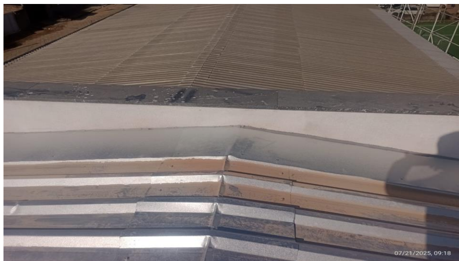
Figura 10 - Detalhe para rufo e chapim das platibandas – cobertura
