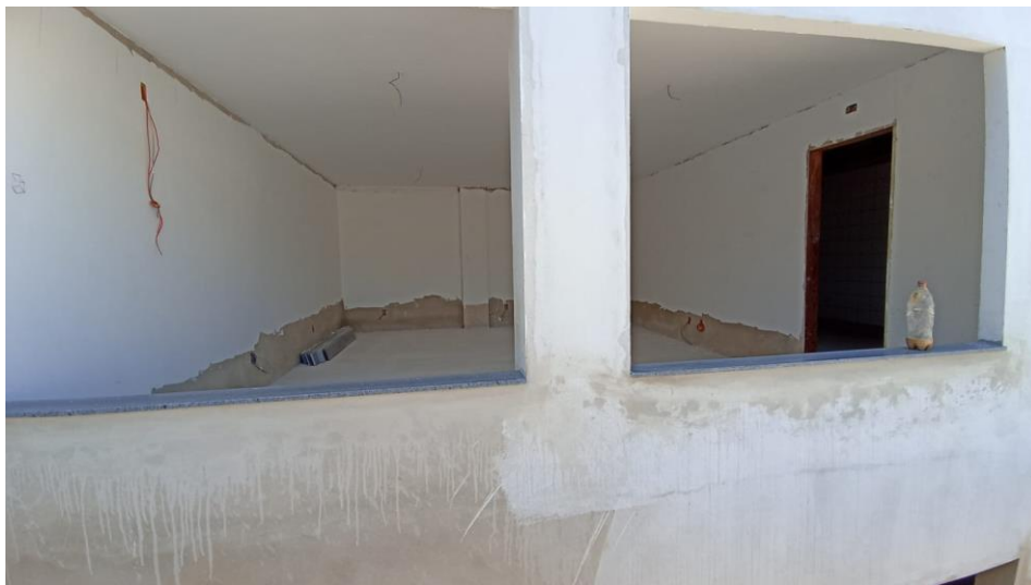
Figura 4 – Detalhe para soleiras das janelas – pavimento superior
