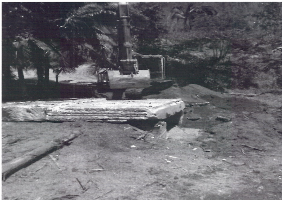
Anexo 07: Instalação de Caixa secas, manutenção, ponte e aplicação do Revsol em São Bento das Pedras
