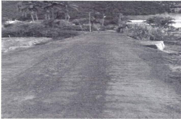
Anexo 18: Manutenção estrada e instalação ponte na localidade de Mata fria
