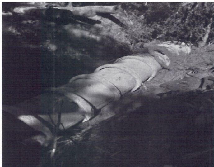
Anexo 19: Manutenção da estrada e instalação de manilha Localidade Boa esperança
