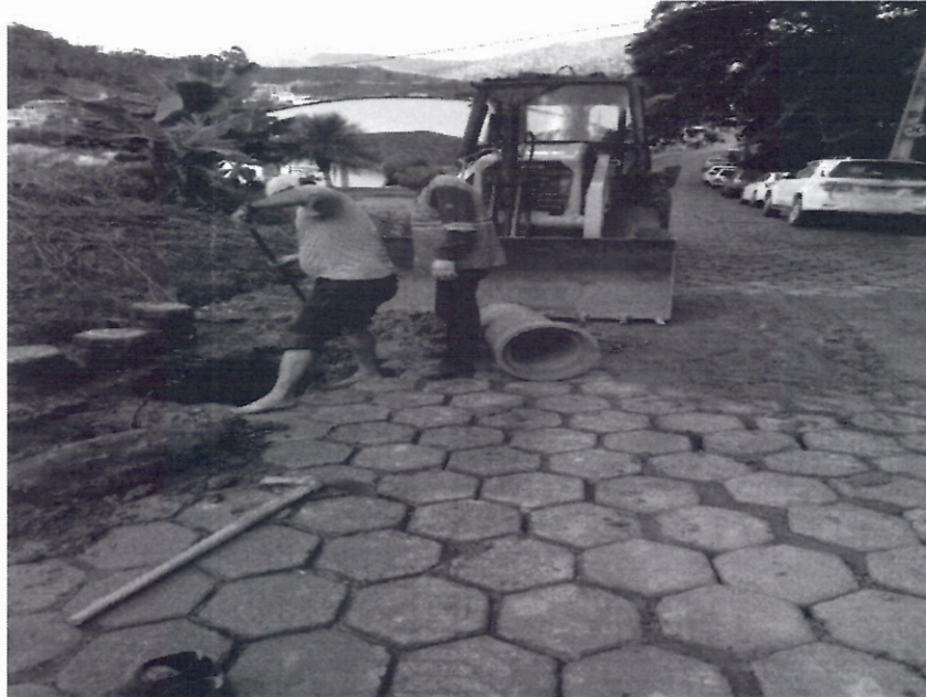
Anexo 09: Manutenção bueiro na localidade Estreito
