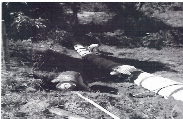
Anexo 14: Instalação de manilhas no bairro Paraíso
