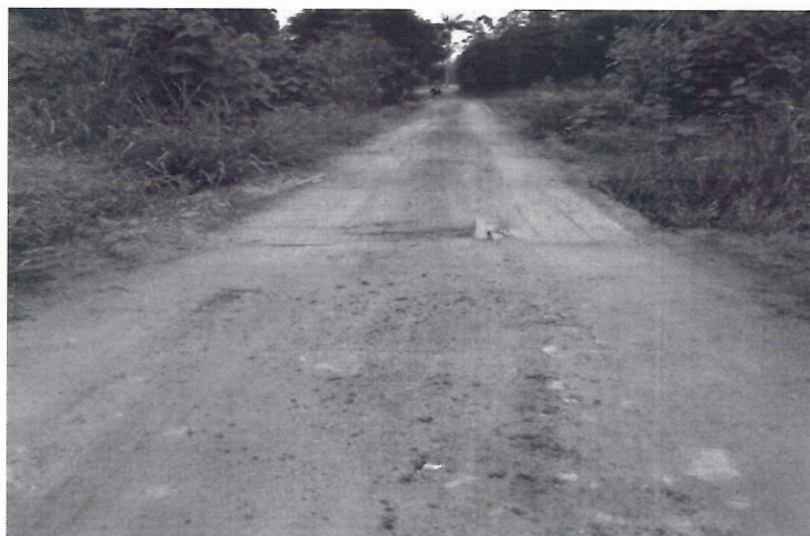
Anexo 11: Manutenção ponte localidade Ribeirão do Meio
