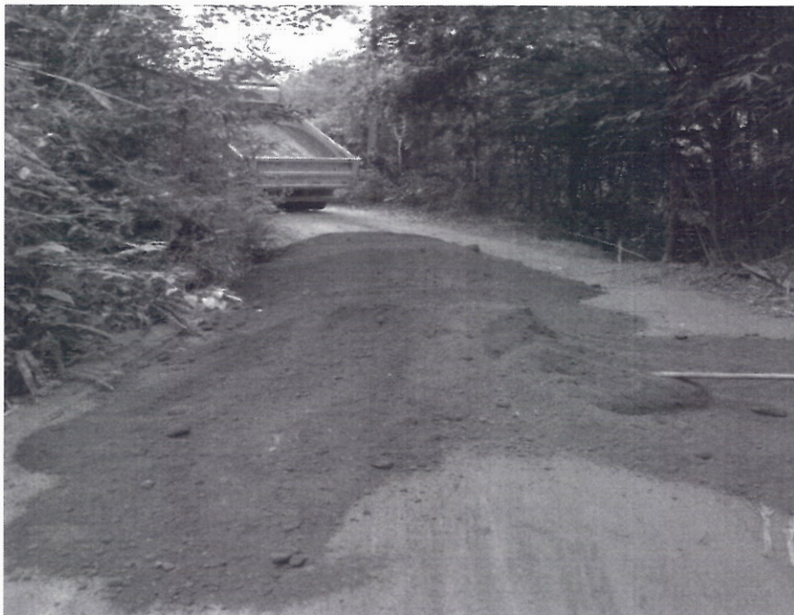
Anexo 02: Concerto das estradas, aplicação do REVSOL Cantinho do Céu
