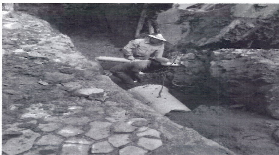
Anexo 08: Instalação de bueiro Rua Antônio Belisario
