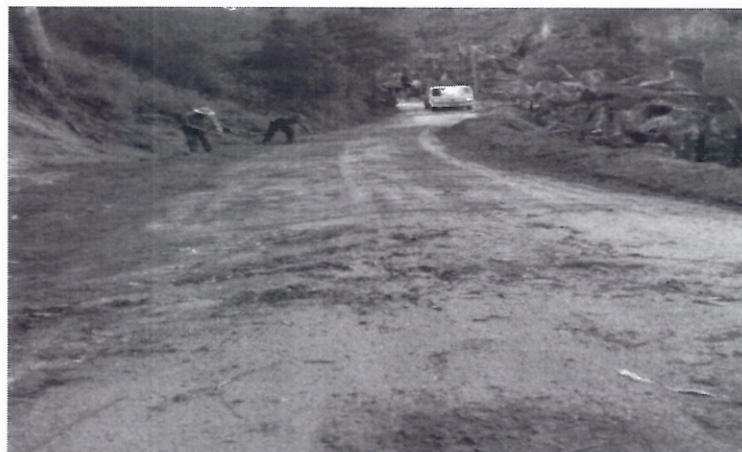
Anexo 15: Manutenção estradas e instalação de manilhas localidade da Pingadeira
