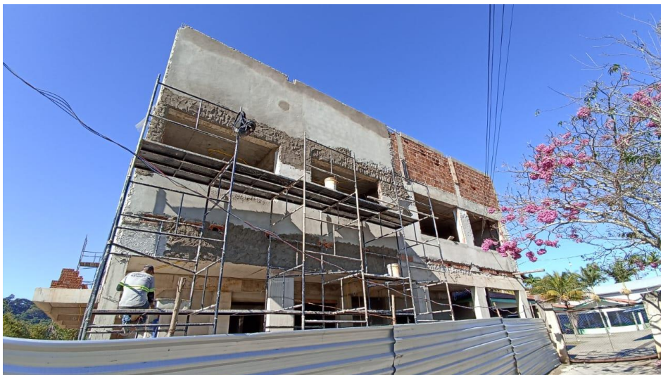
Figura 3 - Detalhe para execução de reboco paredes platibandas
