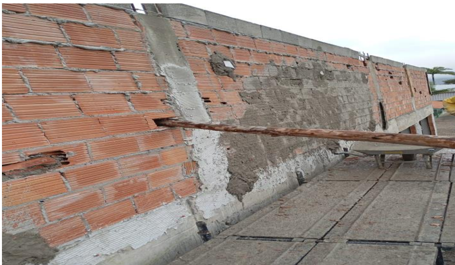
Figura 1 - Detalhe para execução chapisco para recebimento do emboço das platibandas
