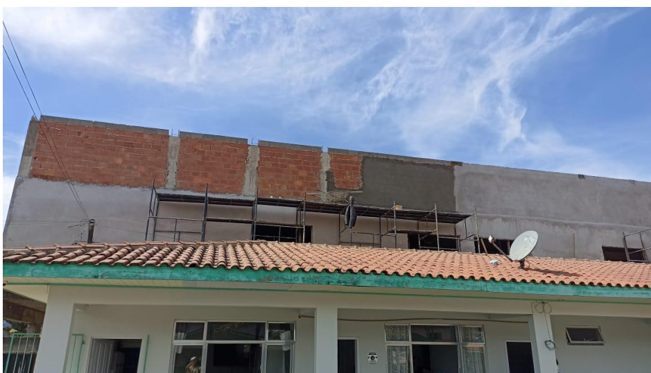
Figura 4 - Detalhe para execução de reboco paredes platibandas
