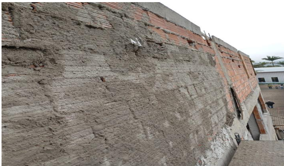
Figura 2 - Detalhe para execução de emboço das platibandas
