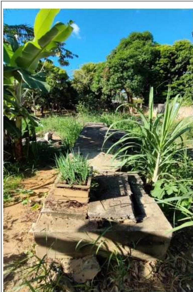
*Figura 60: Tratamento preliminar (gradeamento + caixa de areia)*
