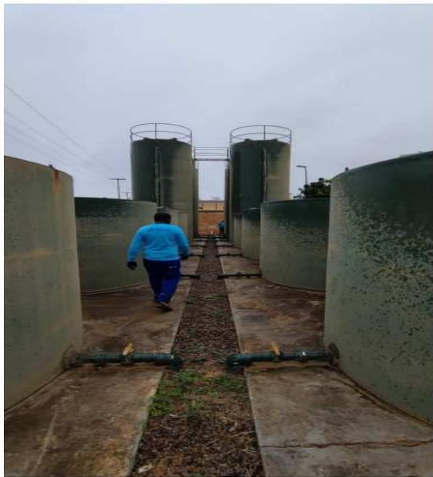
*Figura 55: Tratamento biológico (reator UASB + biofiltro aerado submerso + filtro anaeróbio + decantadorsecundário)*
