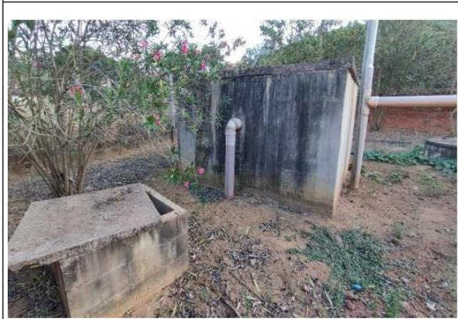
*Figura 59: Tratamento biológico (filtro anaeróbio)*
