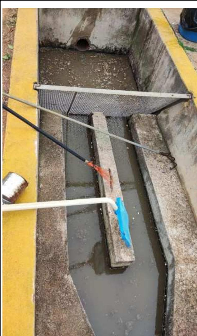
*Figura 53: Tratamento preliminar (gradeamento + caixa de areia)*
