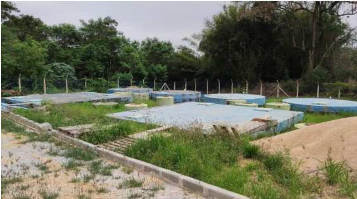
*Figura 41: Ete Luiz Iglesias - Tratamento biológico (tanque séptico + filtro anaeróbio)*
