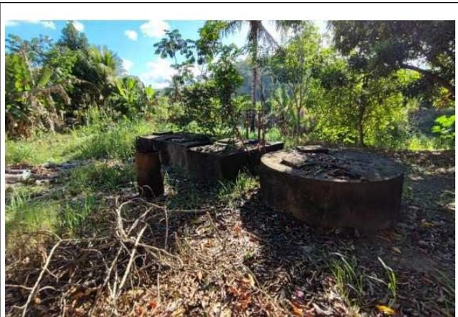
*Figura 61: Tratamento biológico (tanque séptico + filtro anaeróbio)*
