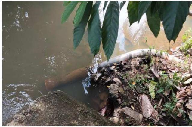
*Figura 66: Lançamento de efluente tratado no corpo receptor*
