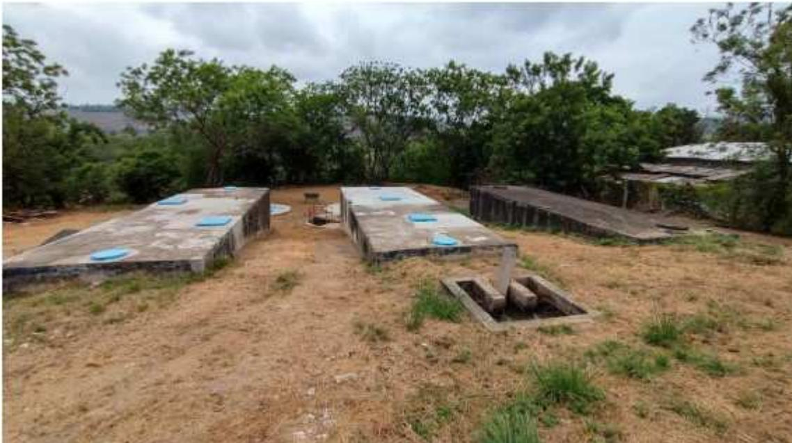
*Figura 37: ETE Columbia - Tanques sépticos*
