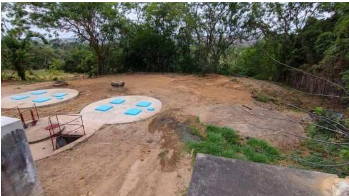
*Figura 38: ETE Columbia - Filtros anaeróbios*
