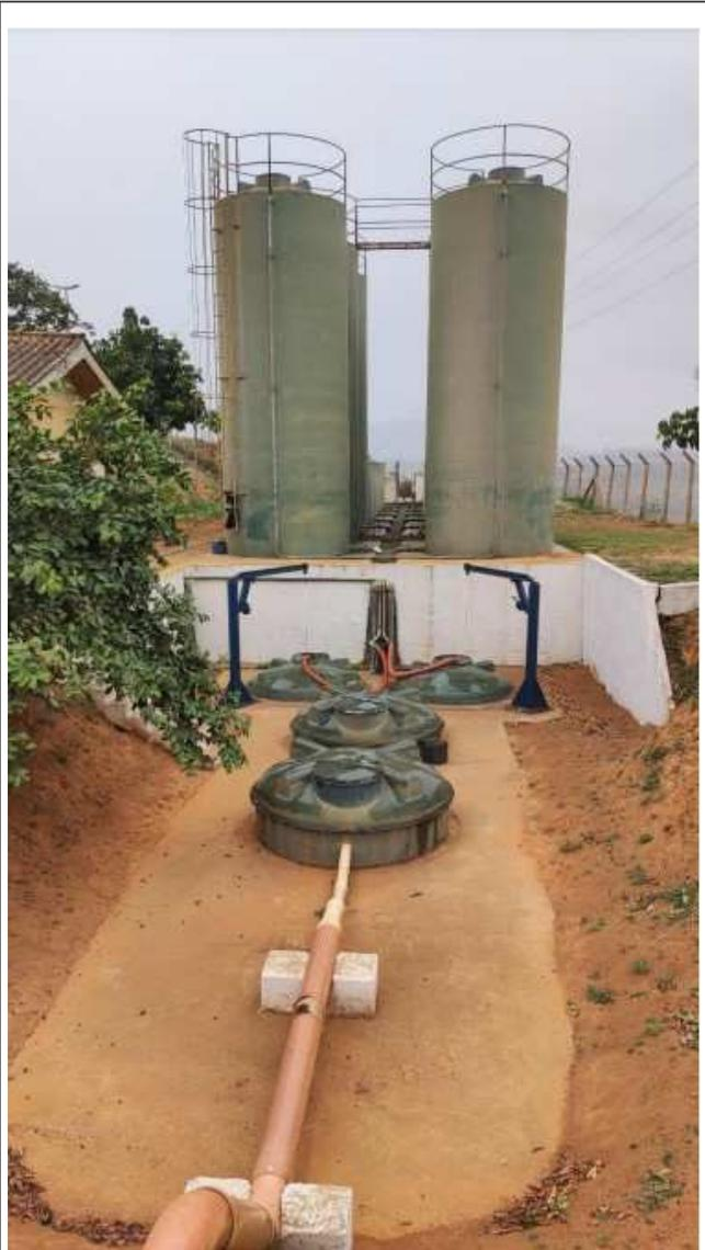
*Figura 54: Tratamento biológico (reator UASB + biofiltro aerado submerso + filtro anaeróbio + decantador secundário)*
