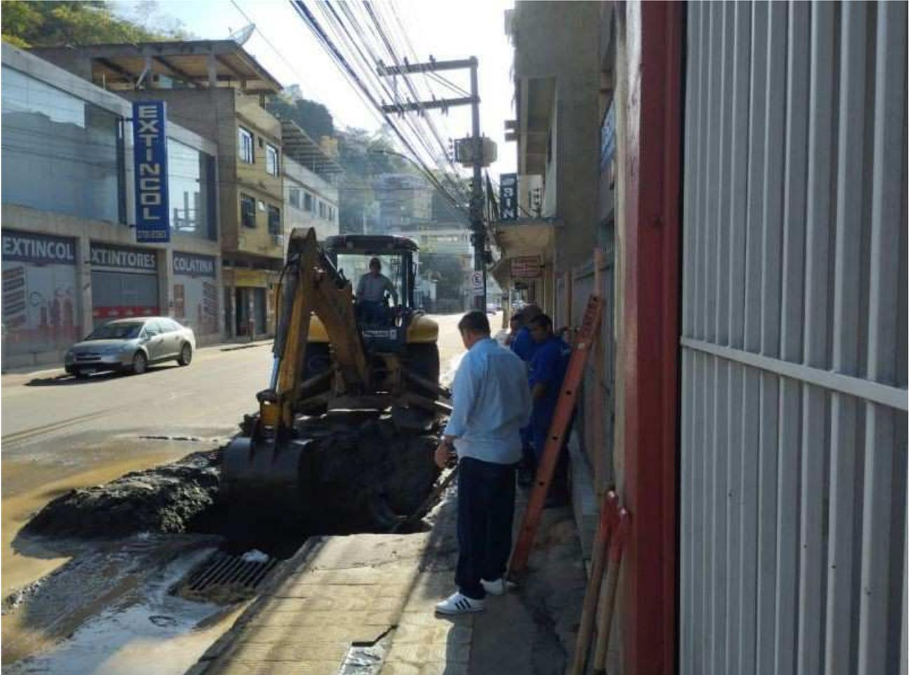
*Figura 22: a equipe do SANEAR realizou uma manutenção emergencial na rede de abastecimento de água do bairro São Silvano. Esta medida foi necessária devido a um rompimento na tubulação que está localizada na Av. Sílvio Ávidos, mais precisamente nas imediações da loja Tadeu Veículos. Os técnicos estiveram no local juntamente com o Diretor- Geral do SANEAR. Diante da situação, a Av. Sílvio Ávidos (uma pequena extensão) foi interditada parcialmente para a realização dos serviços.*
