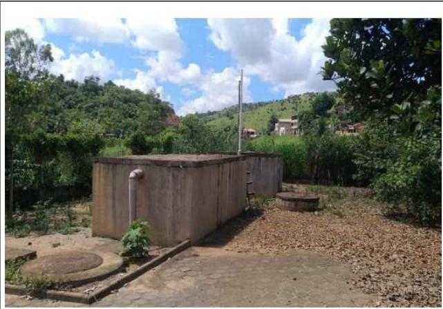
*Figura 58: Tratamento biológico (tanque séptico)*
