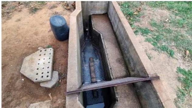
*Figura 46: Tratamento preliminar (gradeamento + caixa de areia)*
