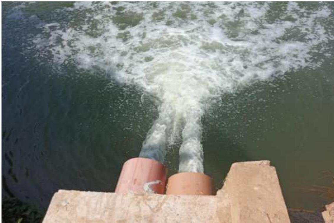
*Figura 34: ETE Barbados - Lançamento do efluente tratado no corpo receptor*
