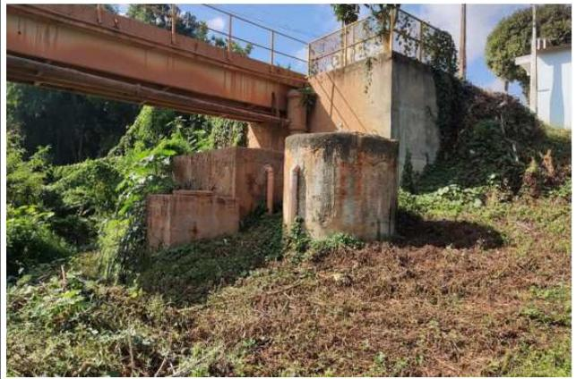
*Figura 68: Tratamento biológico (tanque séptico + filtro anaeróbio)*
