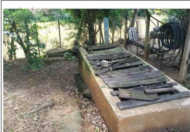
*Figura 57: Tratamento preliminar (gradeamento + caixa de areia)*
