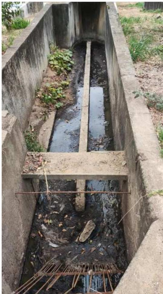
*Figura 36: ETE Columbia - Tratamento preliminar (gradeamento + caixa de areia)*
