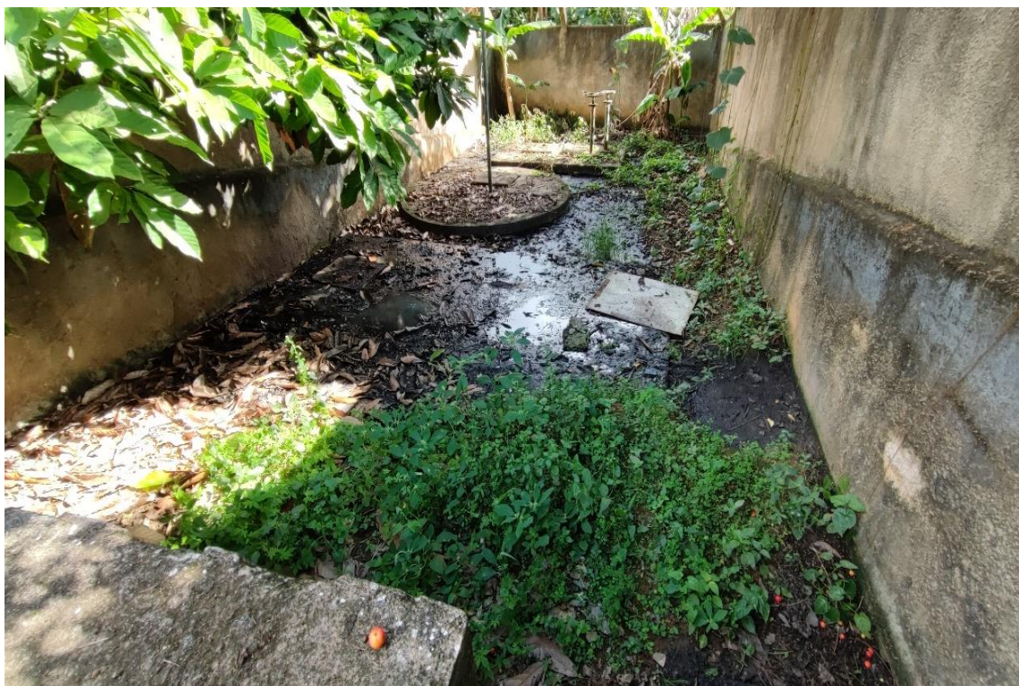
Figura 38: Tratamento biológico (tanque séptico + filtro anaeróbio)
