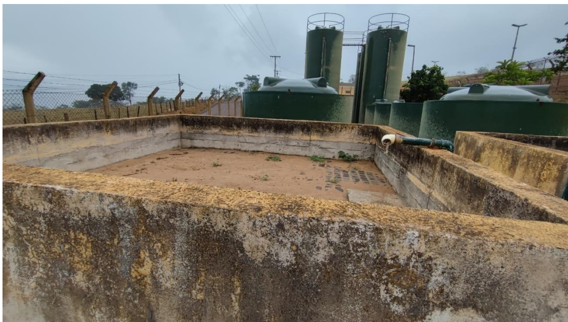
Figura 29: Leito de secagem
