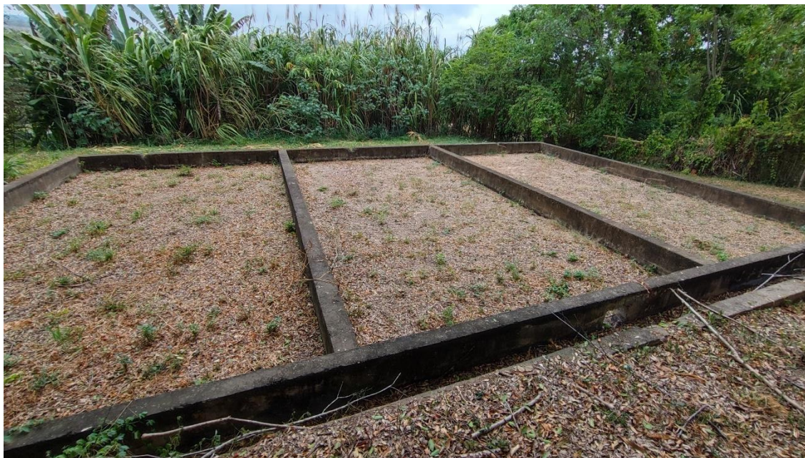
Figura 11: Leito de secagem
