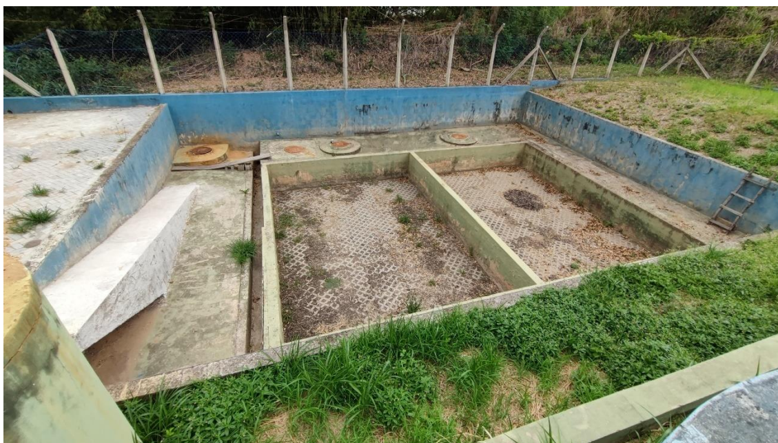
Figura 14: Leito de secagem
