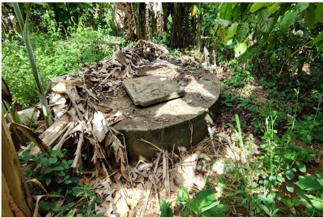
Figura 37: Tratamento biológico (tanque séptico + filtro anaeróbio)
