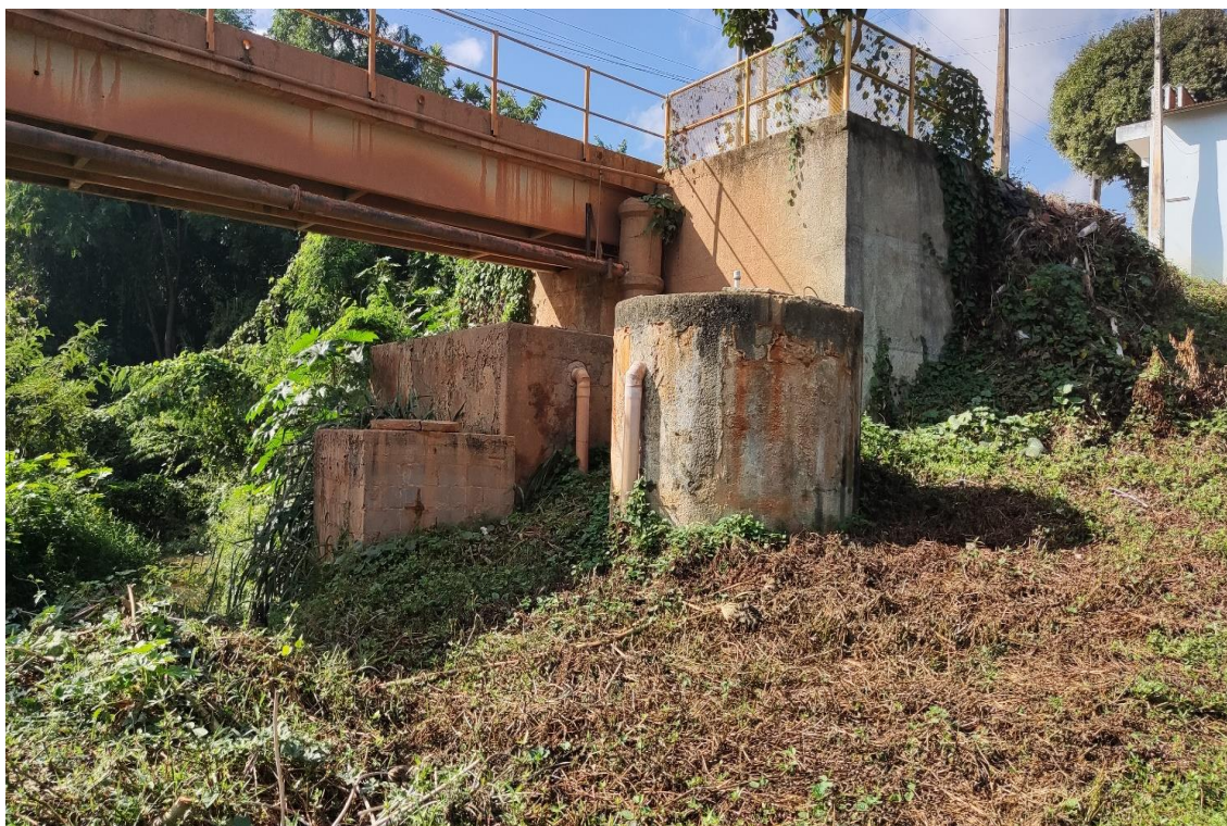
Figura 41: Tratamento biológico (tanque séptico + filtro anaeróbio)
