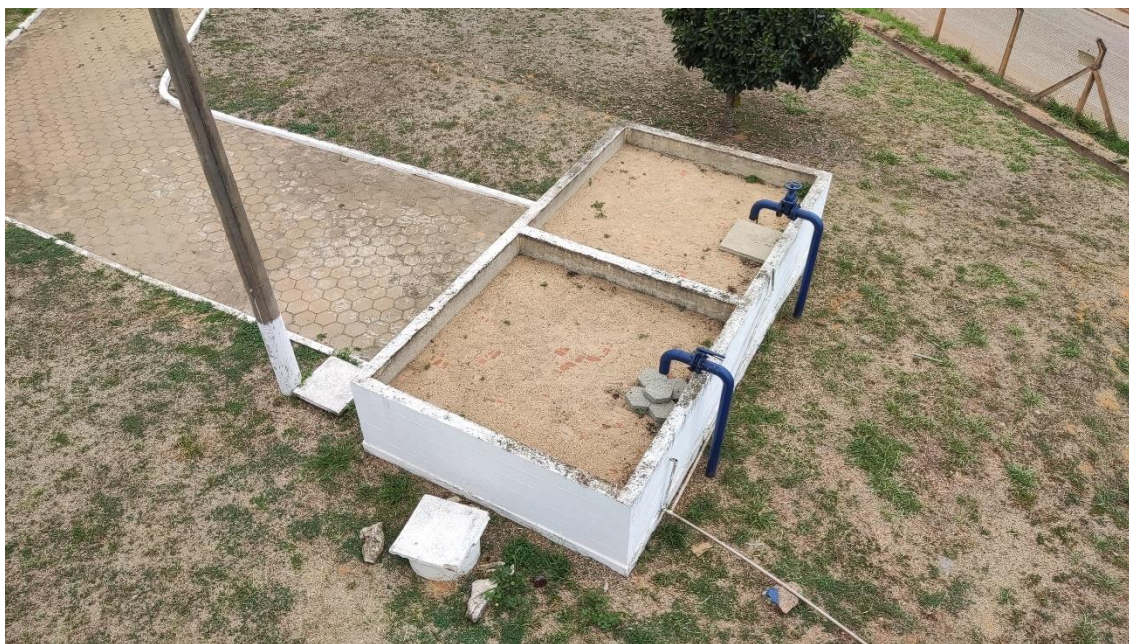
Figura 22: Leito de secagem
