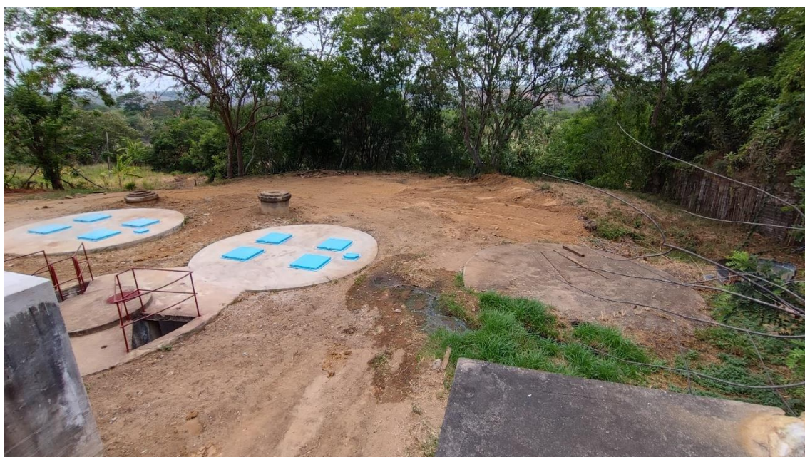
Figura 10: Filtros anaeróbios
