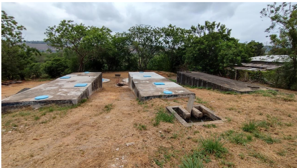
Figura 09: Tanques sépticos
