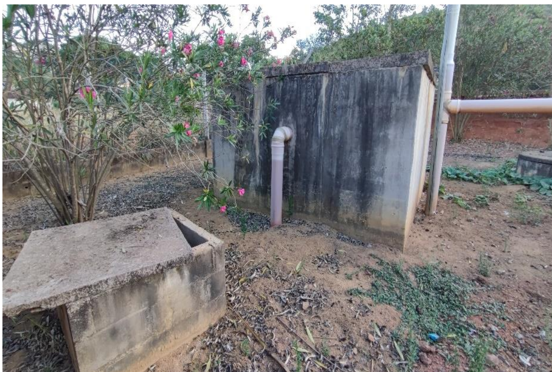
Figura 32: Tratamento biológico (filtro anaeróbio)
