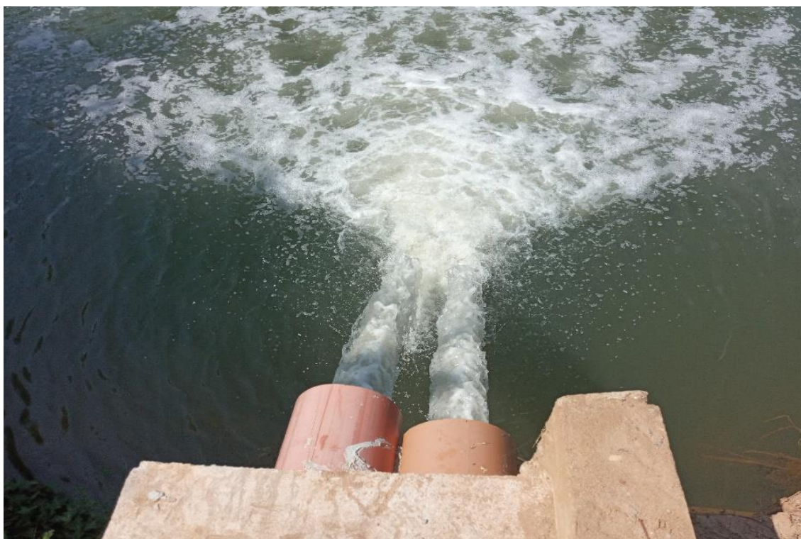
Figura 06: Lançamento do efluente tratado no corpo receptor
