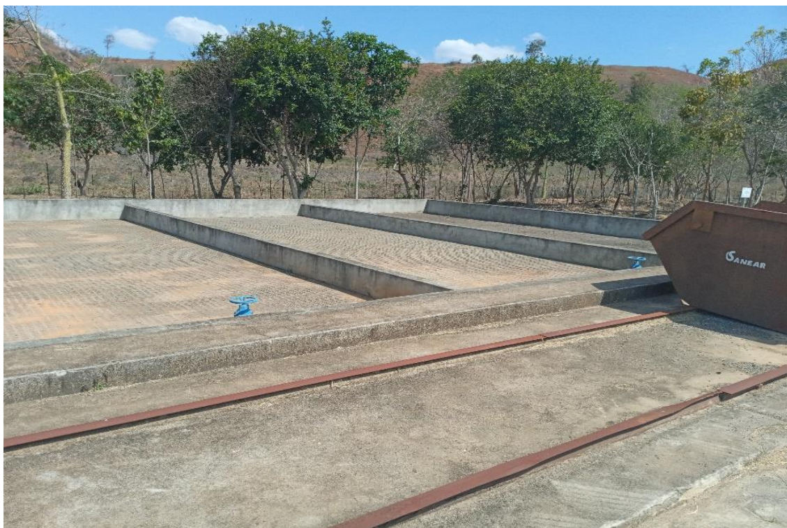
Figura 05: Leito de secagem
