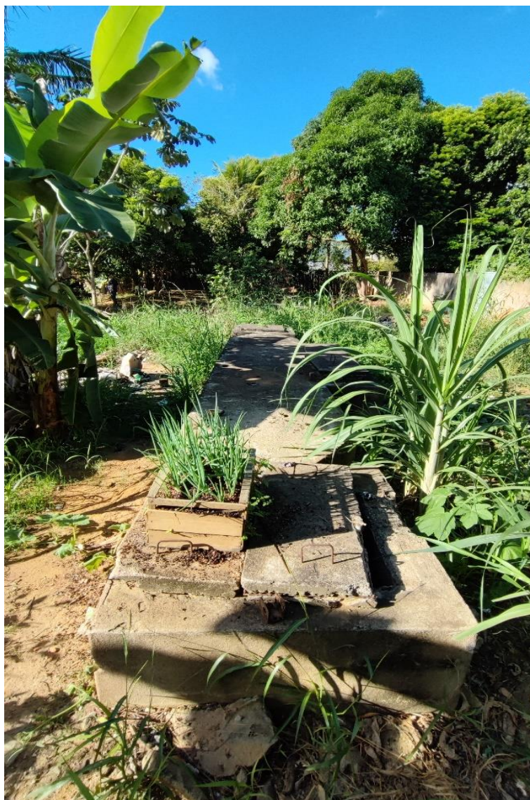
Figura 33: Tratamento preliminar (gradeamento + caixa de areia)
