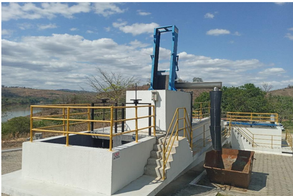
Figura 01: Gradeamento
