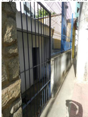
Figura 16 - EEAT Vila Lenira.
