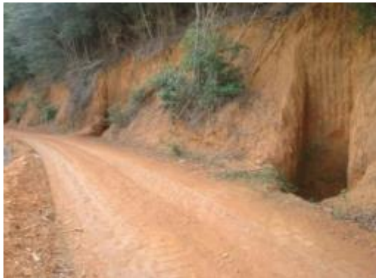
Figura 6.14 - Caixas secas implantadas em estrada vicinal no município de São Roque do Canaã - ES.
