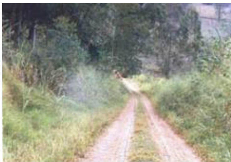
Figura 6.15 - Taludes de corte e aterro e áreas não transitáveis recobertos com espécies herbáceas em estrada vicinal.
