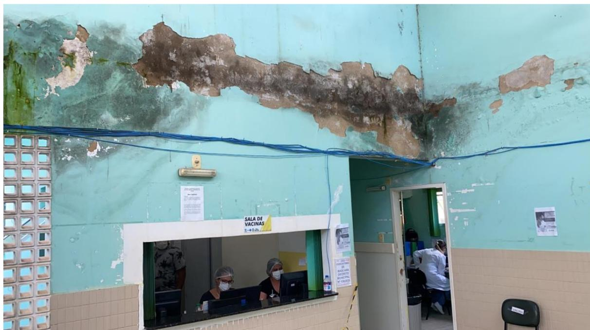
Figura 10. Infiltração na sala de vacinação (UBS Adilão Almeida de Lima – Ibatiba)
