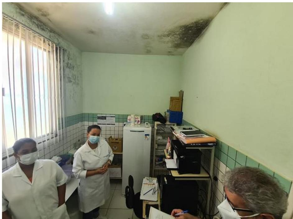
Figura 19. Teto com infiltração e mofo na sala de vacinação (Unidade de saúde da família US3 - Apiacá)
