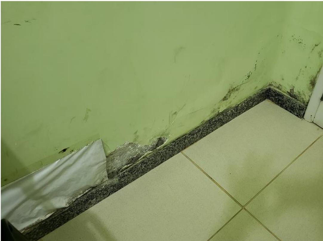
Figura 29. Mofo nas paredes (UBSF Walchimar Santos - Rio Novo do Sul)
