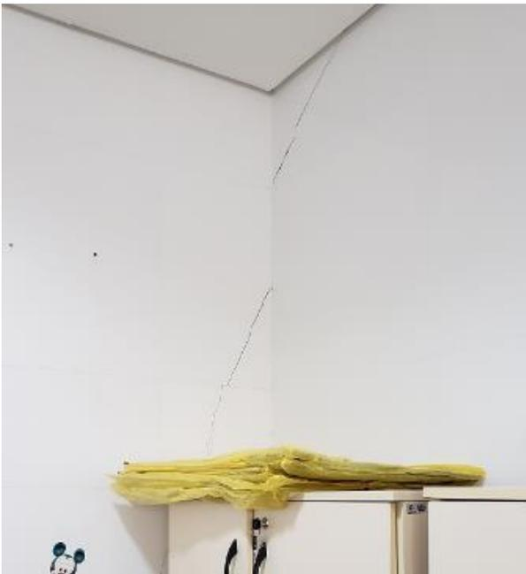
Figura 27. Rachadura nas parede e noteto (sala de vacinação do Centro Municipal de Saúde - Guarapari)
