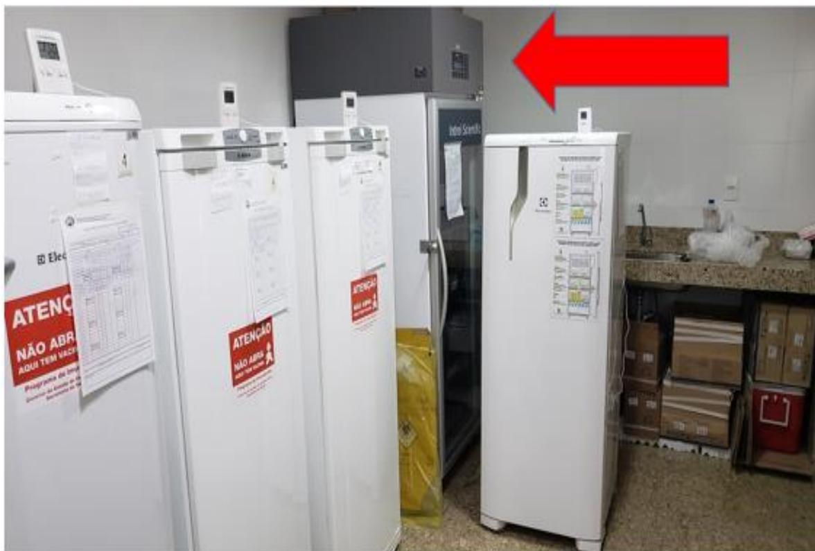
Figura 6. Câmara refrigerada sem utilização há 7 anos por falta de manutenção (Rede de Frios no Centro Municipal de Saúde - Guarapari)
