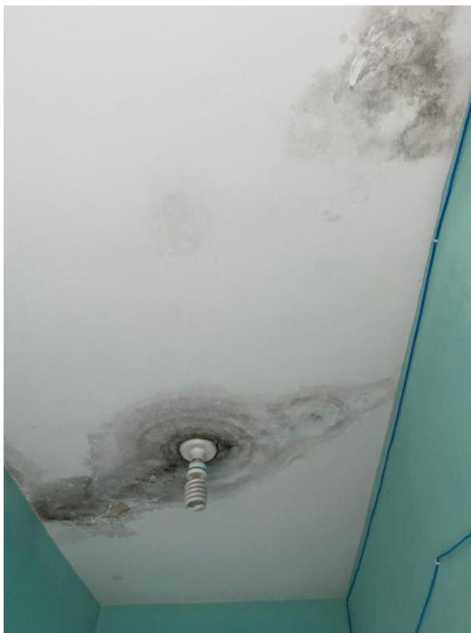
Figura 11. Infiltração na parte elétrica (UBS Adilão Almeida de Lima no município - Ibatiba).
