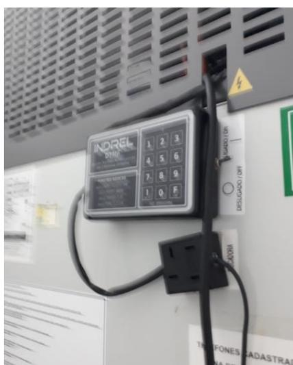
Figura 64. Discadora instalada em câmara de refrigeração (Rede de Frio - Aracruz)
