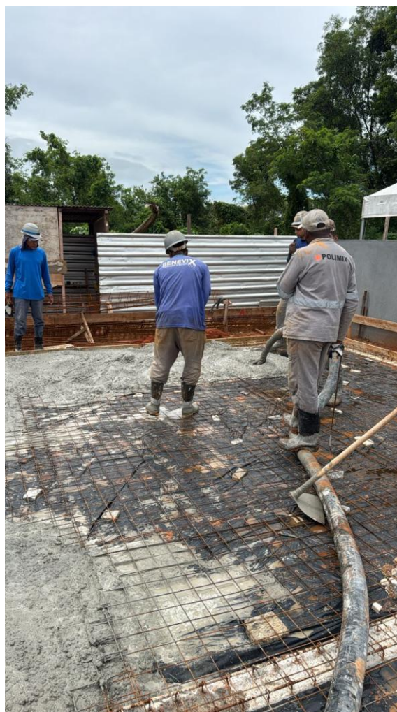
Camada separadora para execução de radier, piso de concreto ou laje sobre solo, em lona plástica. Af_09/2021
