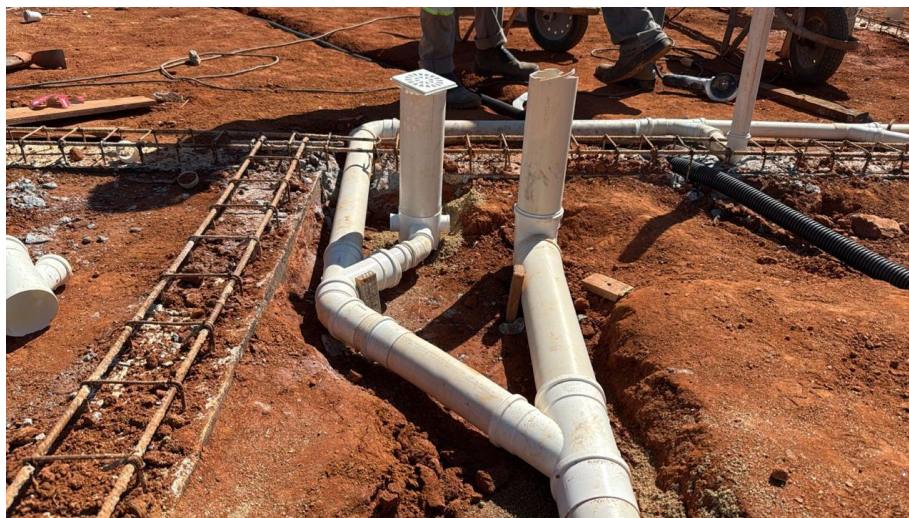
Tubo de pvc rígido soldável branco, para esgoto, série normal, diâmetro 150mm (6"), inclusive conexões
