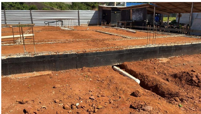
Impermeabilização de superfície com emulsão asfáltica, 2 demãos. Af_09/2023
