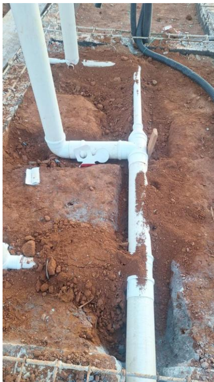
Reaterro apiloado de cavas de fundação, em camadas de 20 cm
