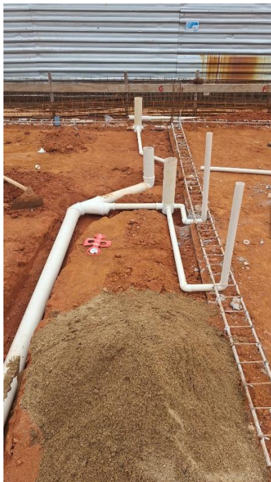
Tubo de pvc rígido soldável branco, para esgoto, série normal, diâmetro 75mm (3"), inclusive conexões
