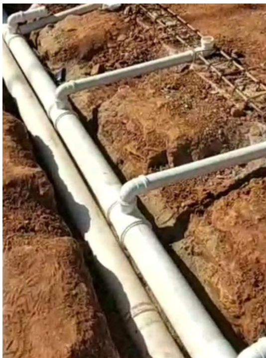
Tubo de pvc rígido soldável branco, para esgoto, série normal, diâmetro 40mm (1 1/2"), inclusive conexões
