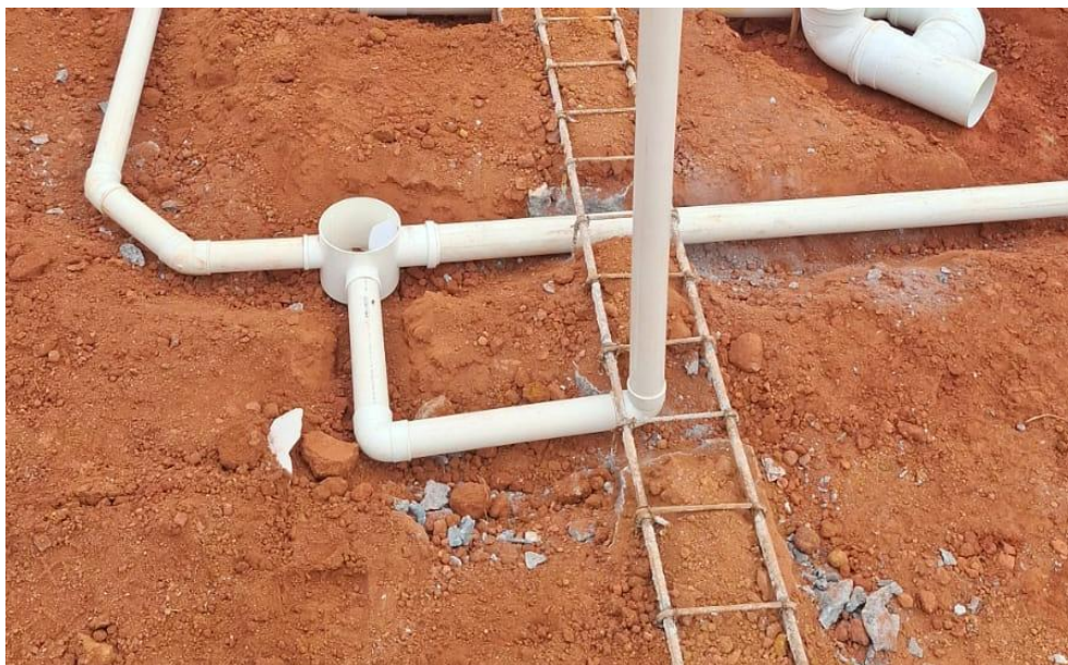
Ralo seco em PVC 100x100mm, com grelha em PVC
