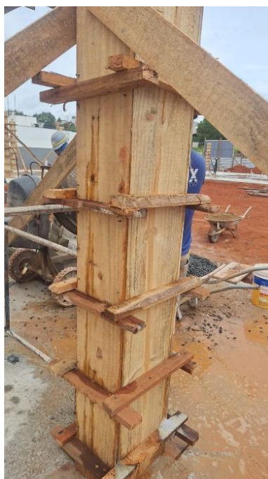
Fôrma em chapa de madeira compensada plastificada 12mm para estrutura em geral, 5 reaproveitamentos, reforçada com sarrafos de madeira 2.5x10cm (incl material, corte, montagem, escoras em eucalipto e desforma)
