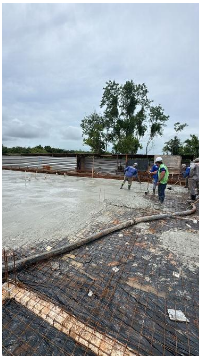
Armação para execução de radier, piso de concreto ou laje sobre solo, com uso de tela q-196. Af_09/2021
