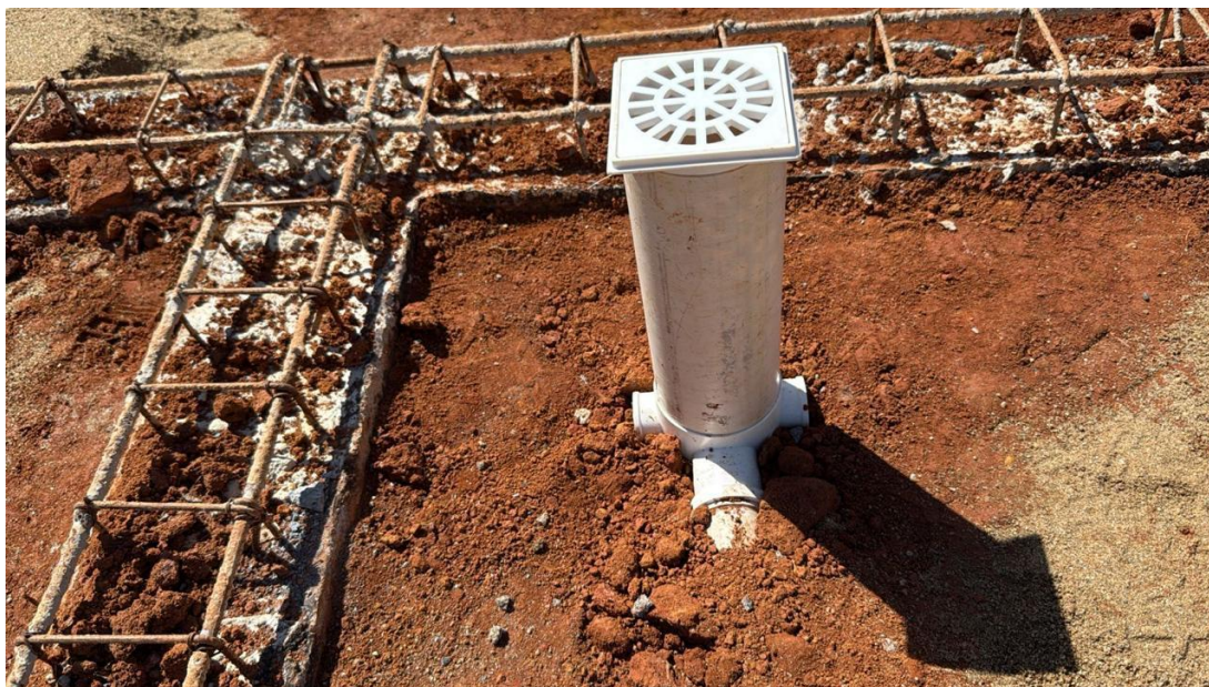
Caixa sifonada, pvc, dn 150 x 170 x 75 mm, junta elástica, fornecida e instalada em ramal de descarga ou em ramal de esgoto sanitário. Tudo incluído.
