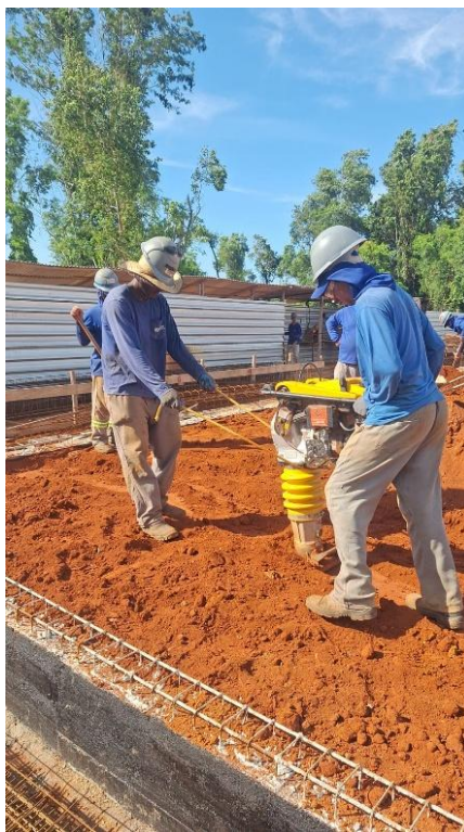
Compactação de aterros a 100% do Proctor intermediário
