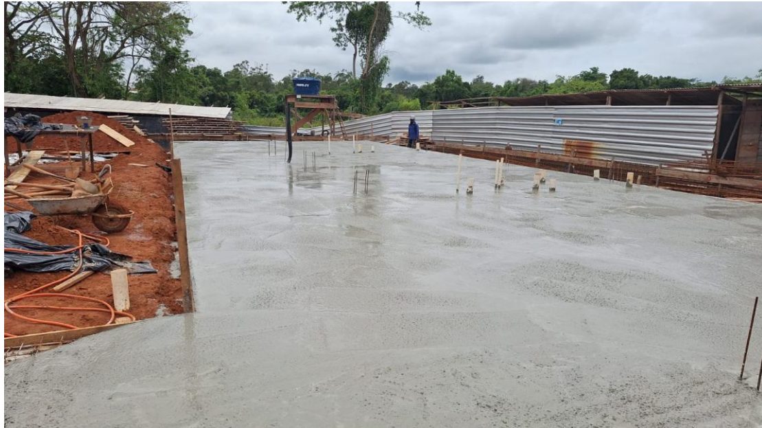
Fornecimento e aplicação de concreto usinado fck=30 mpa - considerando bombeamento (5% de perdas já incluído no custo) (6% de taxa p/ concr. Bombeável)
