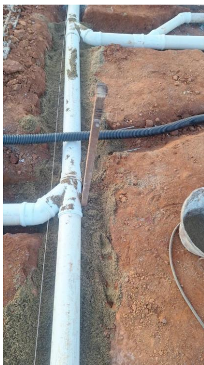
Tubo de pvc rígido soldável branco, para esgoto, série normal, diâmetro 100mm (4"), inclusive conexões
