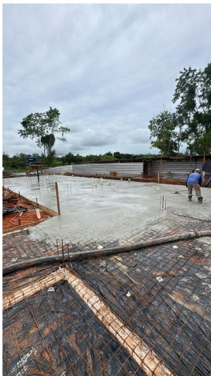
Aplicação de película química em concreto fresco (cura química)
