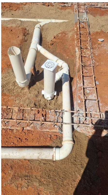
Caixa seca em pvc, diâm. 100mm, com grelha e porta grelha quadrados, em aço inox
