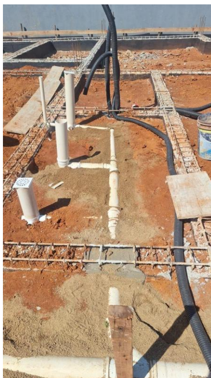
Eletroduto pead parede simples, corrugado, cor preta, diâmetro 3", referência kanaflex, plastibras ou equivalente
