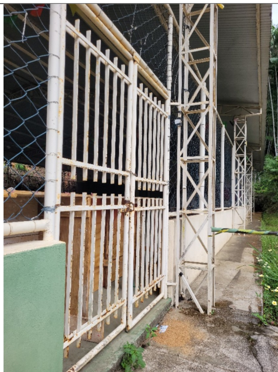
Foto 29: Lateral com oxidação pontual
