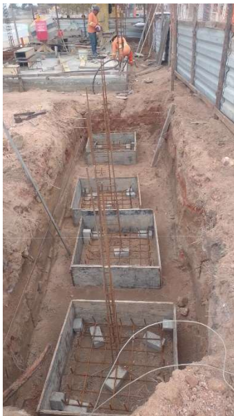
FÔRMA DE CHAPA COMPENSADA RESINADA 12MM
