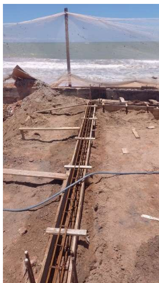
FORNECIMENTO, DOBRAGEM E COLOCAÇÃO EM FÔRMA, DE ARMADURA CA-50 A MÉDIA, DIÂMETRO DE 6.3 A 10.0 MM
