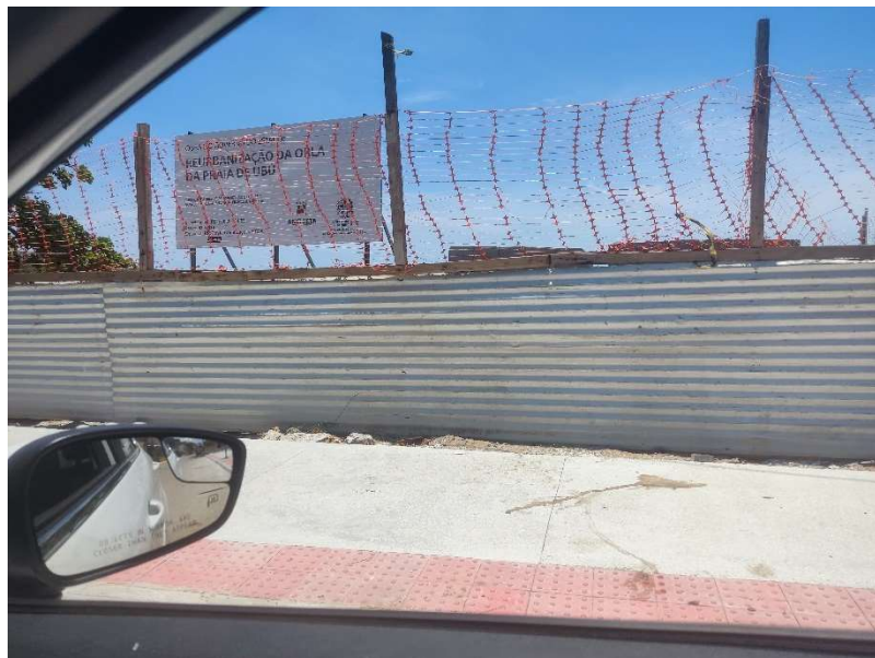
TAPUME TELHA METÁLICA ONDULADA 0,50MM
