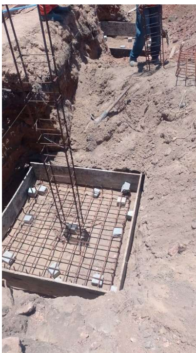
FORNECIMENTO, DOBRAGEM E COLOCAÇÃO EM FÔRMA, DE ARMADURA CA-50 A MÉDIA, DIÂMETRO DE 6.3 A 10.0 MM
