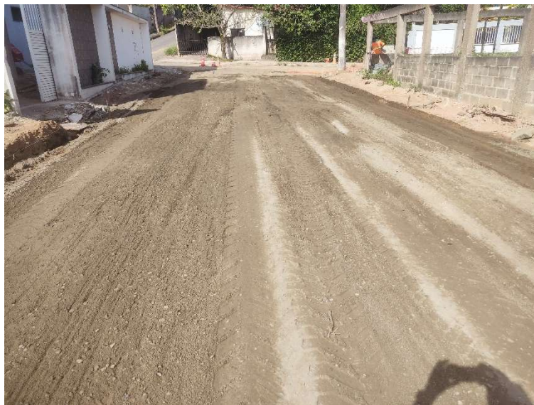
ESTABILIZAÇÃO GRANULOMÉTRICA DE SOLO S/ MISTURA 100% P.I.
