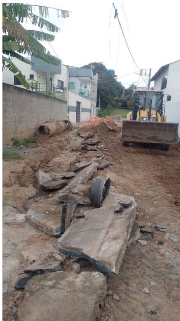
DEMOLIÇÃO DE PISO CIMENTADO INCLUSIVE LASTRO DE CONCRETO
