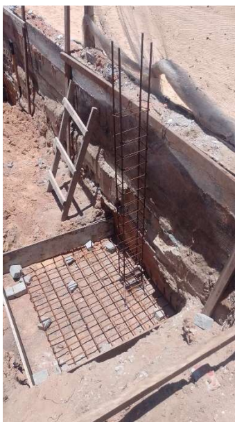
FÔRMA DE CHAPA COMPENSADA RESINADA 12MM
