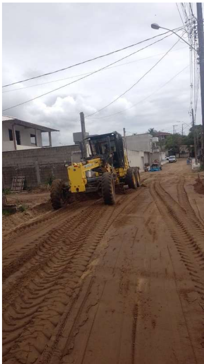
ESTABILIZAÇÃO GRANULOMÉTRICA DE SOLO S/ MISTURA 100% P.I.
