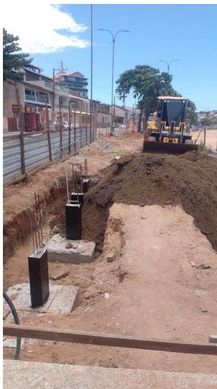
REATERRO DA INFRAESTRUTURA
