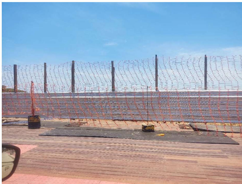
TAPUME TELHA METÁLICA ONDULADA 0,50MM
