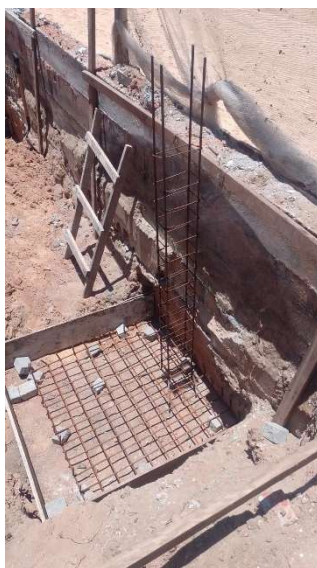
FORNECIMENTO, DOBRAGEM E COLOCAÇÃO EM FÔRMA, DE ARMADURA CA-50 A GROSSA DIÂMETRO DE 12.5 A 25.0 MM (1/2 A 1")
