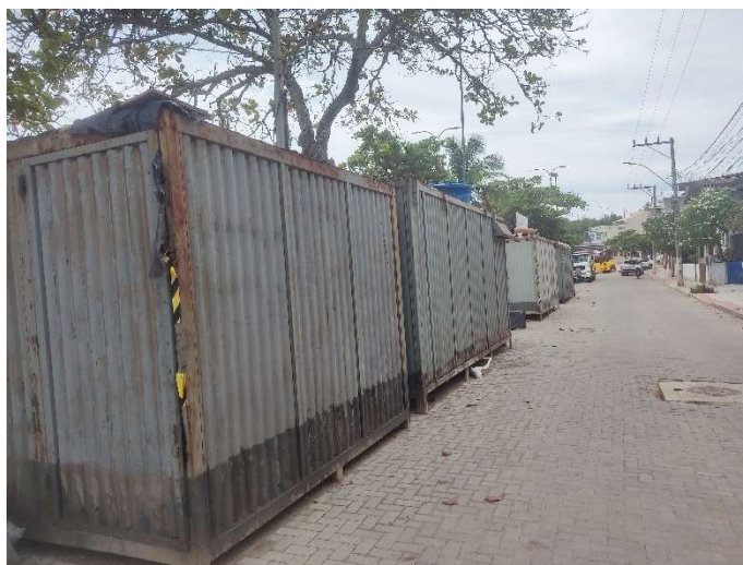
MOBILIZAÇÃO E DESMOBILIZAÇÃO DE CONTAINER
