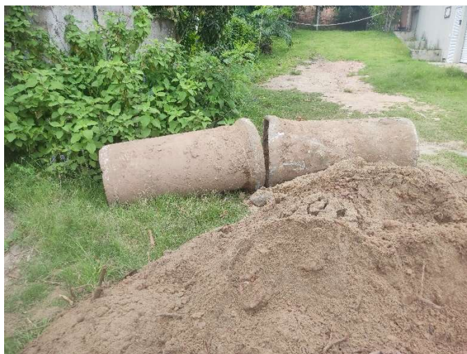
REMOÇÃO DE TUBOS DE CONCRETO COM DIÂMETRO DE 0,40 M A 1,00 M EM VALAS E BUEIROS
