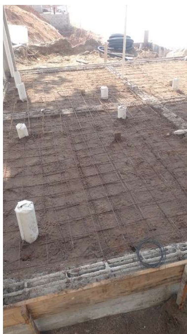
ARMAÇÃO PARA EXECUÇÃO DE RADIER, PISO DE CONCRETO OU LAJE SOBRE SOLO
