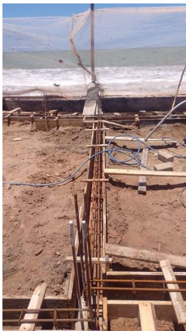
FORNECIMENTO, DOBRAGEM E COLOCAÇÃO EM FÔRMA, DE ARMADURA CA-50 A GROSSA, DIÂMETRO DE 12.5 A 25.0MM
