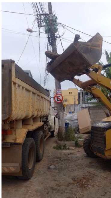
REMOÇÃO DE ENTULHO DECORRENTE DA EXECUÇÃO DE OBRAS
