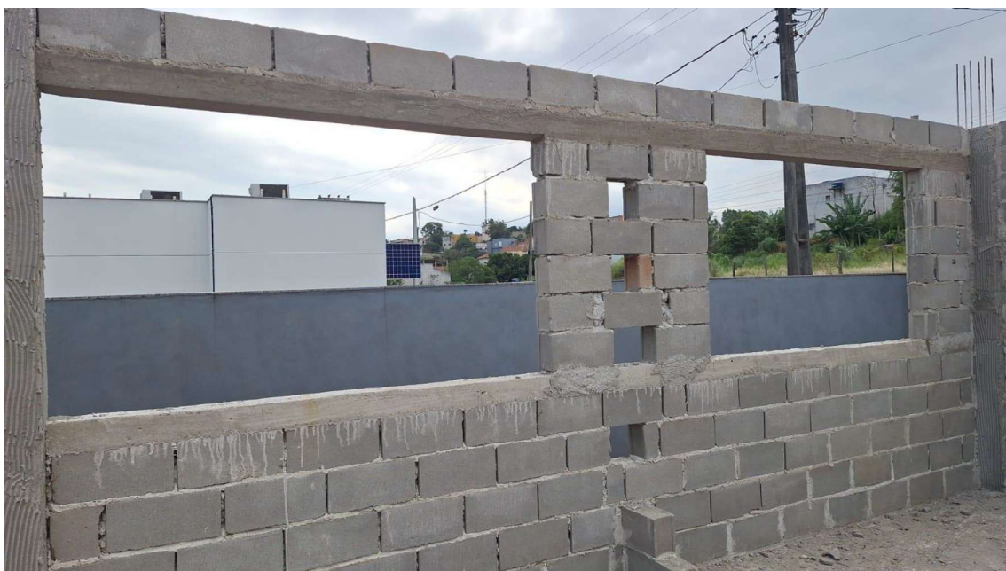
CONTRAVERGA MOLDADA IN LOCO EM CONCRETO, ESPESSURA DE *20* CM. AF_03/2024
