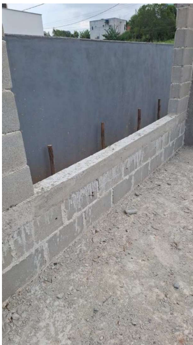
CONTRAVERGA MOLDADA IN LOCO EM CONCRETO, ESPESSURA DE *15* CM. AF_03/2024
