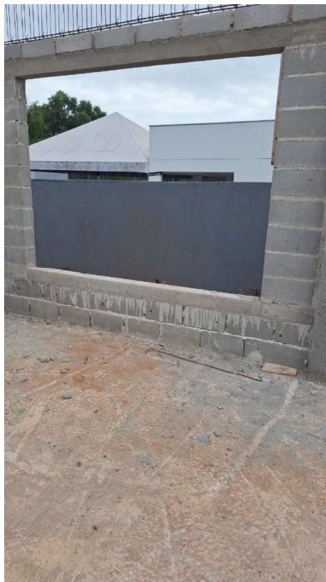
VERGA MOLDADA IN LOCO EM CONCRETO, ESPESSURA DE *15* CM. AF_03/2024
