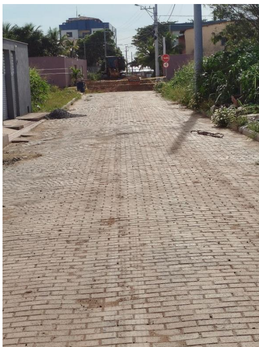
PAVIMENTAÇÃO COM BLOCOS DE CONCRETO (35 MPA), ESP.= 08 CM, COLCHÃO AREIA ESP.= 5CM
