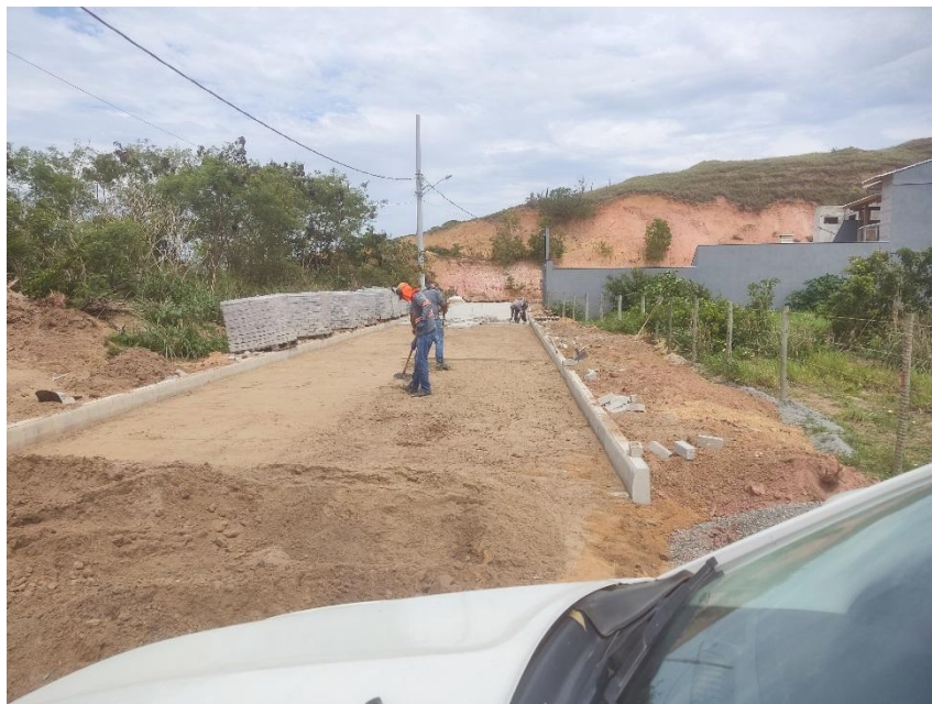
PAVIMENTAÇÃO COM BLOCOS DE CONCRETO (35 MPA), ESP.= 08 CM, COLCHÃO AREIA ESP.= 5CM
