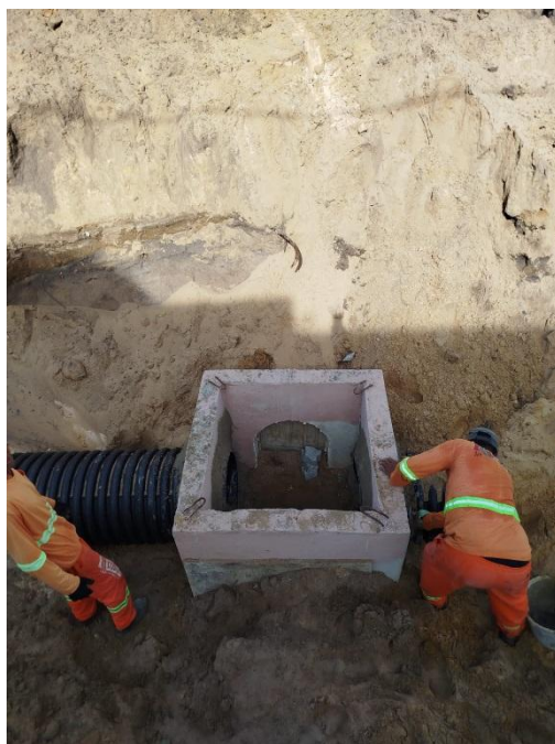
POÇO DE VISITA
