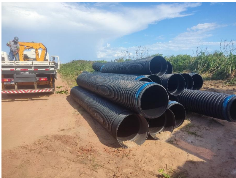
TUBO PEAD PARA DRENAGEM - D = 600-800 MM - FORNECIMENTO E INSTALAÇÃO
