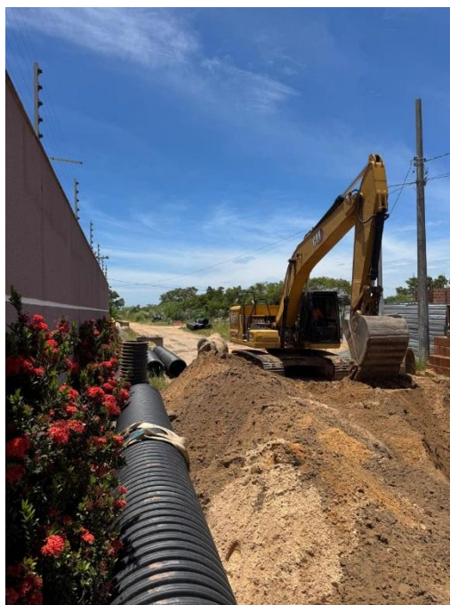
ESCAVAÇÃO MECÂNICA DE VALA EM MATERIAL DE 1ª CATEGORIA
