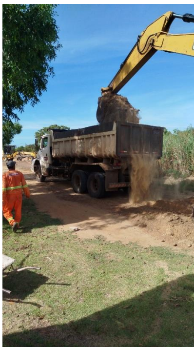
CARGA, MANOBRA E DESCARGA DE SOLOS E MATERIAIS GRANULARES EM CAMINHÃO BASCULANTE 10 M 3 - CARGA COM ESCAVADEIRA HIDRÁULICA
