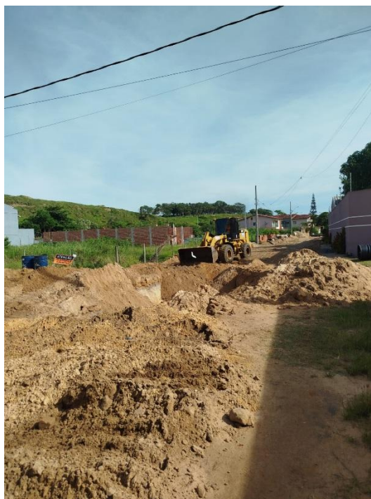
REATERRO COM AREIA
