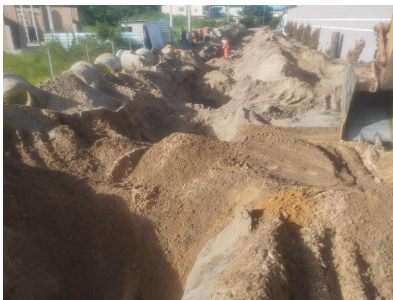
REATERRO COM AREIA
