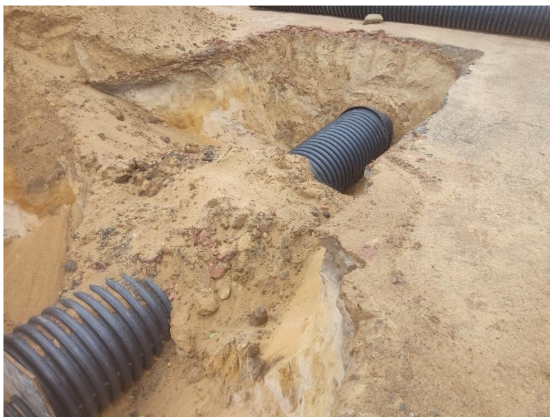
TUBO PEAD PARA DRENAGEM - D = 800 MM - FORNECIMENTO E INSTALAÇÃO
