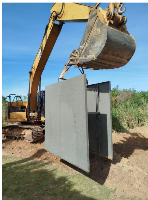
ESCORAMENTO METALICO DE VALA TIPO GAIOLA
