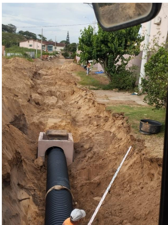
POÇO DE VISITA
