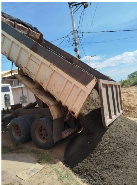
TRANSPORTE DE BRITA GRADUADA DA BASE
