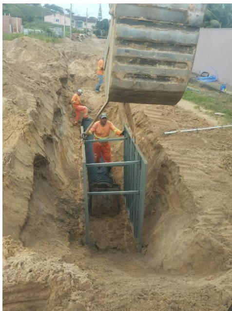
ESCORAMENTO METALICO DE VALA TIPO GAIOLA
