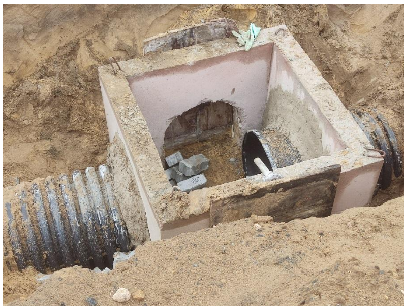
POÇO DE VISITA
