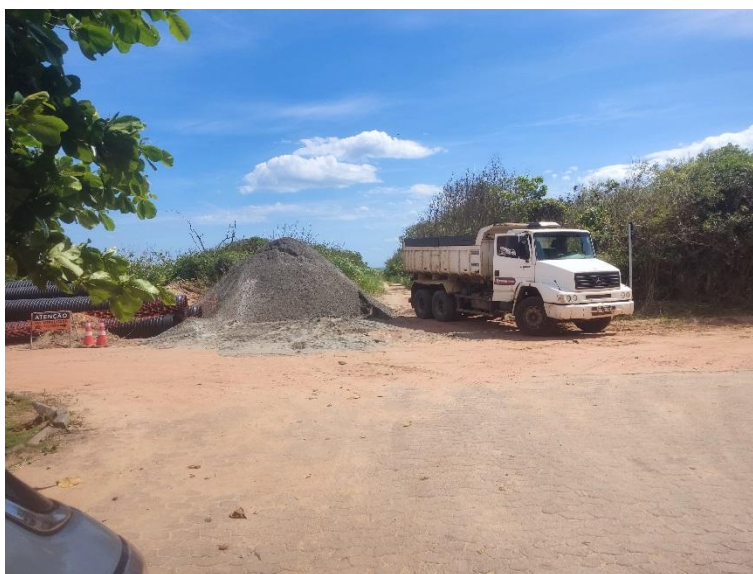
TRANSPORTE DE BRITA GRADUADA DA BASE
