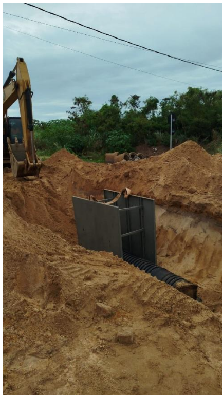
ESCORAMENTO METALICO DE VALA TIPO GAIOLA
