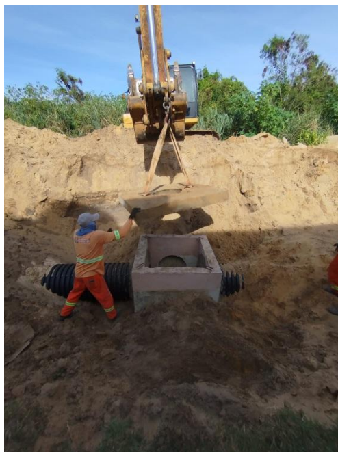
POÇO DE VISITA
