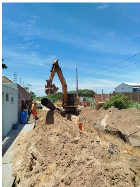
TUBO PEAD PARA DRENAGEM - D = 600 MM - FORNECIMENTO E INSTALAÇÃO
