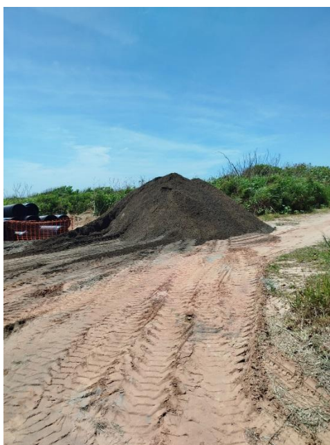
BRITA GRADUADA TRANSPORTADA PARA O PÁTIO DA OBRA
