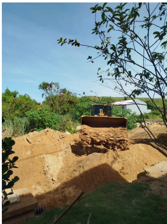
REATERRO COM AREIA
