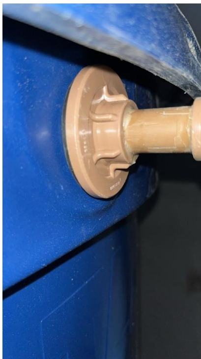
Figura 13: ADAPTADOR DE PVC SOLDÁVEL COM FLANGES LIVRES PARA CAIXA D'ÁGUA, DIÂMETRO 25MM (3/4")
