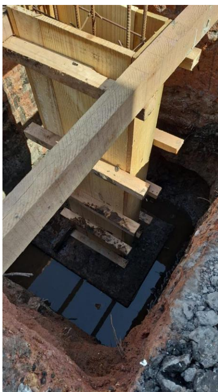
Figura 35: FÔRMA EM CHAPA DE MADEIRA COMPENSADA PLASTIFICADA 12MM PARA ESTRUTURA EM GERAL, 5 REAPROVEITAMENTOS, REFORÇADA COM SARRAFOS DE MADEIRA 2.5X10CM (INCL MATERIAL, CORTE, MONTAGEM, ESCORAS EM EUCALIPTO E DESFORMA)
