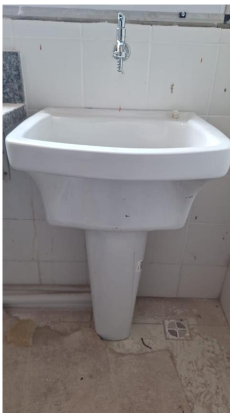
Figura 16: TANQUE DE LOUÇA BRANCA COM COLUNA, 30L OU EQUIVALENTE - FORNECIMENTO E INSTALAÇÃO. AF_01/2020
