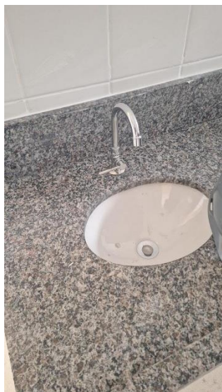
Figura 7: TORNEIRA CROMADA DE MESA, 1/2 OU 3/4, PARA LAVATÓRIO, PADRÃO MÉDIO - FORNECIMENTO E INSTALAÇÃO. AF_01/2020.
