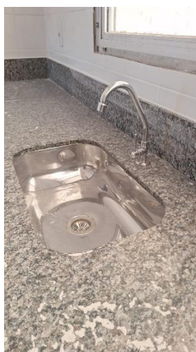
Figura 6: TORNEIRA PRESSÃO CROMADA DIÂM. 1/2" PARA LAVATÓRIO, MARCAS DE REFERÊNCIA FABRIMAR, DECA OU DOCOL
