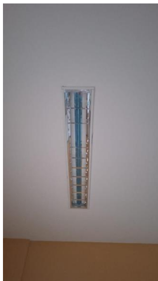
Figura 2: LUMINARIA EMBUTIR COMPL., CORPO CH. AÇO PINTADA BRANCA, REFLETOR, ALETAS PARABÓLICAS ALUM.ALTA PUREZA E REFLETÂNCIA INCLUSIVE 2 LÂMPADAS LED T8 18W TEMP. DE COR 5000K C/ 1,20M - REF. CE232AL-N - AMES, 6025 - LUMAVI -LDEF 2X32W - LUMILUZ OU EQUIVALENTE
