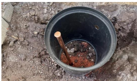
Figura 25: HASTE DE TERRA TIPO COPPERWELD - 5/8" X 2.40M
