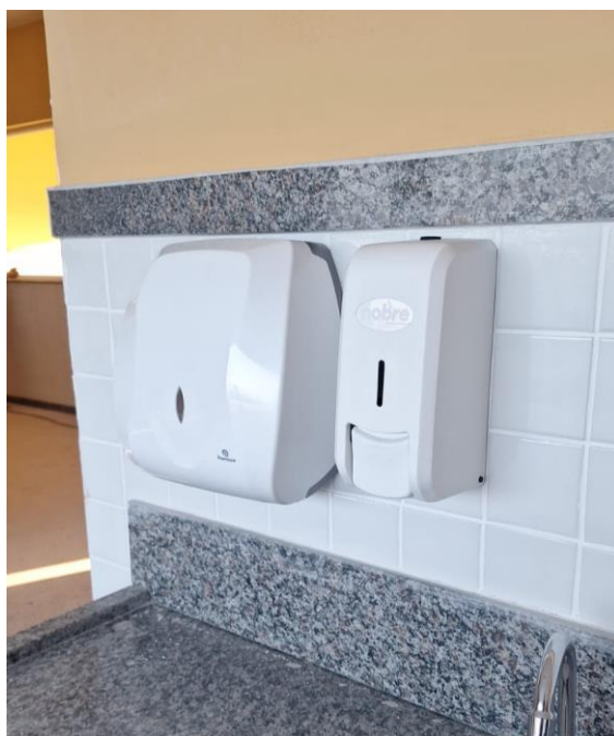
Figura 18: SABONETEIRA PLÁSTICA TIPO DISPENSER PARA SABONETE LÍQUIDO COM RESERVATÓRIO 800 A 1500 ML, INCLUSO FIXAÇÃO. AF_01/2020
