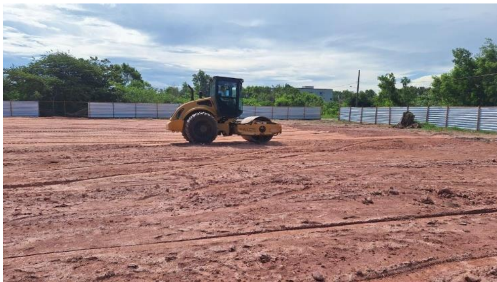
Figura 48: Aterro compactado utilizando compactador de placa vibratória com reaproveitamento do material
