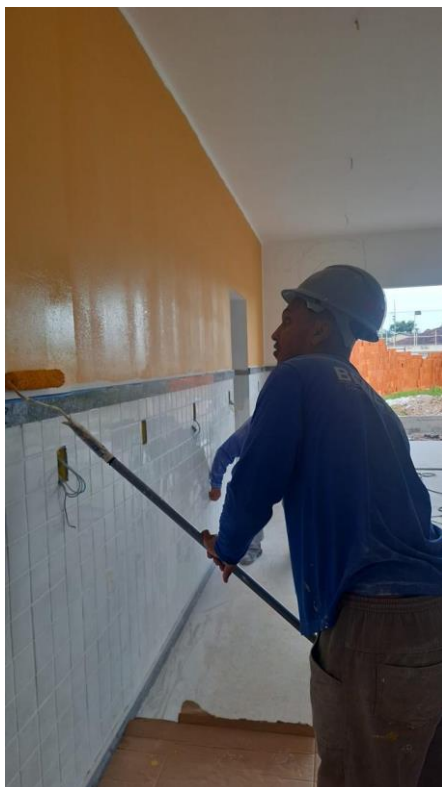
Figura 46: PINTURA COM TINTA LÁTEX PVA, MARCAS DE REFERÊNCIA SUVINIL, CORAL OU METALATEX, INCLUSIVE SELADOR EM PAREDES E FORROS, A TRÊS DEMÃOS
