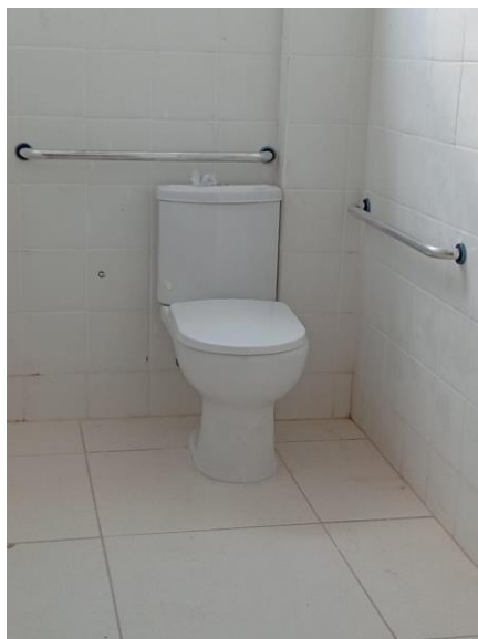
Figura 24: BARRA DE APOIO EM "L", EM ACO INOX POLIDO 70 X 70 CM, FIXADA NA PAREDE - FORNECIMENTO E INSTALAÇÃO. AF_01/2020
