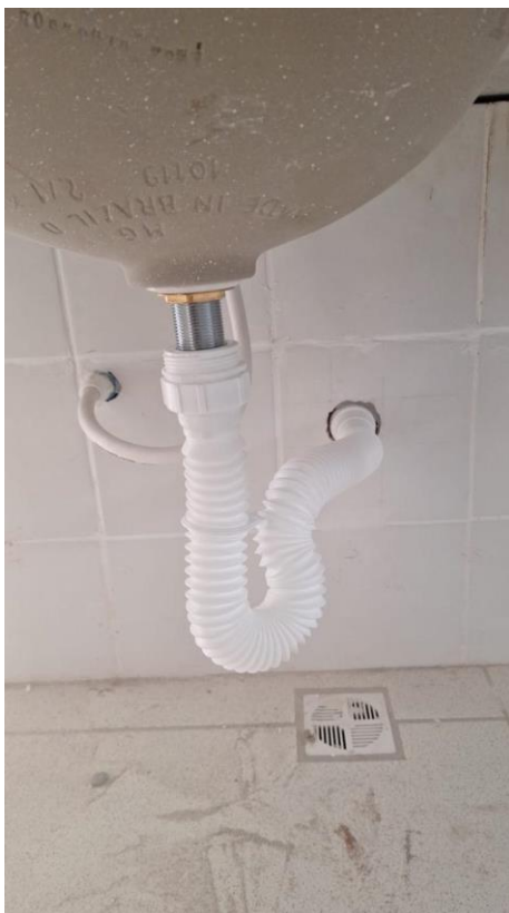
Figura 11: SIFÃO EM PVC PARA PIA DE COZINHA OU LAVATÓRIO 1X11/2"
