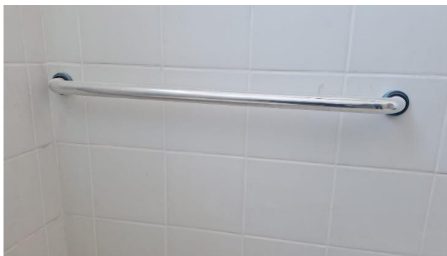
Figura 23: BARRA DE APOIO RETA, EM ACO INOX POLIDO, COMPRIMENTO 80 CM, FIXADA NA PAREDE - FORNECIMENTO E INSTALAÇÃO. AF_01/2020
