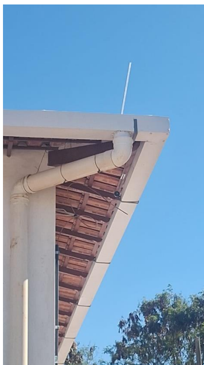
Figura 31: TERMINAL AÉREO EM LATÃO (MINICAPTOR), COM CONECTOR E FIXAÇÃO HORIZONTAL 250MM X 10MM, REF. TEL-2024, INCLUSIVE VEDAÇÃO DOS FUROS COM POLIURETANO REF. TEL 5905, MARCA DE REF. TERMOTÉCNICA OU EQUIVALENTE
