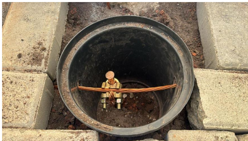
Figura 28: TERMINAL PARA LIGAÇÃO DE CABO A BARRA DE 50.0 MM2
