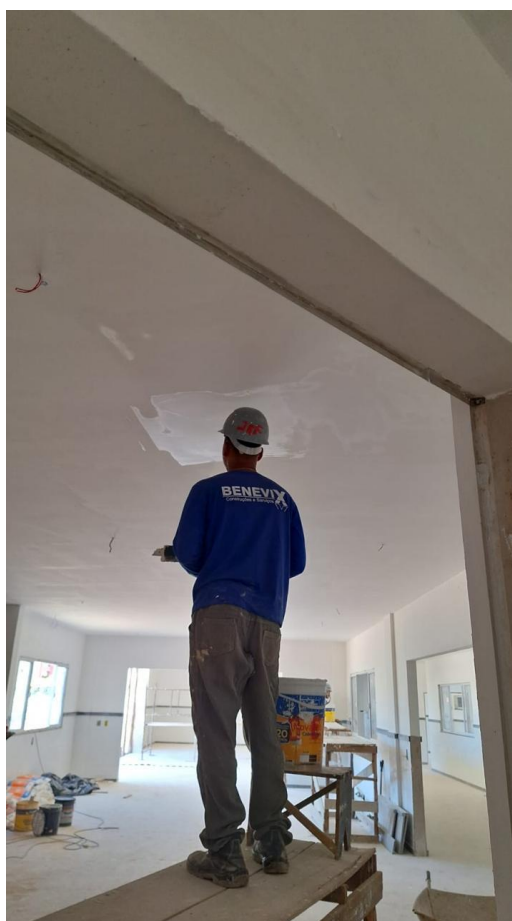
Figura 45: EMASSAMENTO DE PAREDES E FORROS, COM DUAS DEMÃOS DE MASSA ACRÍLICA, MARCAS DE REFERÊNCIA SUVINIL, CORAL OU METALATEX
