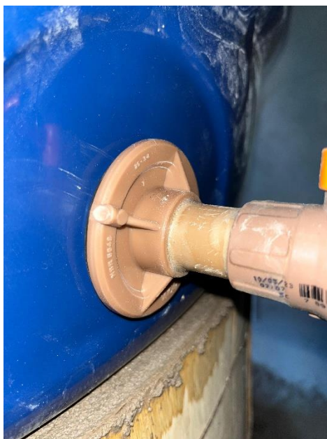
Figura 14: ADAPTADOR DE PVC COM FLANGES LIVRES PARA CAIXA D'ÁGUA DE 32MMX1"
