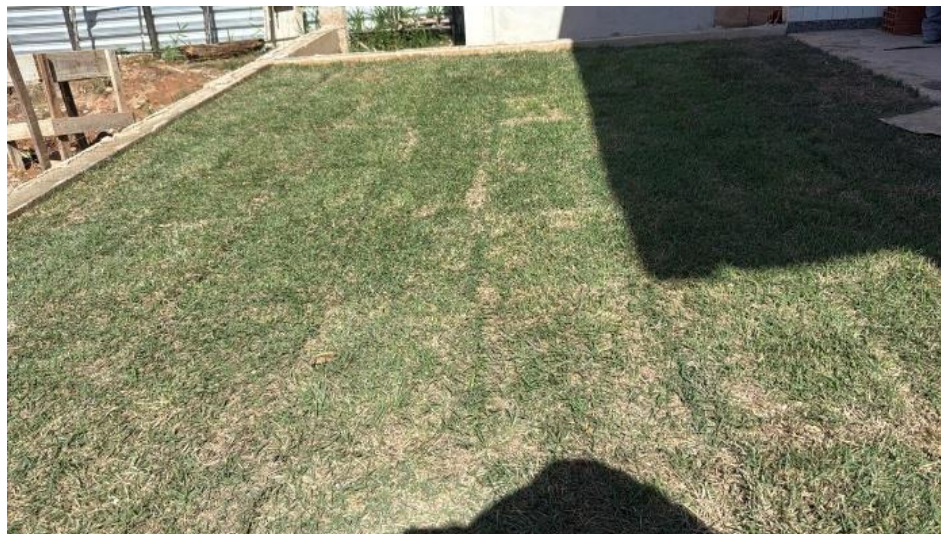
Figura 32: FORNECIMENTO E PLANTIO DE GRAMA EM PLACAS TIPO ESMERALDA, INCLUSIVE FORNECIMENTO DE TERRA VEGETAL
