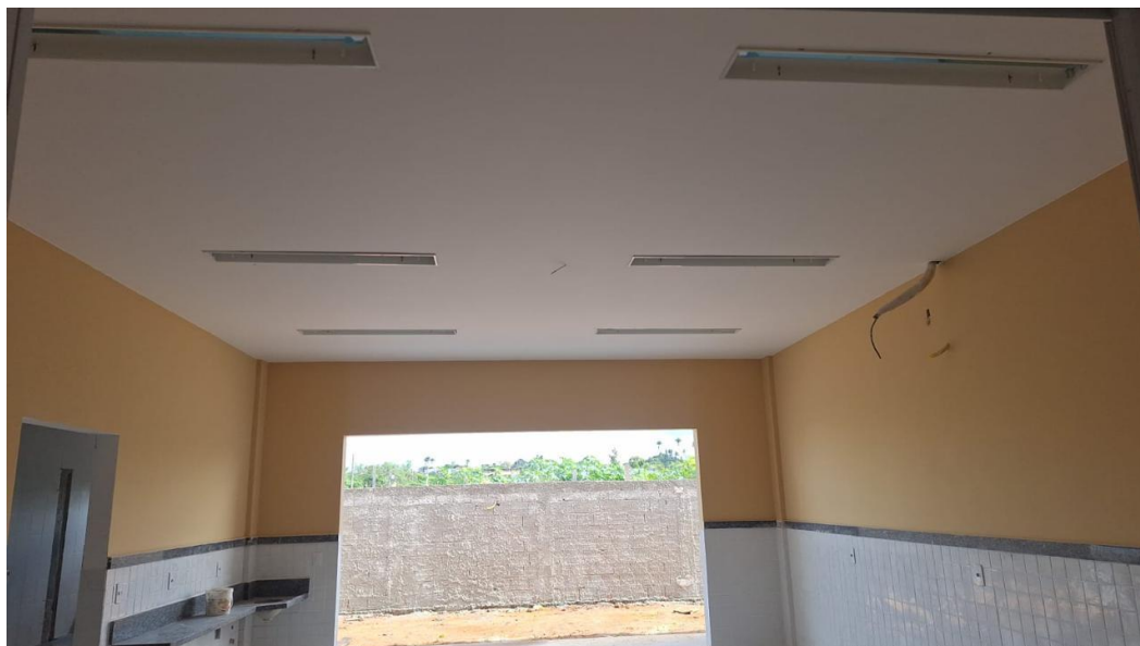
Figura 3: LUMINARIA EMBUTIR COMPL., CORPO CH. AÇO PINTADA BRANCA, REFLETOR ALETAS PARABÓLICAS ALUM.ALTA PUREZA E REFLETÂNCIA INCLUSIVE 2 LÂMPADAS LED T8 9W TEMP. DE COR 5000K C/ 60CM - REF. CE216AL-N - AMES, 6024 - LUMAVI OU EQUIVALENTE
