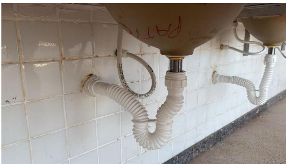
Figura 10: ENGATE FLEXÍVEL DE PVC PARA LAVATÓRIO
