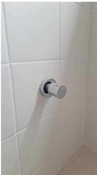
Figura 15: REGISTRO DE PRESSÃO COM CANOPLA CROMADA DIAM. 20MM (3/4"), MARCAS DE REFERÊNCIA FABRIMAR, DECA OU DOCOL
