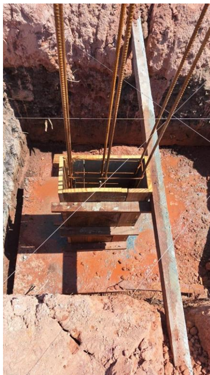
Figura 38: FORNECIMENTO, DOBRAGEM E COLOCAÇÃO EM FÔRMA, DE ARMADURA CA-50 A MÉDIA, DIÂMETRO DE 6.3 A 10.0 MM
