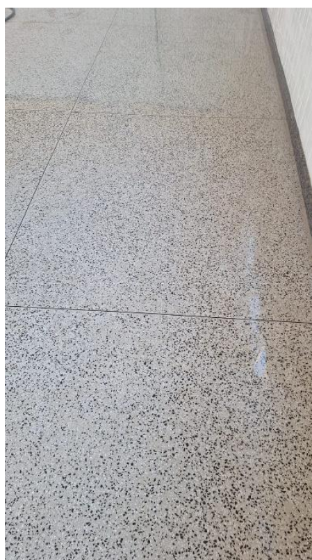
Figura 49: Pintura com tinta à base de resinas acrílicas, marcas de referência Suvinil, Coral ou Novacor, sobre piso de concreto a duas demãos
