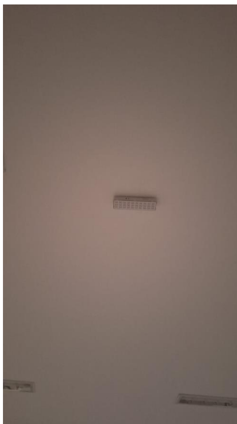
Figura 3: LUMINARIA EMBUTIR COMPL., CORPO CH. AÇO PINTADA BRANCA, REFLETOR ALETAS PARABÓLICAS ALUM.ALTA PUREZA E REFLETÂNCIA INCLUSIVE 2 LÂMPADAS LED T8 9W TEMP. DE COR 5000K C/ 60CM - REF. CE216AL-N - AMES, 6024 - LUMAVI OU EQUIVALENTE
