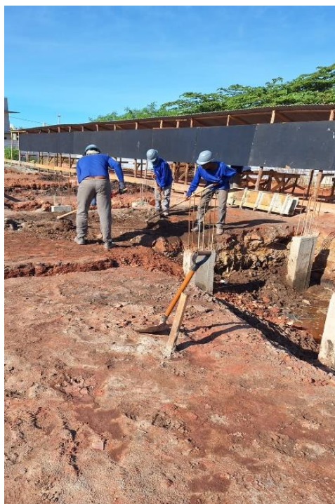
Figura 33: ESCAVAÇÃO MANUAL EM MATERIAL DE 1A. CATEGORIA, ATÉ 1.50 M DE PROFUNDIDADE
