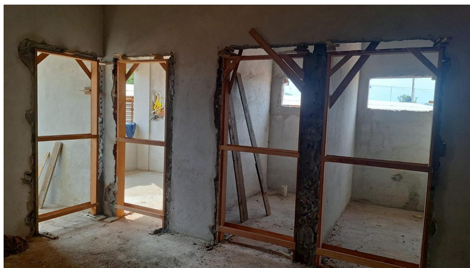
Figura 51: Marco em madeira de lei tipo Peroba, Ipê, Angelim Pedra ou equivalente, com 15 x 3cm de batente, nas dimensões: 0,80 x 2,10 m
