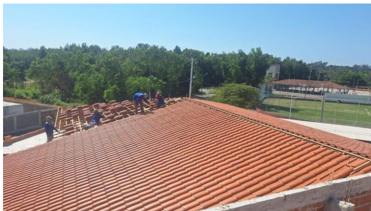
Figura 40: COBERTURA NOVA DE TELHAS CERÂMICAS TIPO CAPA E CANAL INCLUSIVE CUMEEIRAS (TELHAS COMPRADAS NA FÁBRICA, POSTO OBRA)
