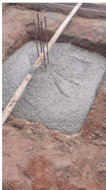
FORNECIMENTO E APLICAÇÃO DE CONCRETO USINADO FCK=30 MPA
