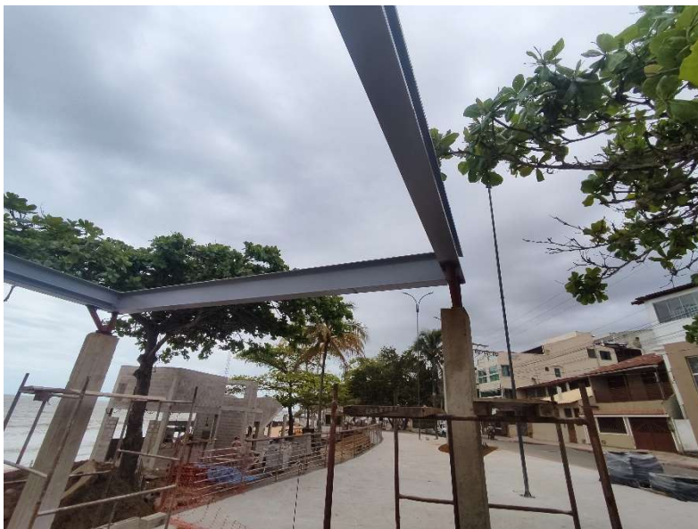
FORNECIMENTO DE ESTRUTURA METÁLICA EM PERFIL LAMINADO, INCLUSIVE FABRICAÇÃO, TRANSPORTE E MONTAGEM
