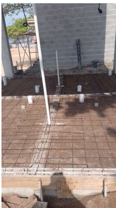
LOCAL REATERRADO PARA EXECUÇÃO DA LAJE DE PISO
