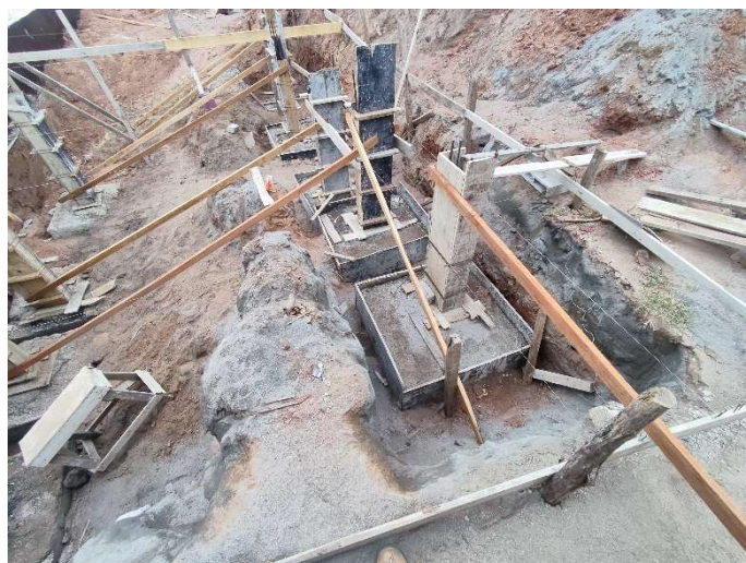
FORNECIMENTO E APLICAÇÃO DE CONCRETO USINADO FCK=30 MPA
