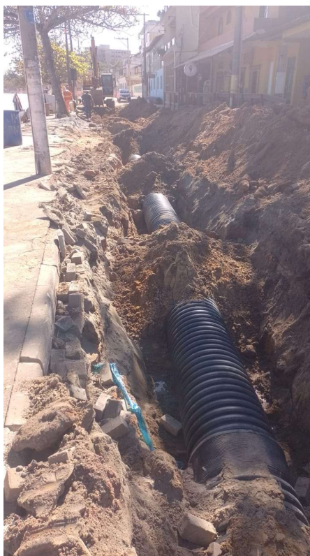
TUBO PEAD PARA DRENAGEM - D = 600 MM - FORNECIMENTO E INSTALAÇÃO
