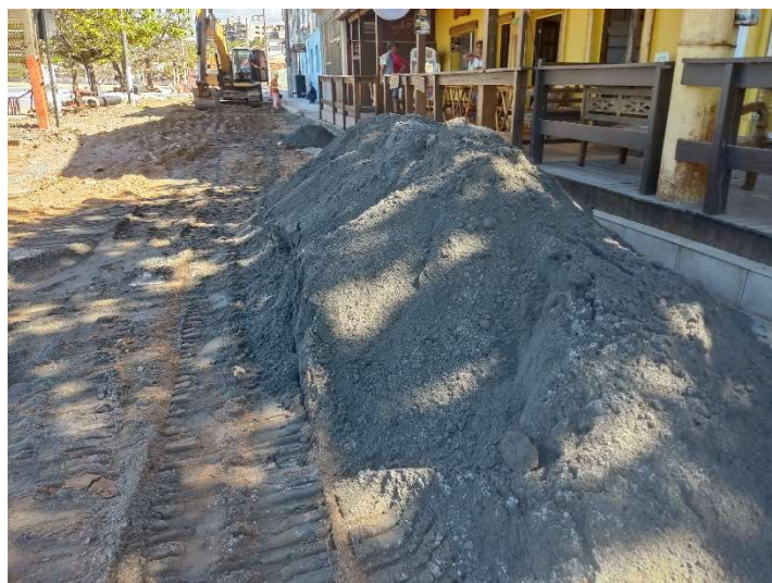
PÓ DE PEDRA INCLUSIVE FORNECIMENTO, ESPALHAMENTO
