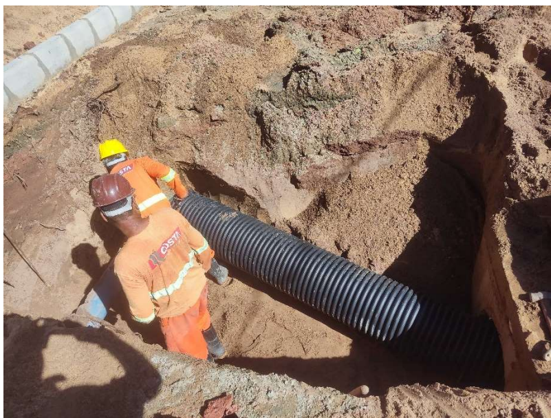
TUBO PEAD PARA DRENAGEM - D = 400 MM - FORNECIMENTO E INSTALAÇÃO
