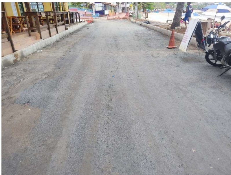
REATERRO DE VALA COMPACTADA
