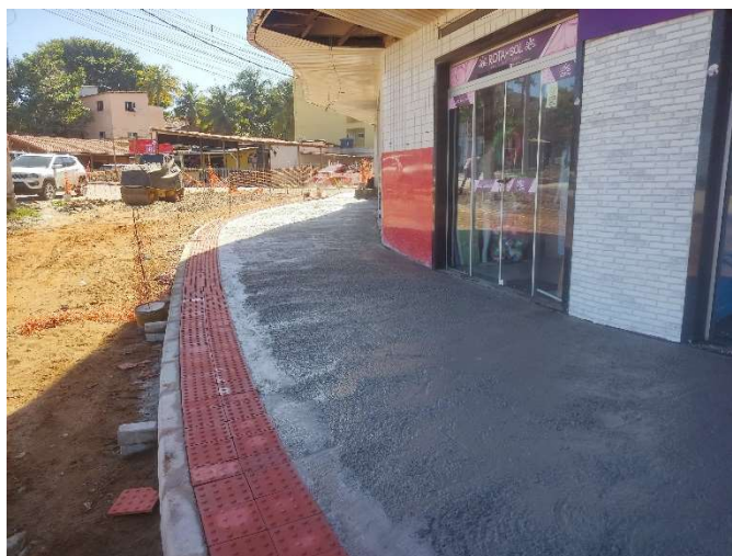
PASSEIO - PISO DE CONCRETO COM CONCRETO MOLDADO IN LOCO, USINADO, ACABAMENTO CONVENCIONAL, ESPESSURA 8 CM
