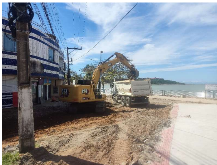
ESCAVAÇÃO MECÂNICA EM MATERIAL DE 1ª CATEGORIA, CARGA E TRANSPORTE
