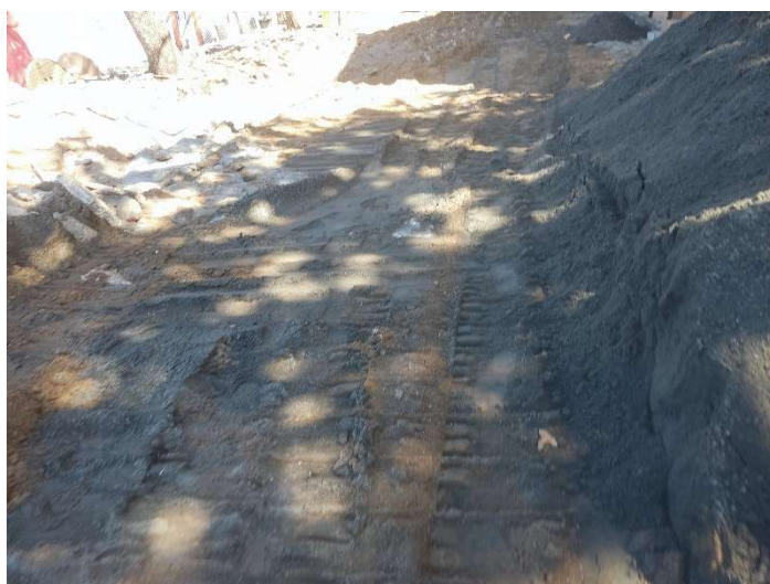
PÓ DE PEDRA INCLUSIVE FORNECIMENTO, ESPALHAMENTO
