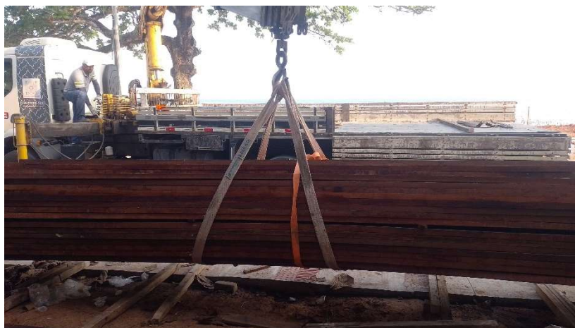
TRANSPORTE COM CAMINHÃO CARROCERIA COM CAPACIDADE DE 11 T E COM GUINDAUTO DE 45 T.M - RODOVIA PAVIMENTADA
