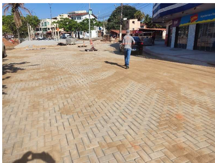
PAVIMENTAÇÃO COM BLOCOS DE CONCRETO (35 MPA), ESP.= 08 CM, COLCHÃO AREIA
