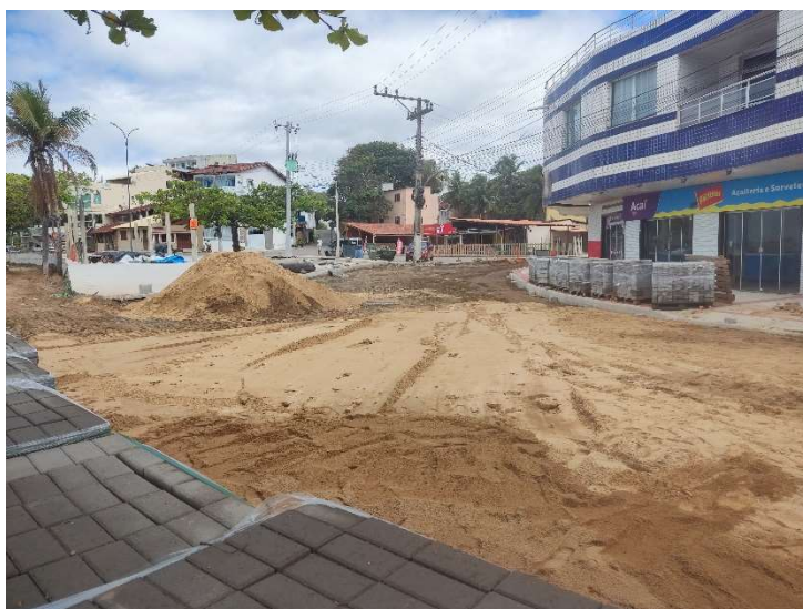
ESTABILIZAÇÃO GRANULOMÉTRICA DE SOLO S/ MISTURA
