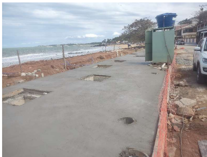
CALÇADÃO DA ORLA - PISO DE CONCRETO COM CONCRETO MOLDADO IN LOCO, USINADO, ACABAMENTO CONVENCIONAL, ESPESSURA 8 CM
