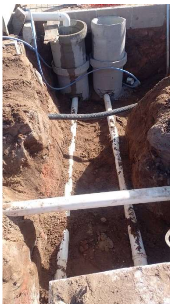
TUBO PVC RÍGIDO PARA ESGOTO NO DIÂMETRO DE 100MM
