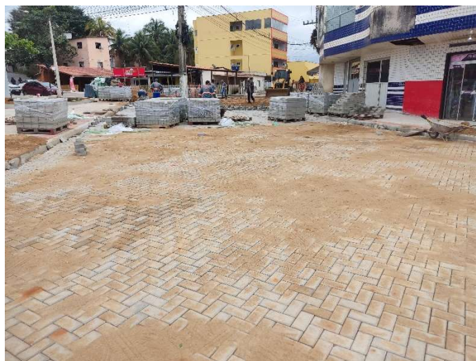
PAVIMENTAÇÃO COM BLOCOS DE CONCRETO (35 MPA), ESP.= 08 CM, COLCHÃO AREIA
