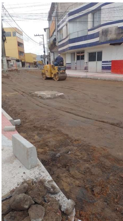
ESTABILIZAÇÃO GRANULOMÉTRICA DE SOLO S/ MISTURA
