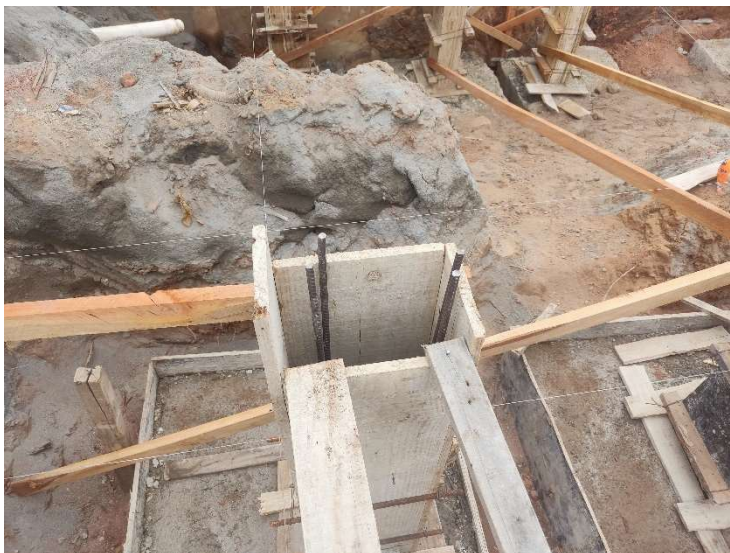
FORNECIMENTO, DOBRAGEM E COLOCAÇÃO EM FÔRMA, DE ARMADURA CA-50 A GROSSA, DIÂMETRO DE 12.5 A 25.0MM
