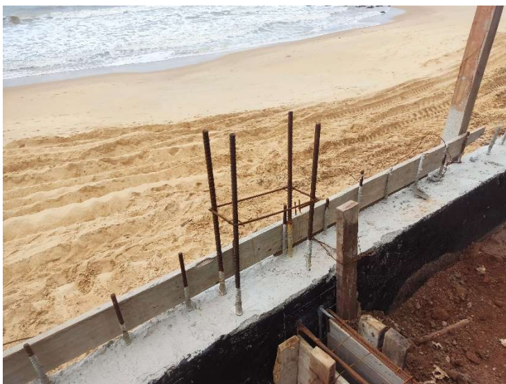
FORNECIMENTO, DOBRAGEM E COLOCAÇÃO EM FÔRMA, DE ARMADURA CA-50 A GROSSA, DIÂMETRO DE 12.5 A 25.0MM
