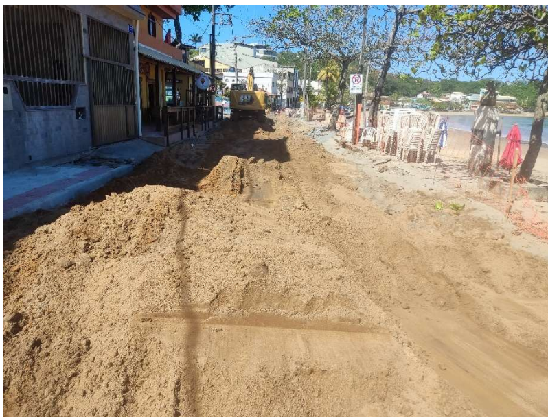
REATERRO DE VALA
