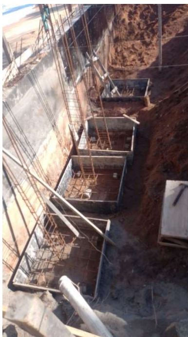
FÔRMA DE TÁBUA DE MADEIRA DE 2.5X30.0CM, LEVANDO-SE EM CONTA UTILIZAÇÃO 3 VEZES
