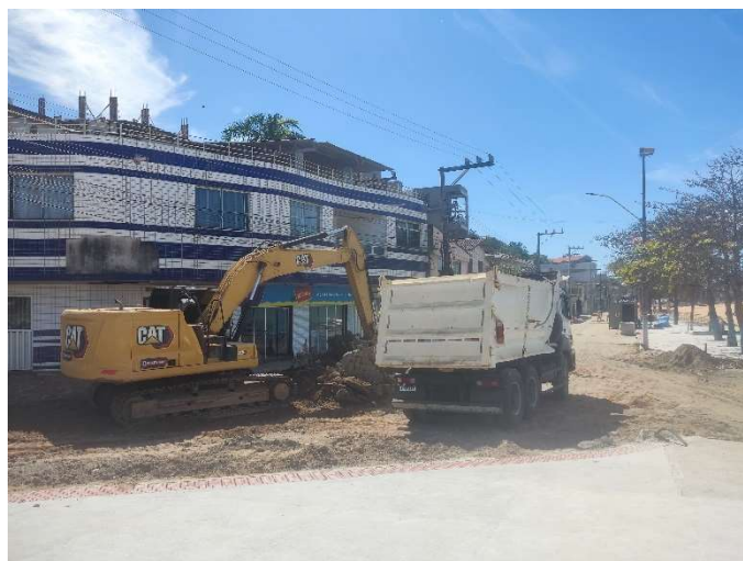
REMOÇÃO DE ENTULHO DECORRENTE DAS DEMOLIÇÕES
