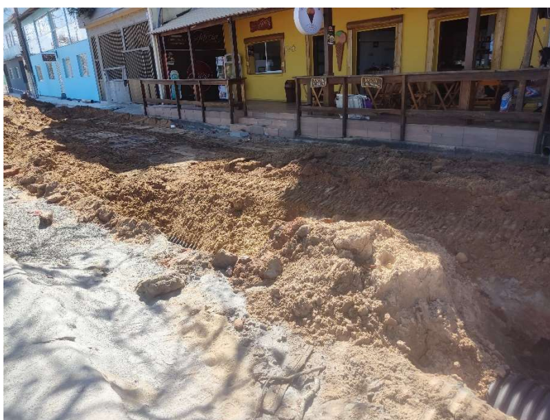
REATERRO DE VALA
