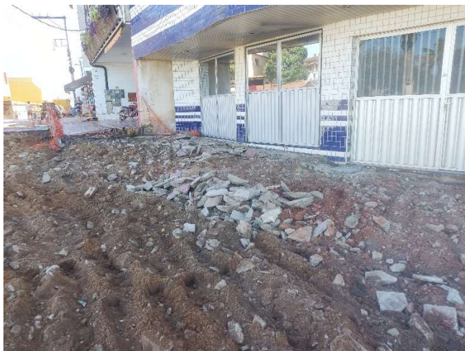
REMOÇÃO DE MEIO FIO E DEMOLIÇÃO DE PISO CIMENTADO INCLUSIVE LASTRO DE CONCRETO
