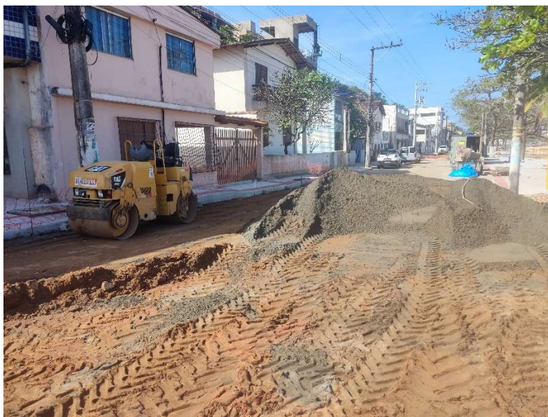
COMPACTAÇÃO DE ATERRO
