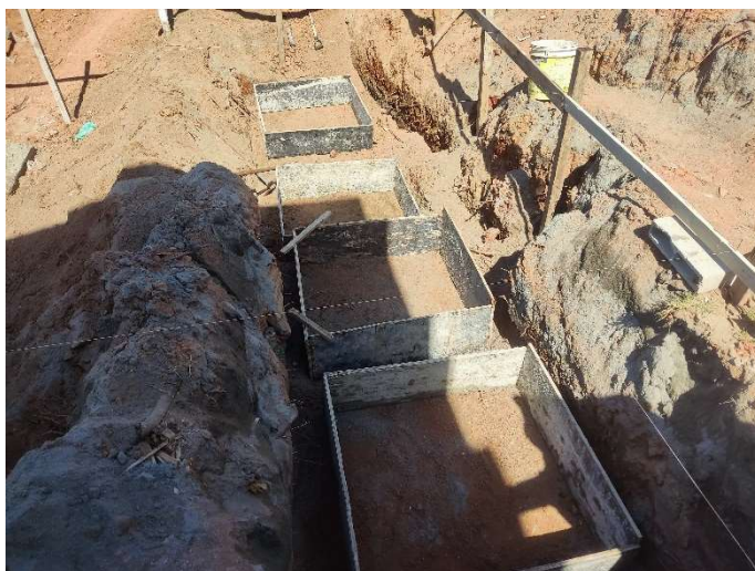
FÔRMA DE TÁBUA DE MADEIRA DE 2.5X30.0CM, LEVANDO-SE EM CONTA UTILIZAÇÃO 3 VEZES
