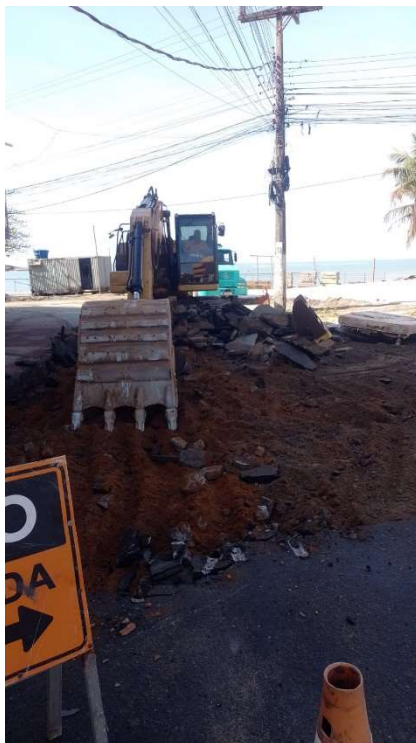
REMOÇÃO MECANIZADA DE REVESTIMENTO ASFÁLTICO
