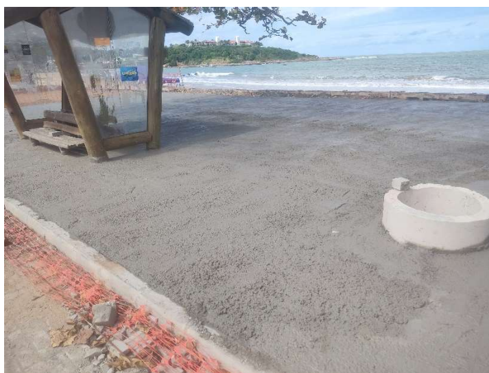
CALÇADÃO DA ORLA - PISO DE CONCRETO COM CONCRETO MOLDADO IN LOCO, USINADO, ACABAMENTO CONVENCIONAL, ESPESSURA 8 CM
