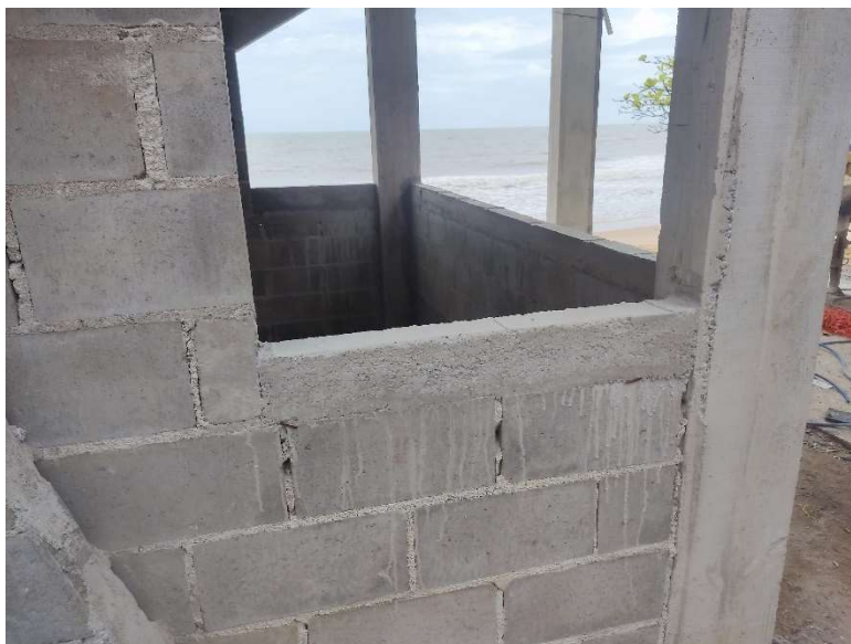
VERGA/CONTRAVERGA RETA DE CONCRETO ARMADO 10 X 5 CM, FCK = 15 MPA
