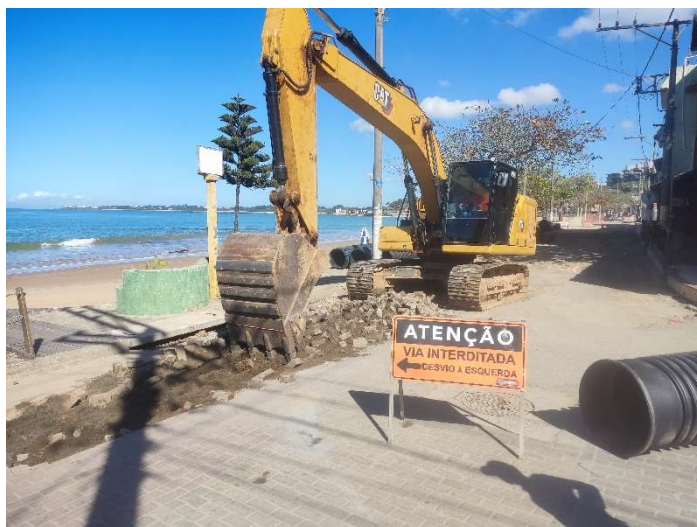
ESCAVAÇÃO MECÂNICA EM MATERIAL DE 1ª CATEGORIA
