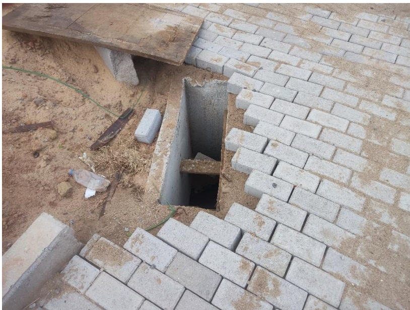
CAIXA RALO EM BLOCOS PRÉ-MOLDADOS E GRELHA ARTICULADA EM FFA EM VIAS URBANAS
