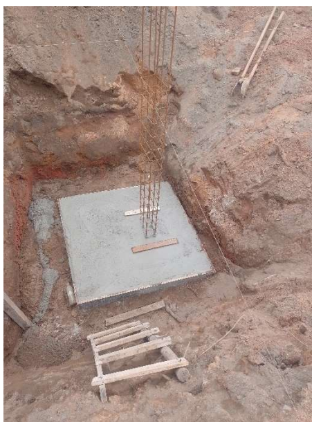
FORNECIMENTO, PREPARO E APLICAÇÃO DE CONCRETO MAGRO
