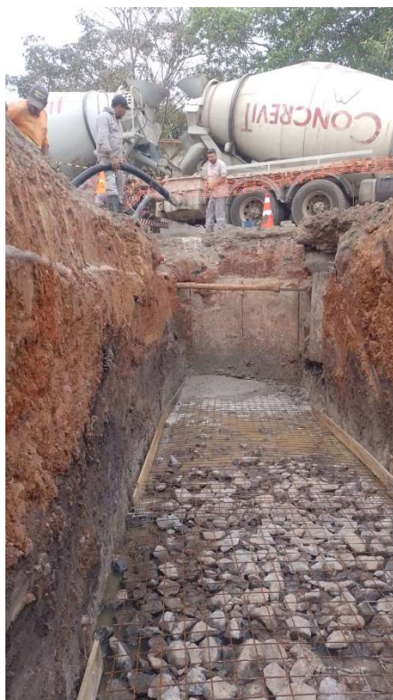
FORNECIMENTO, PREPARO E APLICAÇÃO DE CONCRETO FCK = 30 MPA
