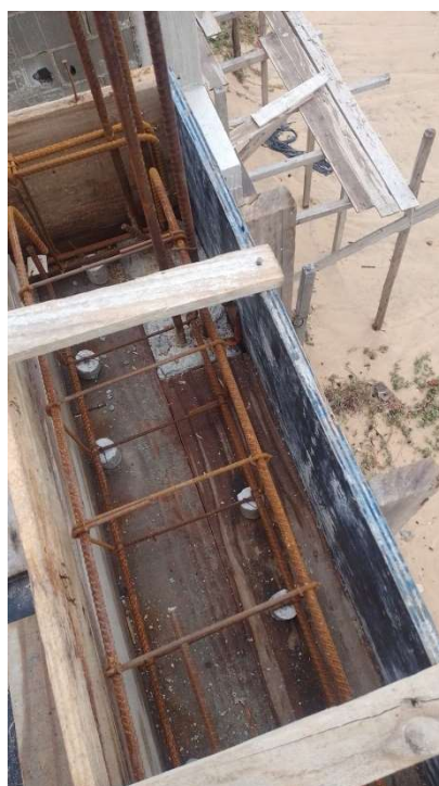
FORNECIMENTO, DOBRAGEM E COLOCAÇÃO EM FÔRMA, DE ARMADURA CA-60 B FINA, DIÂMETRO DE 4.0 A 7.0MM - ESTRIBOS
