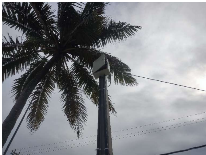
QUADRO DE DISTRIBUIÇÃO DE ENERGIA EM PVC (30X30X15CM), DE SOBREPOR, COMPLETO
