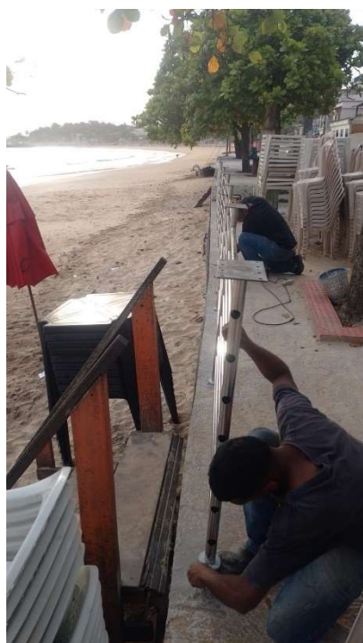
GUARDA CORPO EM AÇO INOX COM PASSA MÃO EM MADEIRA
