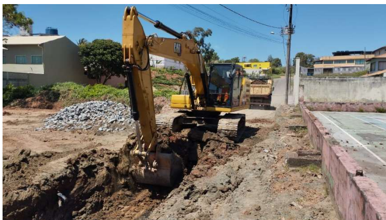
ESCAVAÇÃO MECÂNICA DE VALA EM MATERIAL DE 1ª CATEGORIA
