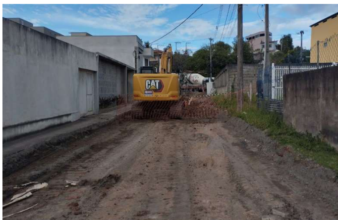
ESCAVAÇÃO MECÂNICA COM RETROESCAVADEIRA EM MATERIAL DE 1ª CATEGORIA
