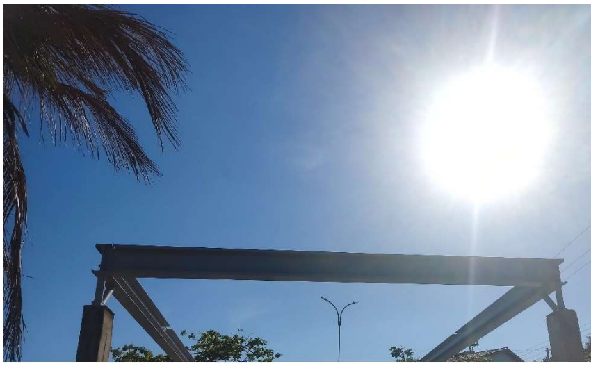
FORNECIMENTO DE ESTRUTURA METÁLICA EM PERFIL LAMINADO, INCLUSIVE FABRICAÇÃO, TRANSPORTE E MONTAGEM
