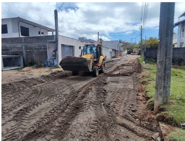
PÓ DE PEDRA INCLUSIVE FORNECIMENTO, ESPALHAMENTO E TRANSPORTE
