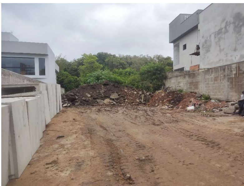
ENTULHO PARA REMOÇÃO PARA BOTA FORA.
