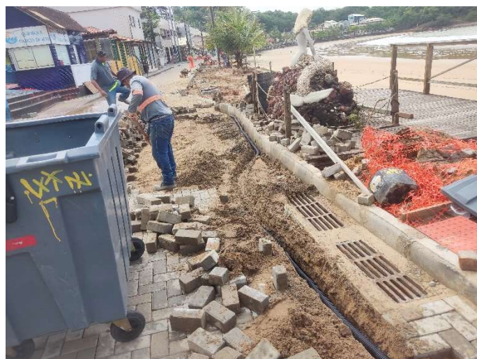
ESCAVAÇÃO MANUAL EM MAT. 1ª CAT. H= 0,00 A 1,50 M
