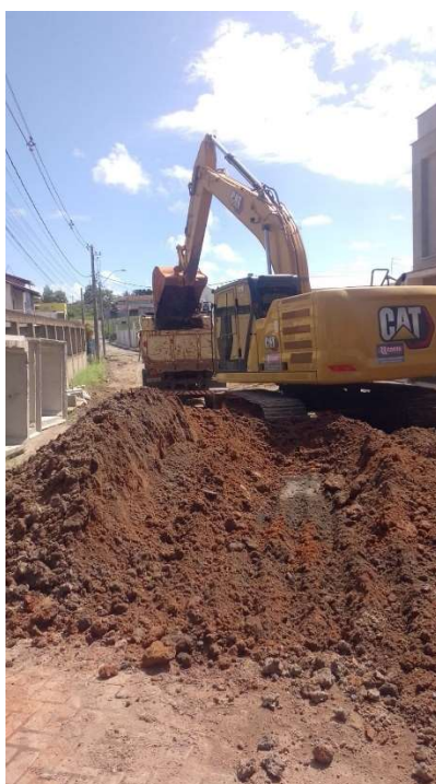
ESCAVAÇÃO MECÂNICA DE VALA EM MATERIAL DE 1ª CATEGORIA
