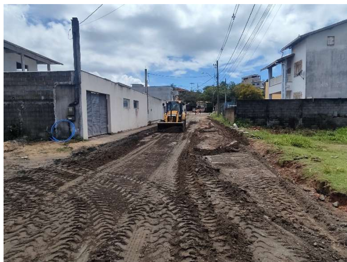
ESCAVAÇÃO MECÂNICA COM RETROESCAVADEIRA EM MATERIAL DE 1ª CATEGORIA
