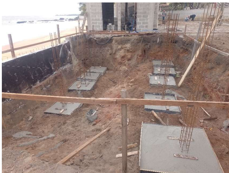
FORNECIMENTO E APLICAÇÃO DE CONCRETO USINADO FCK=30 MPA - CONSIDERANDO LANÇAMENTO MANUAL PARA INFRA-ESTRUTURA
