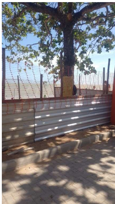
TAPUME TELHA METÁLICA ONDULADA 0,50MM
