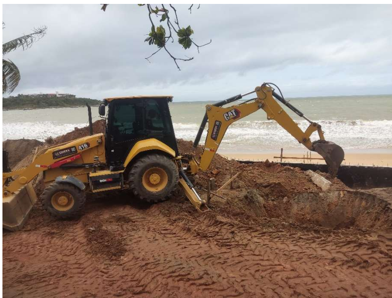
ESCAVAÇÃO MECÂNICA DE VALA EM MATERIAL DE 1ª CATEGORIA
