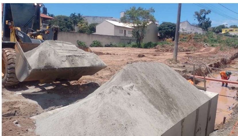
PÓ DE PEDRA INCLUSIVE FORNECIMENTO, ESPALHAMENTO E TRANSPORTE
