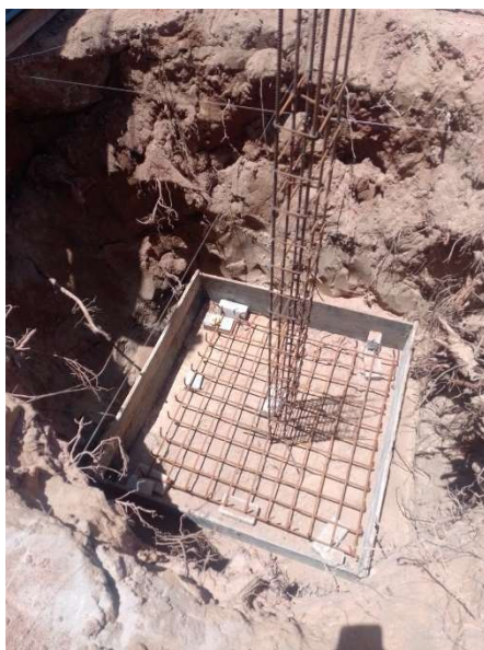
FORNECIMENTO, DOBRAGEM E COLOCAÇÃO EM FÔRMA, DE ARMADURA CA-50 A GROSSA DIÂMETRO DE 12.5 A 25.0 MM (1/2 A 1") - PILARES
