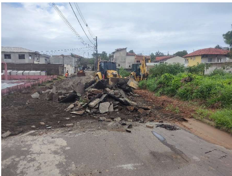
REMOÇÃO MECANIZADA DE CAPA ASFÁLTICA E MEIO FIO DE CONCRETO
