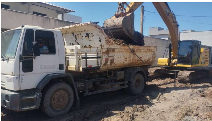
CARGA, MANOBRA E DESCARGA DE SOLOS E MATERIAIS GRANULARES EM CAMINHÃO BASCULANTE
