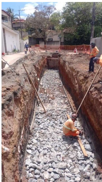
ENROCAMENTO DE PEDRA JOGADA - PEDRA DE MÃO PRODUZIDA - CONFEÇÃO E ASSENTAMENTO
