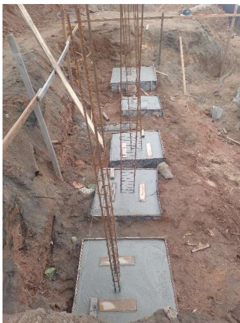
FORNECIMENTO E APLICAÇÃO DE CONCRETO USINADO FCK=30 MPA - CONSIDERANDO LANÇAMENTO MANUAL PARA INFRA-ESTRUTURA
