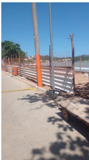
TAPUME TELHA METÁLICA ONDULADA 0,50MM
