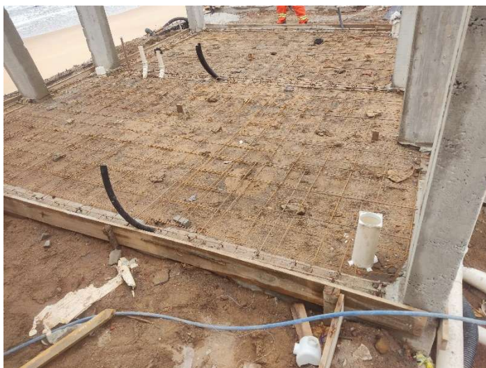
ARMAÇÃO PARA EXECUÇÃO DE RADIER, PISO DE CONCRETO OU LAJE SOBRE SOLO
