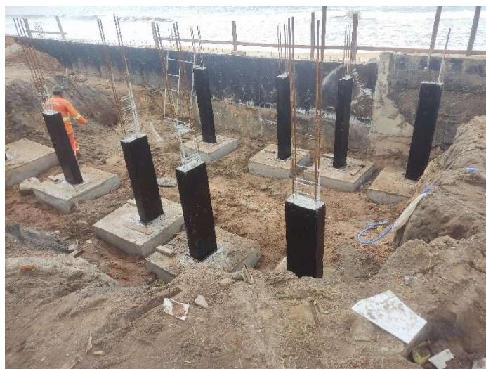
FORNECIMENTO E APLICAÇÃO DE CONCRETO USINADO FCK=30 MPA - CONSIDERANDO BOMBEAMENTO
