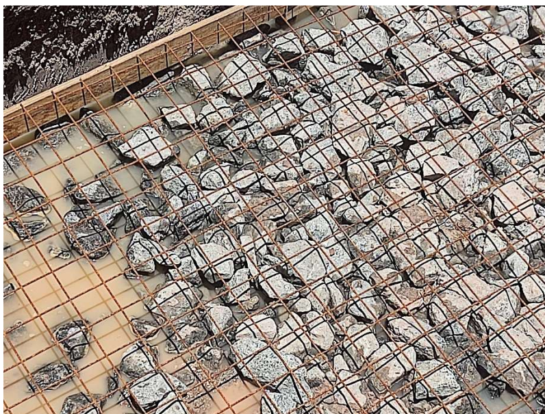
AÇO CA-50, FORNECIMENTO, DOBRAGEM E COLOCAÇÃO NAS FORMAS
