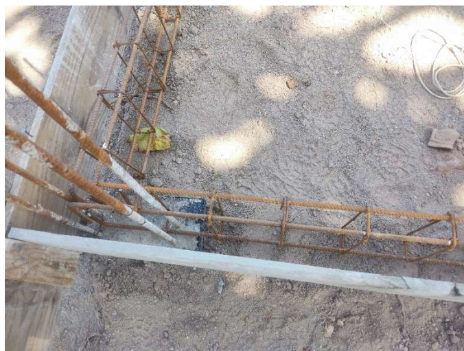
FORNECIMENTO, DOBRAGEM E COLOCAÇÃO EM FÔRMA, DE ARMADURA CA-60 B FINA, DIÂMETRO DE 4.0 A 7.0MM – ESTRIBOS
