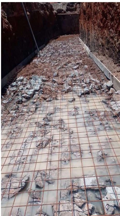
AÇO CA-50, FORNECIMENTO, DOBRAGEM E COLOCAÇÃO NAS FORMAS
