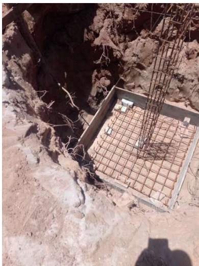
FORNECIMENTO, DOBRAGEM E COLOCAÇÃO EM FÔRMA, DE ARMADURA CA-50 A MÉDIA, DIÂMETRO DE 6.3 A 10.0 MM - SAPATAS
