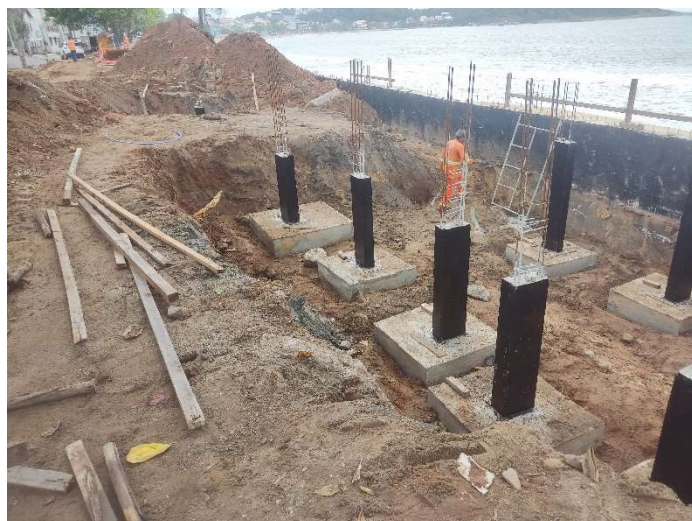
FORNECIMENTO, PREPARO E APLICAÇÃO DE CONCRETO MAGRO + CONCRETO DA SAPATAS (TUDO JUNTO)
