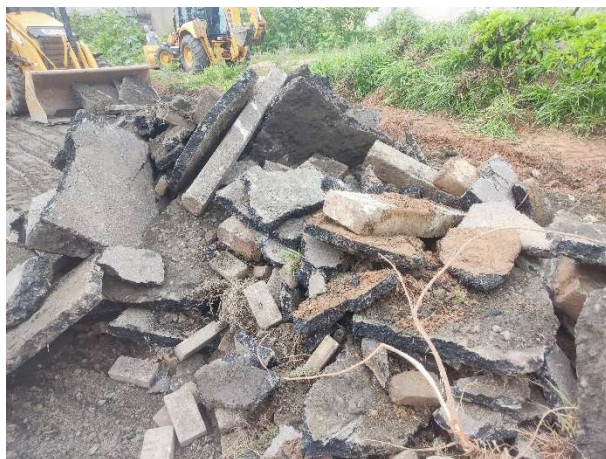
REMOÇÃO MECANIZADA DE CAPA ASFÁLTICA E MEIO FIO DE CONCRETO
