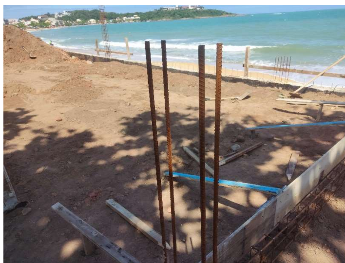
FORNECIMENTO, DOBRAGEM E COLOCAÇÃO EM FÔRMA, DE ARMADURA CA-50 A GROSSA DIÂMETRO DE 12.5 A 25.0 MM (1/2 A 1")
