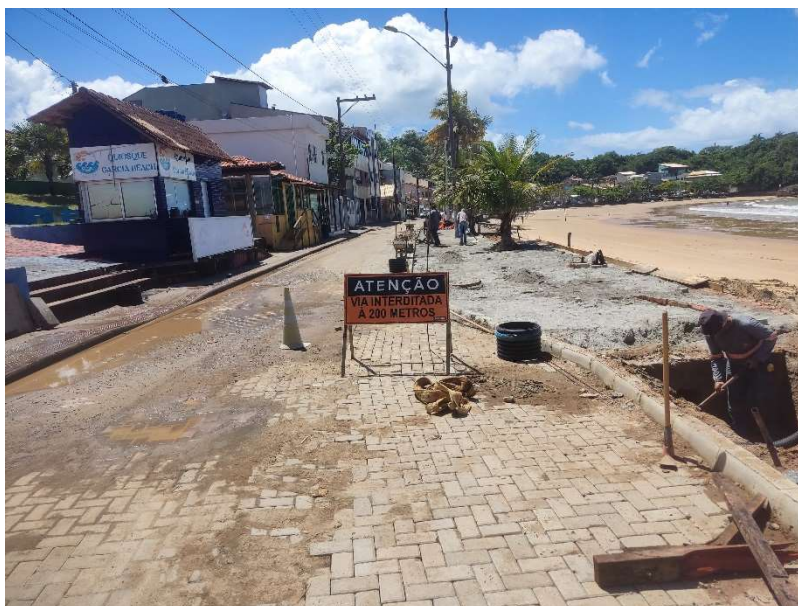
SINALIZAÇÃO VERTICAL COM CHAPA REVESTIDA EM PELÍCULA, INCLUSIVE SUPORTE EM MADEIRA
