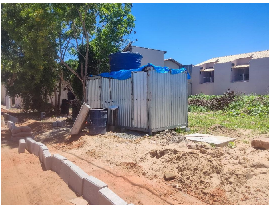
CONTAINER PARA ALMOXARIFADO
