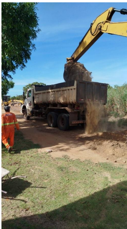
ESCAVAÇÃO MECÂNICA EM MATERIAL DE 1ª CATEGORIA
