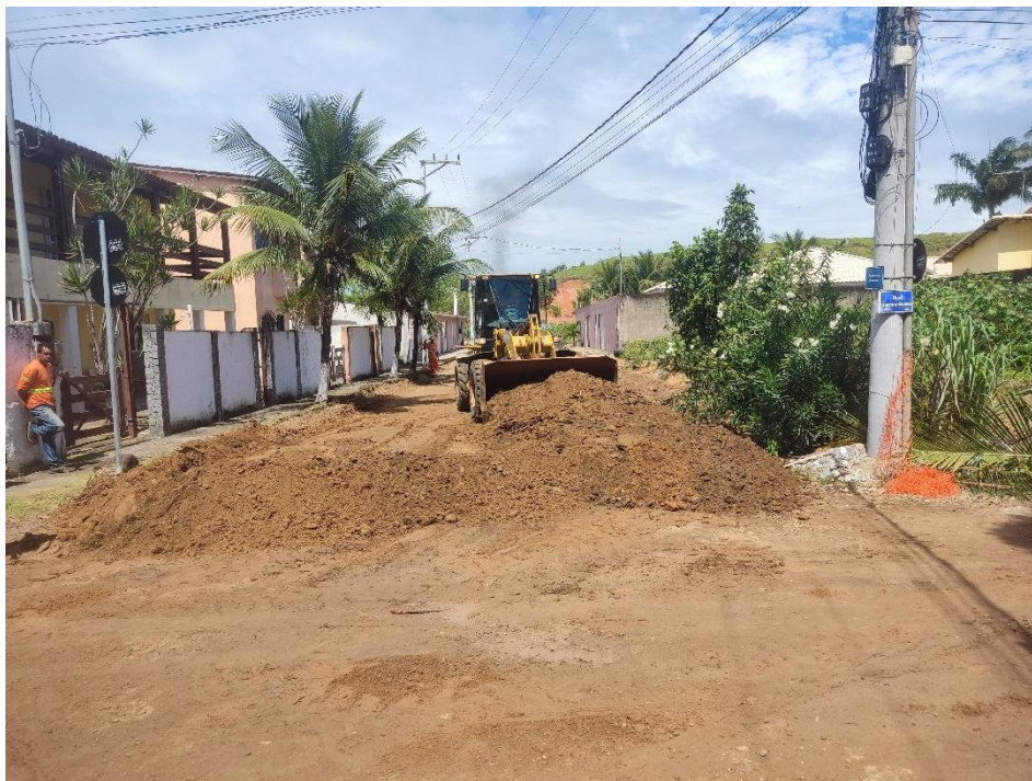
ESCAVAÇÃO MECÂNICA EM MATERIAL DE 1ª CATEGORIA
