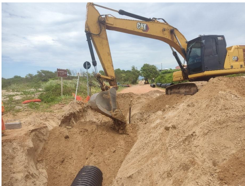
ESCAVAÇÃO MECÂNICA DE VALA EM MATERIAL DE 1ª CATEGORIA
