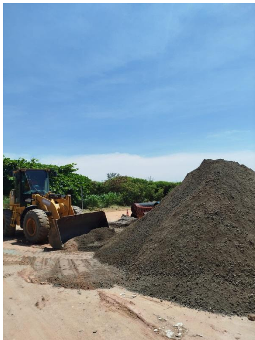
CARGA, MANOBRA E DESCARGA DE SOLOS E MATERIAIS GRANULARES
