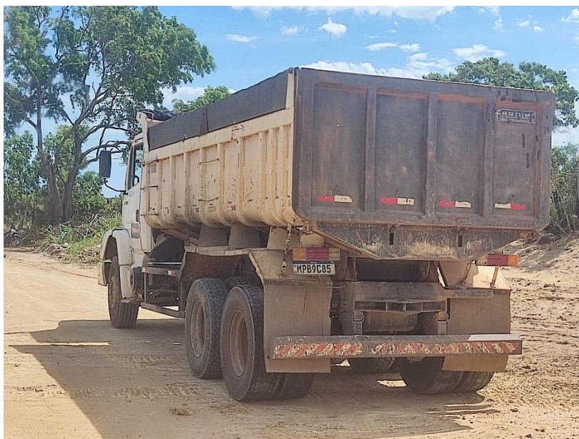
TRANSPORTE DE BRITA GRADUADA DA BASE
