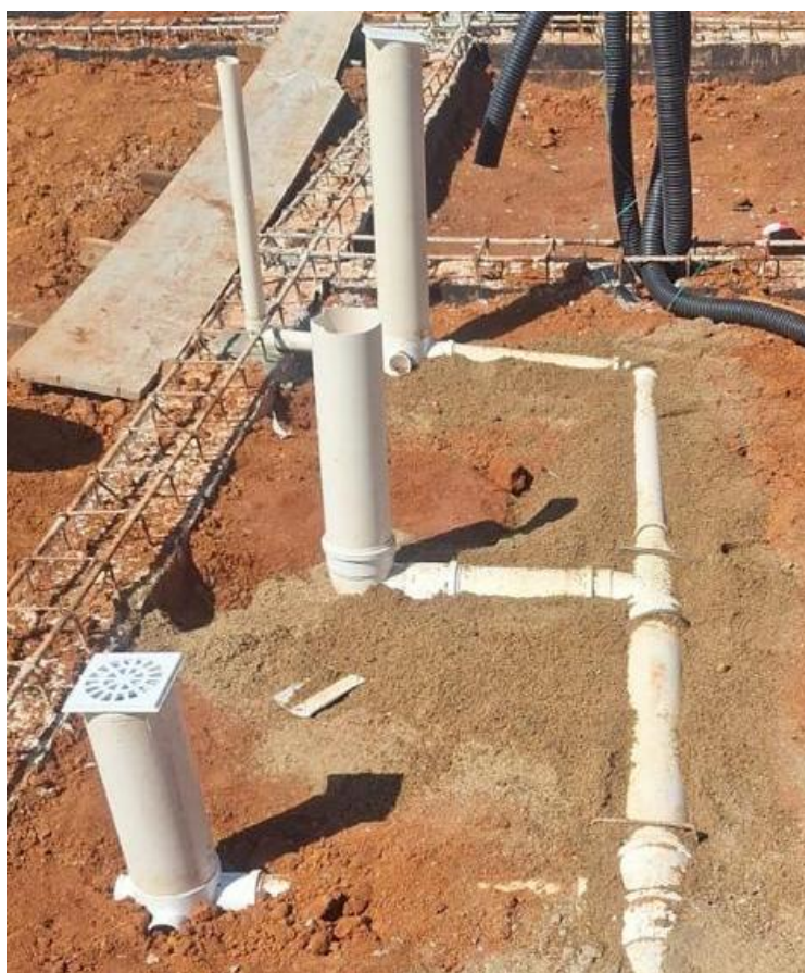
Caixa sifonada, pvc, dn 100 x 100 x 50 mm, junta elástica, fornecida e instalada em ramal de descarga ou em ramal de esgoto sanitário. Af_08/2022
