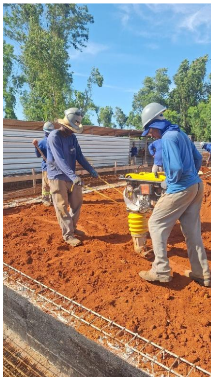
Compactação de aterros a 100% do Proctor intermediário
