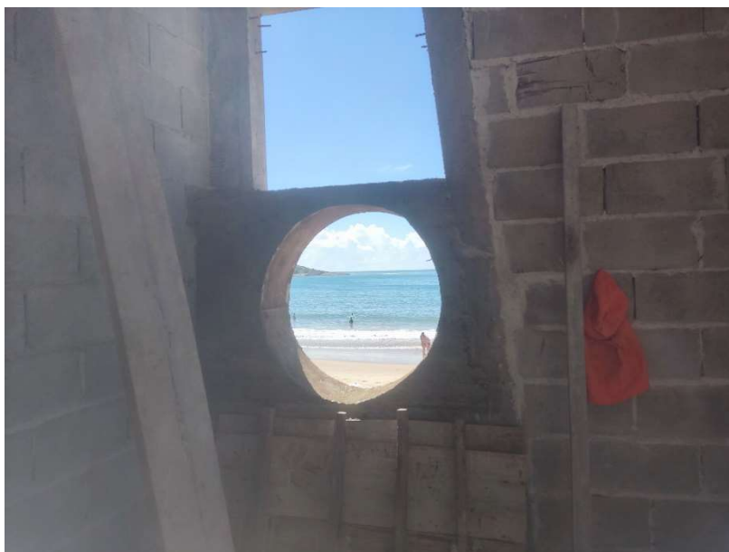
VERGA/CONTRAVERGA RETA DE CONCRETO ARMADO 10 X 5 CM, FCK = 15 MPA, INCLUSIVE FORMA, ARMAÇÃO E DESFORMA
