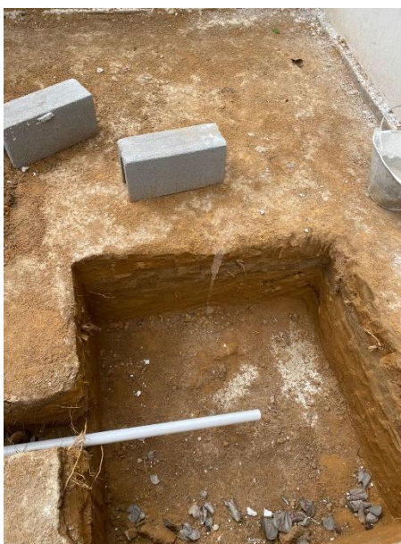
Figura 61 e 62: ITEM 04.08.01 – PONTO PARA ESGOTO SECUNDÁRIO
