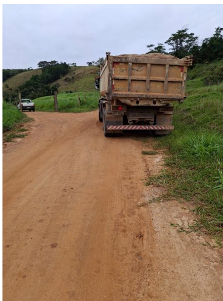
Figura 17 e 18: ITEM 02.07 – TRANSPORTE CAMINHÃO BASCULANTE VIA NÃO PAVIMENTADA
