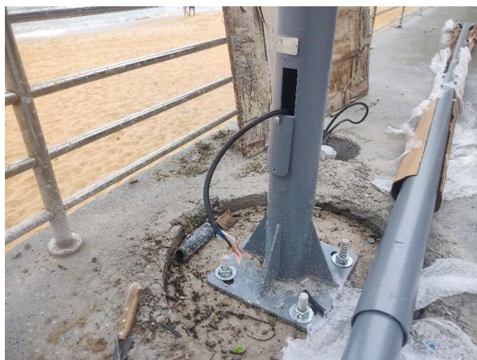
FIO OU CABO DE COBRE TERMOPLÁSTICO, COM ISOLAMENTO PARA 750V, SEÇÃO DE 2,5 E 4.0 MM 2
