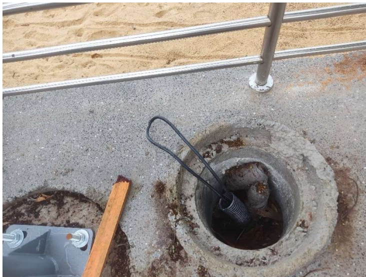
CABO DE COBRE TERMOPLÁSTICO (PVC) FLEXÍVEL ISOLADO 0,6/1KV, ANTI-CHAMA 90°C HEPR - 2,5MM 2
