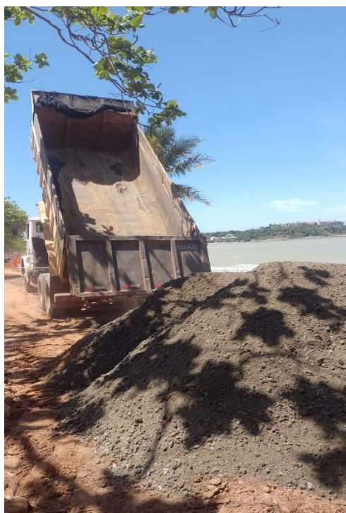
TRANSPORTE COM CAMINHÃO BASCULANTE - BASE
