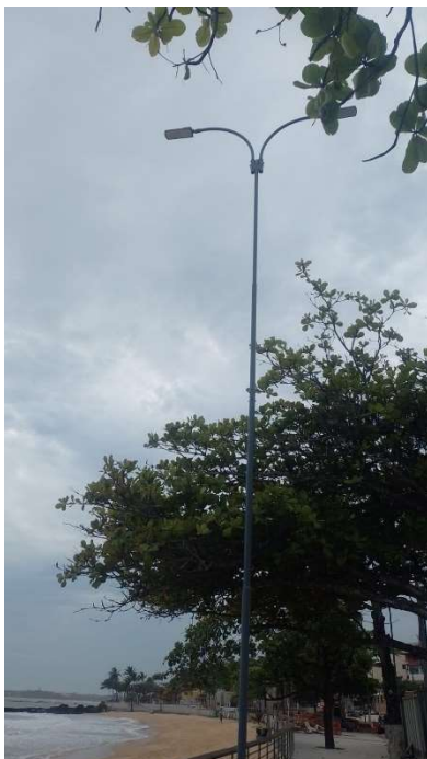
POSTE DE AÇO CÔNICO CONTÍNUO CURVO DUPLO DE 12M PARA 2 LUMINÁRIA PÚBLICA LED, INCLUSIVE RELÉ, FORNECIMENTO E INSTALAÇÃO.
