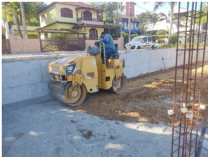
BASE DE BRITA GRADUADA SOB OS PASSEIOS
