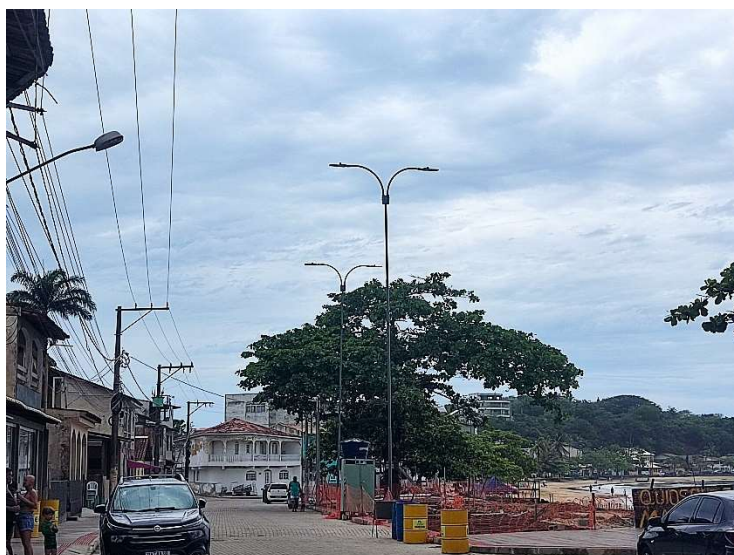
POSTE DE AÇO CÔNICO CONTÍNUO CURVO DUPLO DE 12M PARA 2 LUMINÁRIA PÚBLICA LED, INCLUSIVE RELÉ, FORNECIMENTO E INSTALAÇÃO.
