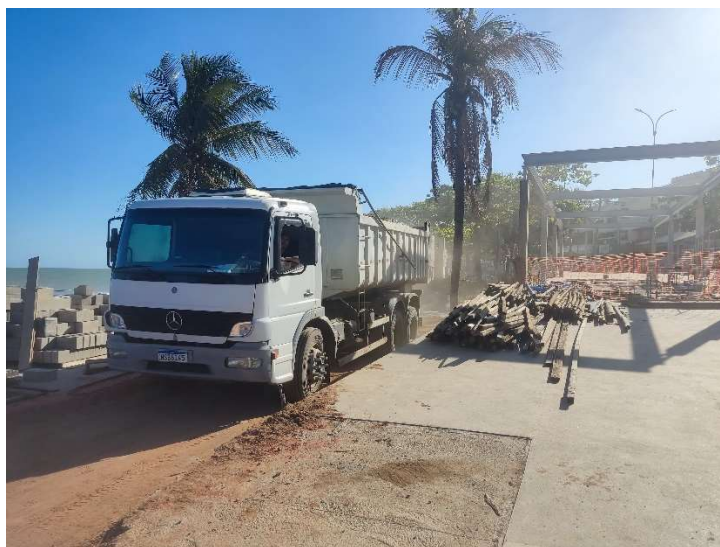
TRANSPORTE COM CAMINHÃO BASCULANTE - BASE
