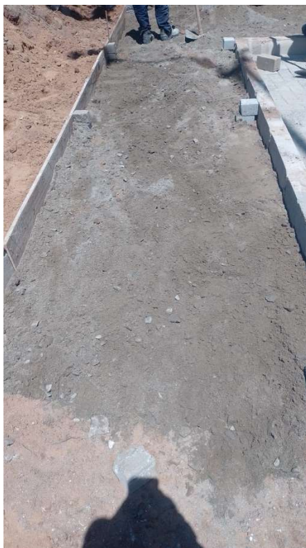
BASE DE BRITA GRADUADA SOB OS PASSEIOS
