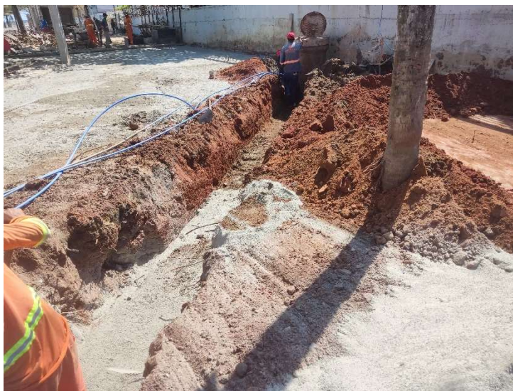
ESCAVAÇÃO MANUAL EM MAT. 1ª CAT. H= 0,00 A 1,50 M
