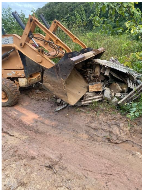
Figura 7 e 8: ITEM 02.03 – DEMOLIÇÃO
