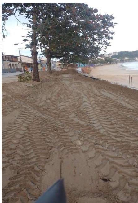
PÓ DE PEDRA INCLUSIVE FORNECIMENTO, ESPALHAMENTO
