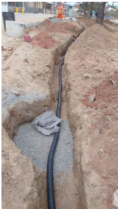
ELETRODUTO PEAD, COR PRETA, DIAM. 1.1/2" + ESCAVAÇÃO MANUAL DE VALA
