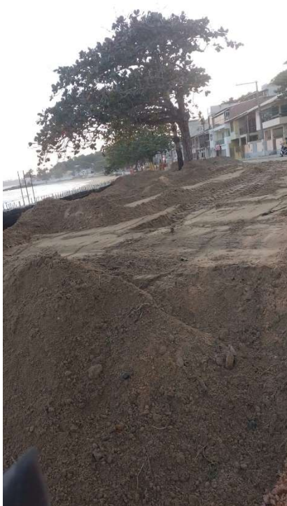
BASE DE BRITA GRADUADA SOB O CALÇADÃO
