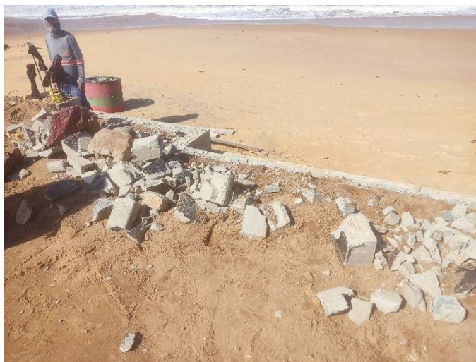
DEMOLIÇÃO MANUAL DE CONCRETO
