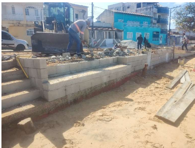
DEMOLIÇÃO MANUAL DE CONCRETO
