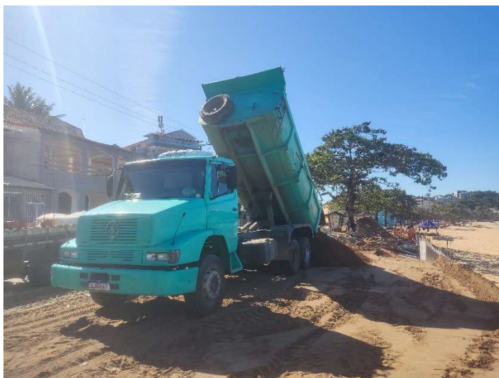
TRANSPORTE DA BRITA GRADUADA PARA BASE
