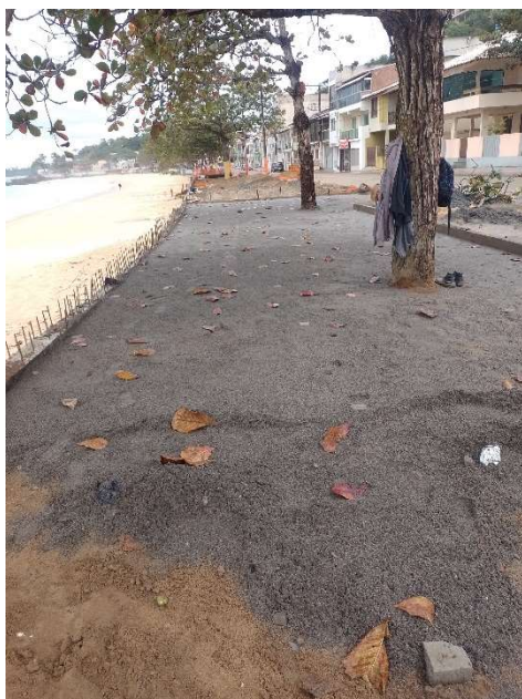
BASE DE BRITA GRADUADA SOB O CALÇADÃO
