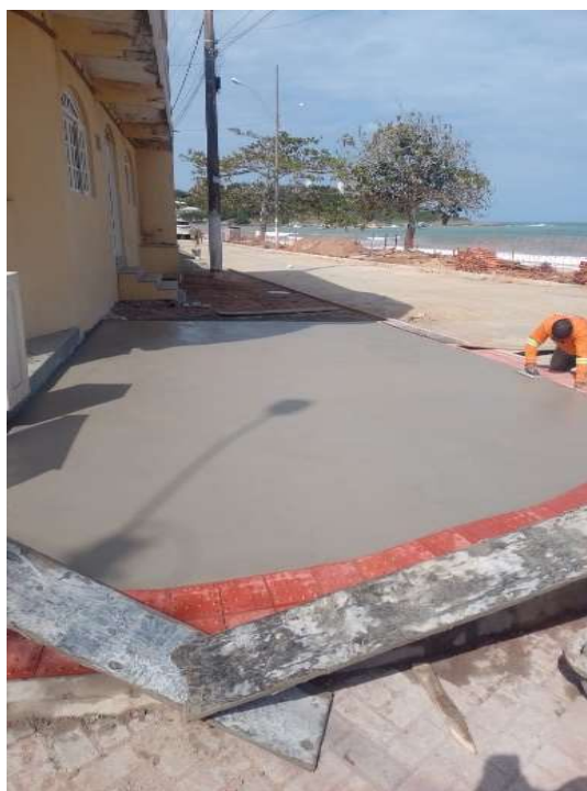
PASSEIO - PISO DE CONCRETO COM CONCRETO MOLDADO IN LOCO, USINADO, ACABAMENTO CONVENCIONAL, ESPESSURA 8 CM
