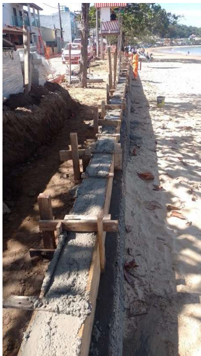
FORMA DE CHAPAS MADEIRA COMPENSADA RESINADA, ESP. 12MM,
