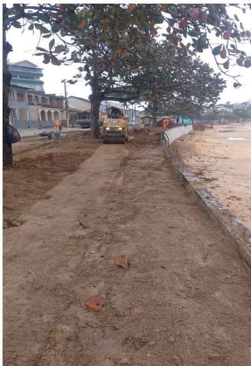
COMPACTAÇÃO DE ATERRO
