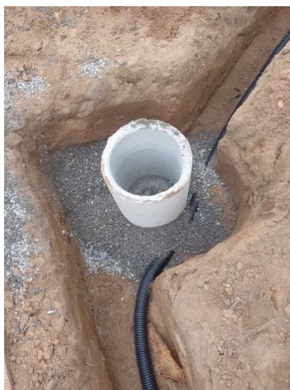
ELETRODUTO PEAD, COR PRETA, DIAM. 1.1/2" + ESCAVAÇÃO MANUAL DE VALA
