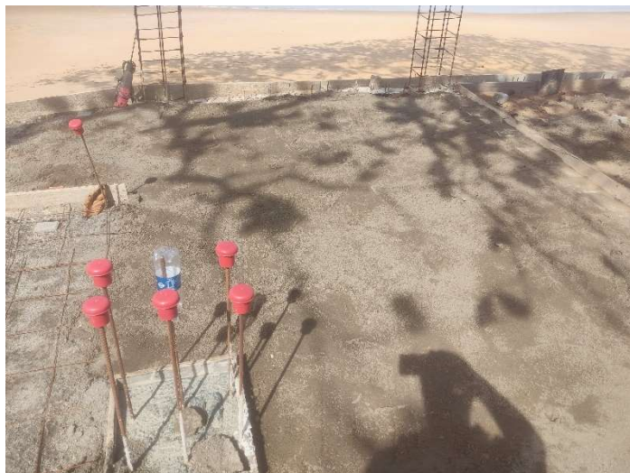
PÓ DE PEDRA INCLUSIVE FORNECIMENTO, ESPALHAMENTO
