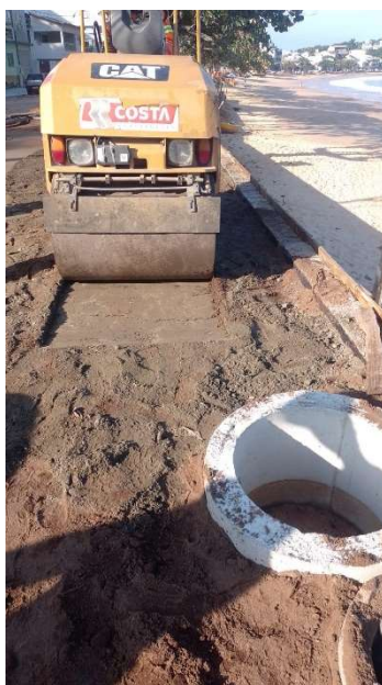
COMPACTAÇÃO DE ATERRO
