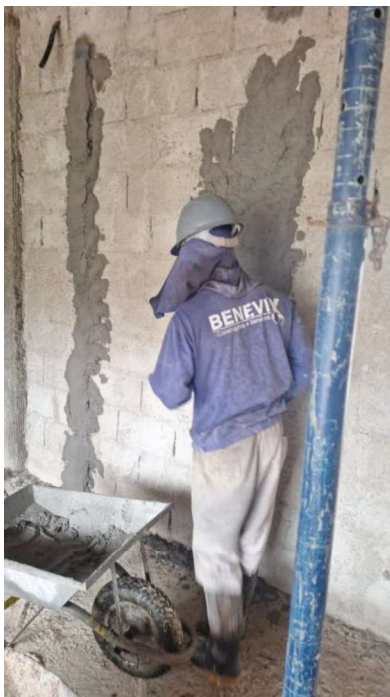
CHAPISCO DE ARGAMASSA DE CIMENTO E AREIA MÉDIA OU GROSSA LAVADA NO TRAÇO 1:3, ESPESSURA 5MM, COM UTILIZAÇÃO DE IMPERMEABILIZANTE
