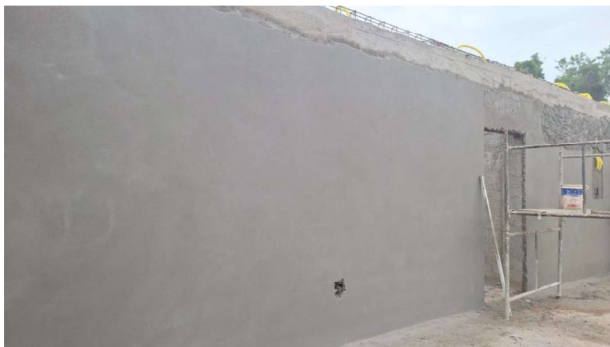
REBOCO TIPO PAULISTA DE ARGAMASSA DE CIMENTO, CAL HIDRATADA CH1 E AREIA MÉDIA OU GROSSA LAVADA NO TRAÇO 1:0.5:6, ESPESSURA 25 MM
