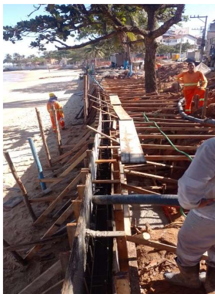
FORMA DE CHAPAS MADEIRA COMPENSADA RESINADA, ESP. 12MM
