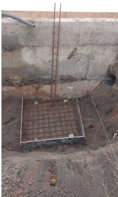
FORMAS EM MADEIRA PARA FUNDAÇÃO
