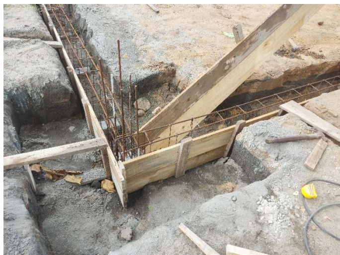
FUNDAÇÃO REATERRADA COMPACTADA
