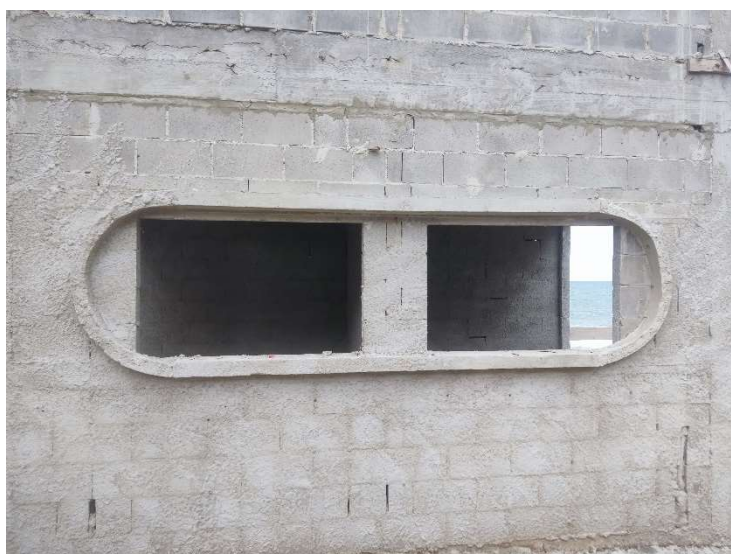
VERGA/CONTRAVERGA RETA DE CONCRETO ARMADO 10 X 5 CM
