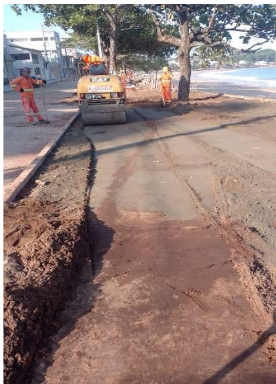
COMPACTAÇÃO DE ATERRO
