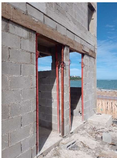
ALVENARIA DE BLOCOS DE CONCRETO 9X19X39CM
