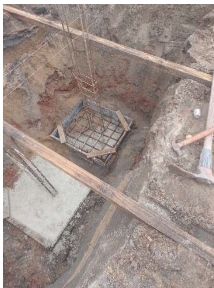
FORNECIMENTO, DOBRAGEM E COLOCAÇÃO EM FÔRMA, DE ARMADURA CA-50 A GROSSA DIÂMETRO DE 12.5 A 25.0 MM (1/2 A 1")
