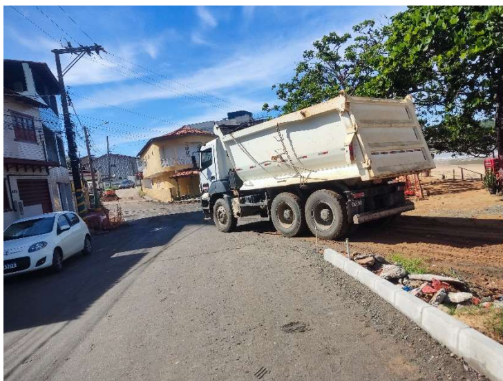
TRANSPORTE DA BRITA GRADUADA PARA BASE
