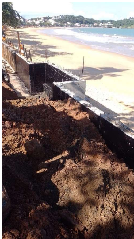
REATERRO COMPACTADO DO MURO
