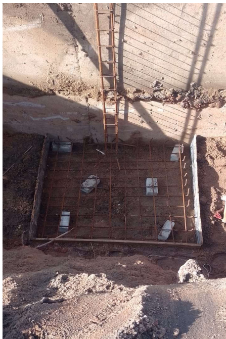
FORMAS EM MADEIRA PARA FUNDAÇÃO
