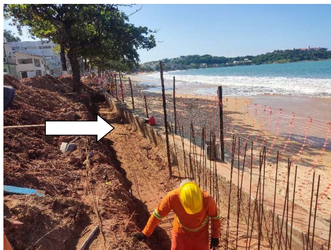
FUNDO APILOADO DE VALA
