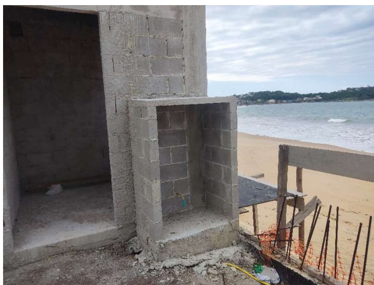
ALVENARIA DE BLOCOS DE CONCRETO 9X19X39CM
