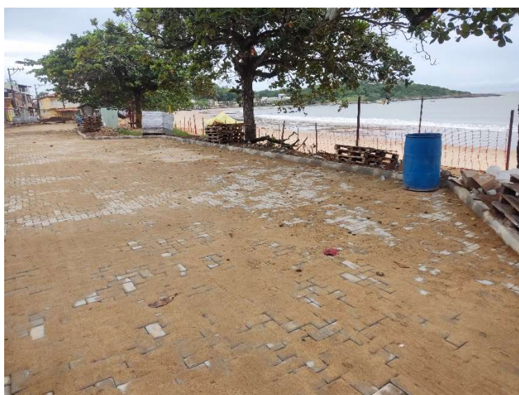
PAVIMENTAÇÃO COM BLOCOS DE CONCRETO (35 MPA), ESP.= 08 CM, COLCHÃO AREIA ESP.= 5CM,
