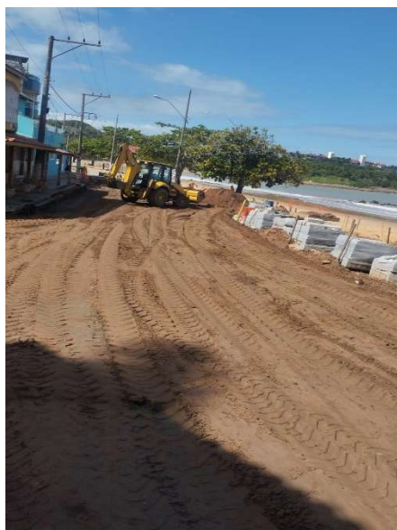
ESTABILIZAÇÃO GRANULOMÉTRICA DE SOLO S/ MISTURA
