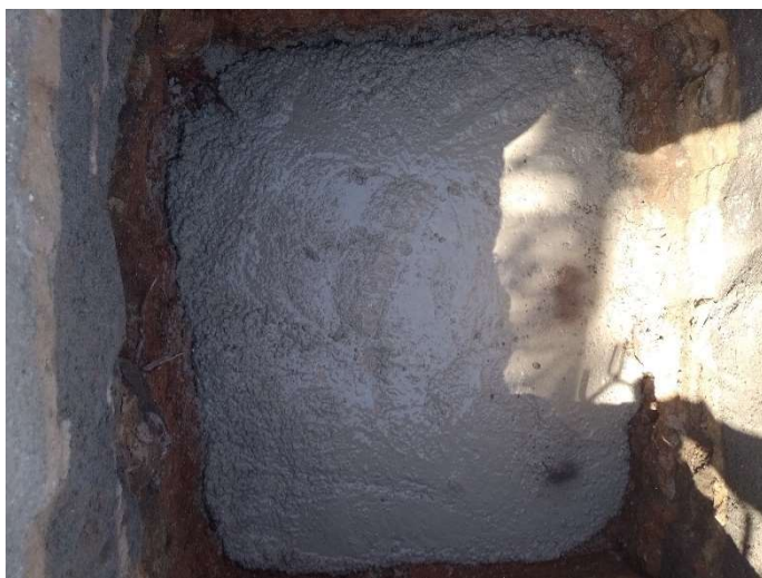
CONCRETO MAGRO PARA FUNDAÇÃO
