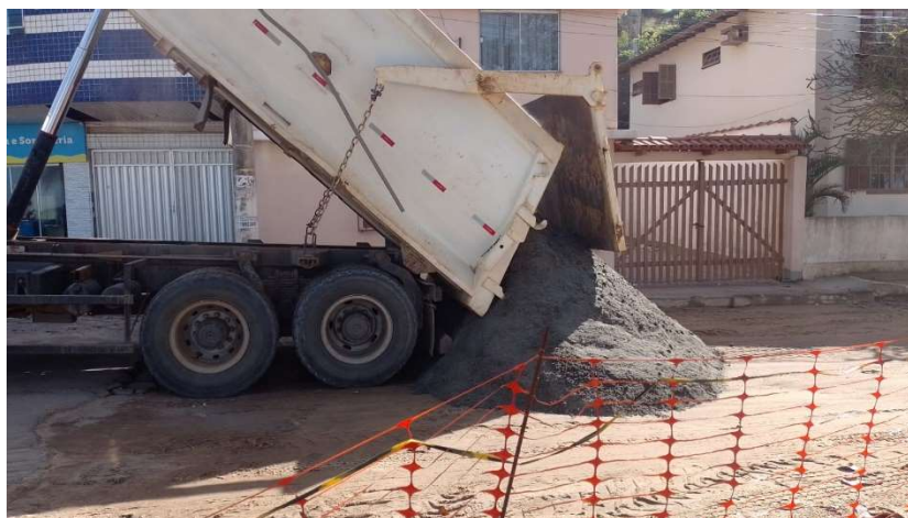
TRANSPORTE DA BRITA GRADUADA PARA BASE
