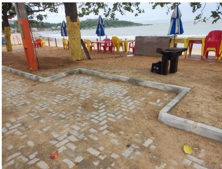
PAVIMENTAÇÃO COM BLOCOS DE CONCRETO (35 MPA), ESP.= 08 CM, COLCHÃO AREIA ESP.= 5CM,I
