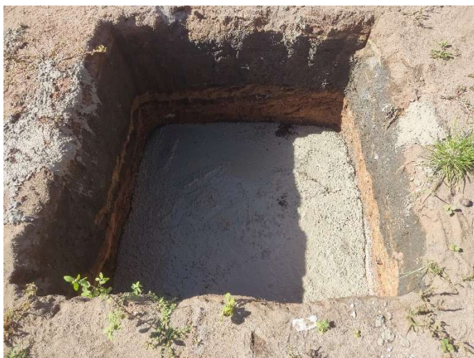
CONCRETO MAGRO PARA FUNDAÇÃO
