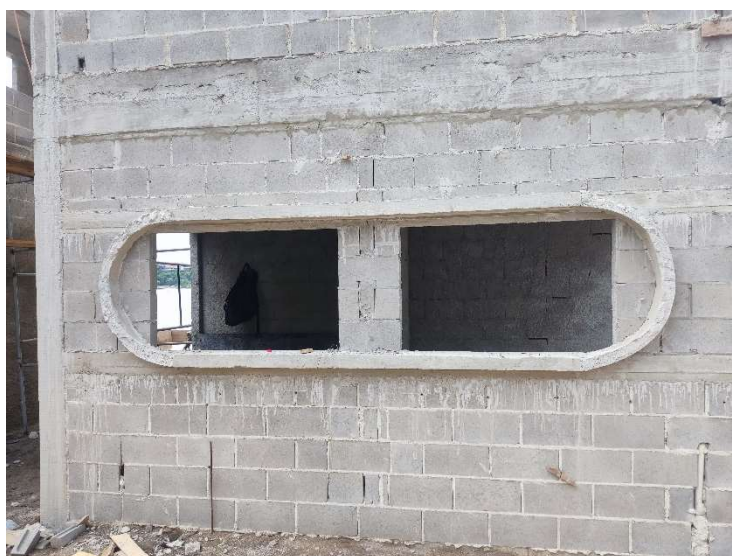
ALVENARIA DE BLOCOS CERÂMICOS 10 FUROS 10X20X20CM( DETALHE DA JANELA DOS BANHEIROS)
