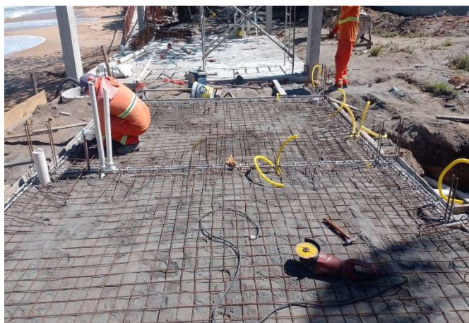
ARMAÇÃO PARA EXECUÇÃO DE RADIER, PISO DE CONCRETO OU LAJE SOBRE SOLO
