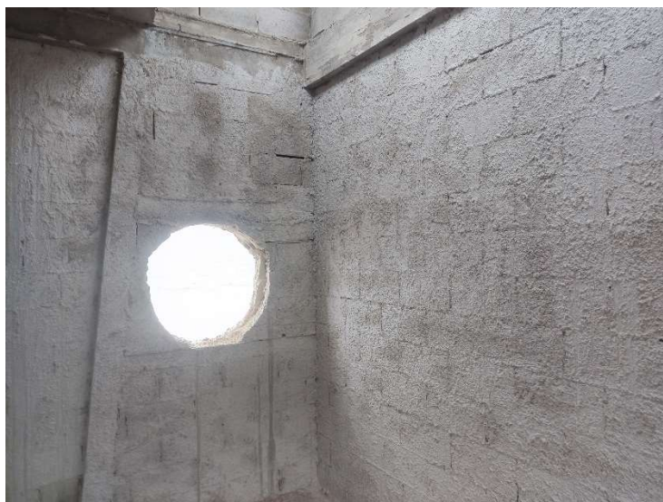
CHAPISCO DE ARGAMASSA DE CIMENTO E AREIA MÉDIA OU GROSSA LAVADA, NO TRAÇO 1:3, ESPESSURA 5 MM
