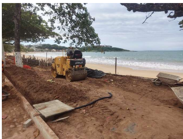
COMPACTAÇÃO DE ATERRO
