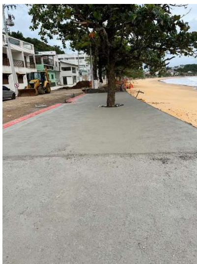
CALÇADÃO DA ORLA - PISO DE CONCRETO COM CONCRETO MOLDADO IN LOCO, USINADO, ACABAMENTO CONVENCIONAL, ESPESSURA 8 CM
