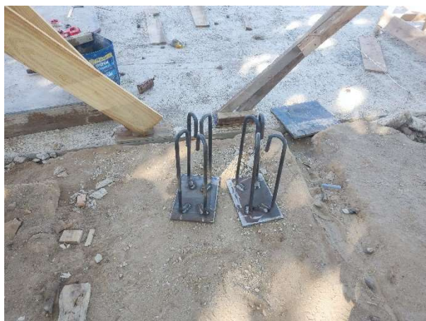
ESTRUTURA METÁLICA EM PERFIL LAMINADO
