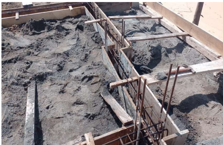
FORMAS DE MADEIRA - VIGAS
