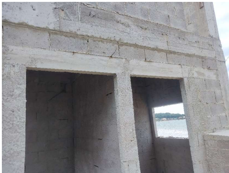
VERGA/CONTRAVERGA RETA DE CONCRETO ARMADO 10 X 5 CM
