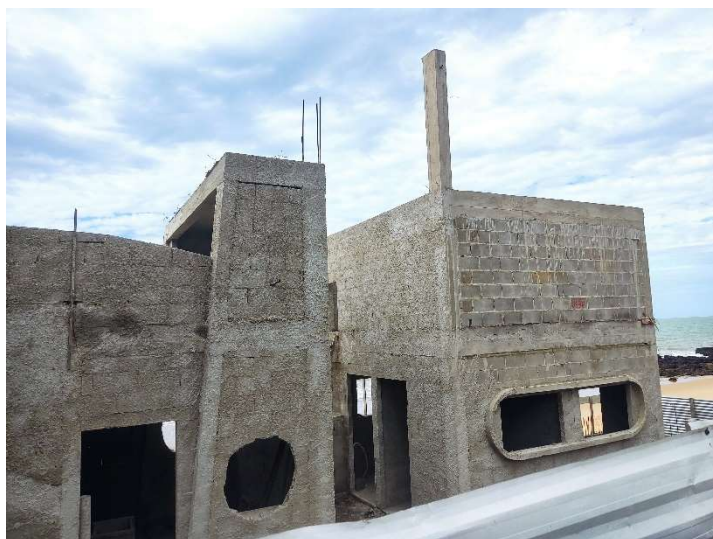
ALVENARIA DE BLOCOS DE CONCRETO 9X19X39CM
