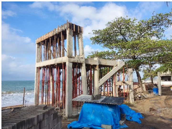
FORMAS DE MADEIRA - LAJES
