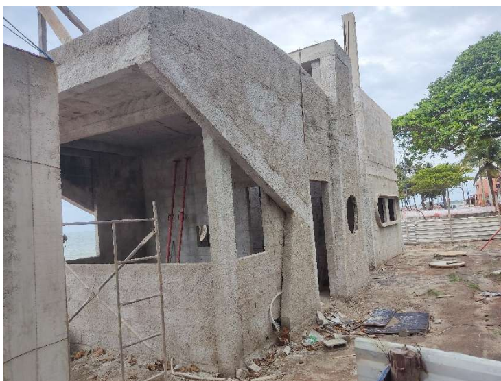
CHAPISCO DE ARGAMASSA DE CIMENTO E AREIA MÉDIA OU GROSSA LAVADA, NO TRAÇO 1:3, ESPESSURA 5 MM
