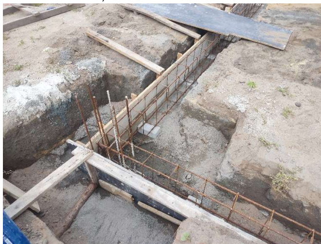
FORNECIMENTO, DOBRAGEM E COLOCAÇÃO EM FÔRMA, DE ARMADURA CA-60 B FINA, DIÂMETRO DE 4.0 A 7.0MM
