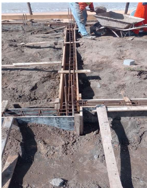
FORNECIMENTO, DOBRAGEM E COLOCAÇÃO EM FÔRMA, DE ARMADURA CA-50 A GROSSA, DIÂMETRO DE 12.5 A 25.0MM
