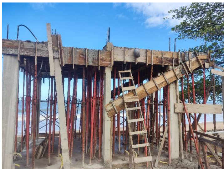
FORMAS DE MADEIRA - VIGAS
