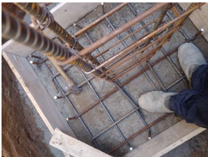
FORMAS EM MADEIRA PARA FUNDAÇÃO
