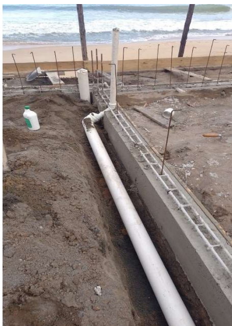
TUBO DE PVC RÍGIDO SOLDÁVEL BRANCO, PARA ESGOTO, DIÂMETRO 100MM
