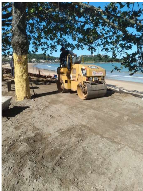
COMPACTAÇÃO DE ATERRO
