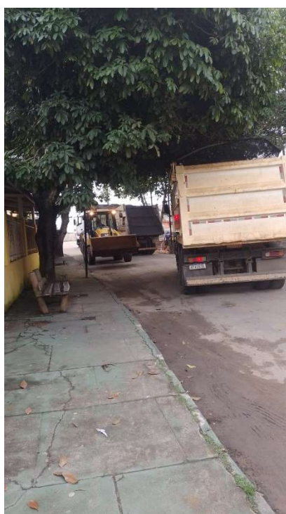
TRANSPORTE DA BRITA GRADUADA PARA BASE
