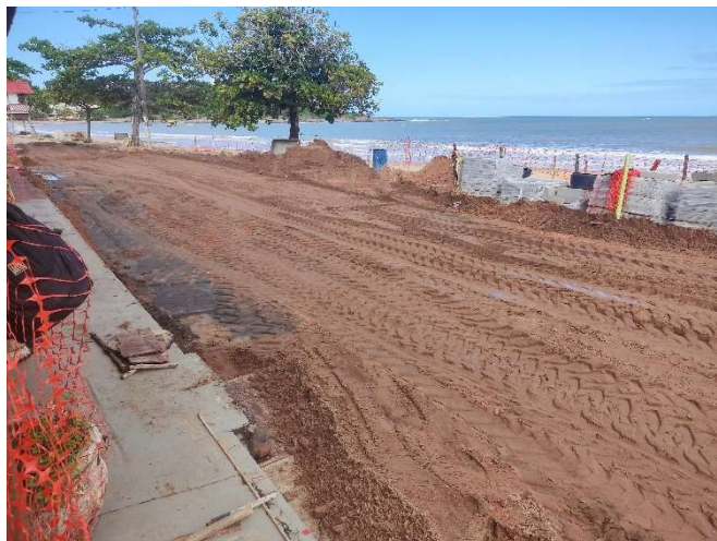
ESTABILIZAÇÃO GRANULOMÉTRICA DE SOLO S/ MISTURA
