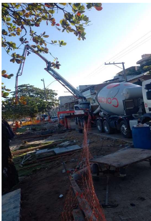
FORNECIMENTO E APLICAÇÃO DE CONCRETO USINADO FCK=30 MPA - CONSIDERANDO BOMBEAMENTO
