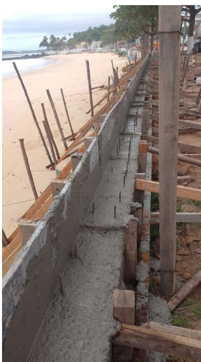
FORNECIMENTO E APLICAÇÃO DE CONCRETO USINADO FCK=30 MPA - CONSIDERANDO BOMBEAMENTO
