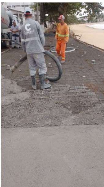
CALÇADÃO DA ORLA - PISO DE CONCRETO COM CONCRETO MOLDADO IN LOCO, USINADO, ACABAMENTO CONVENCIONAL, ESPESSURA 8 CM
