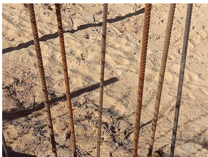
FORNECIMENTO, DOBRAGEM E COLOCAÇÃO EM FÔRMA, DE ARMADURA CA-50 A GROSSA DIÂMETRO DE 12.5 A 25.0 MM (1/2 A 1")
