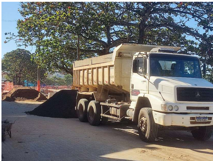
TRANSPORTE DA BRITA GRADUADA PARA BASE
