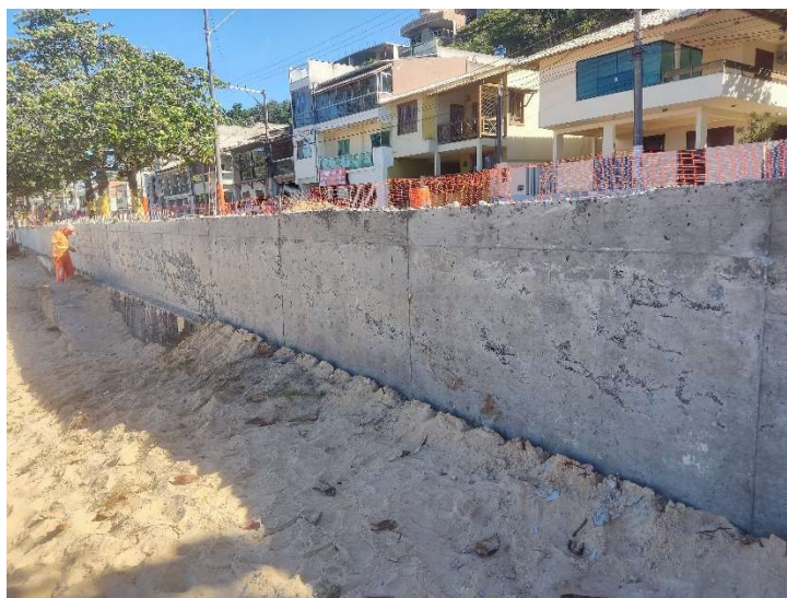
FORNECIMENTO E APLICAÇÃO DE CONCRETO USINADO FCK=30 MPA - CONSIDERANDO BOMBEAMENTO
