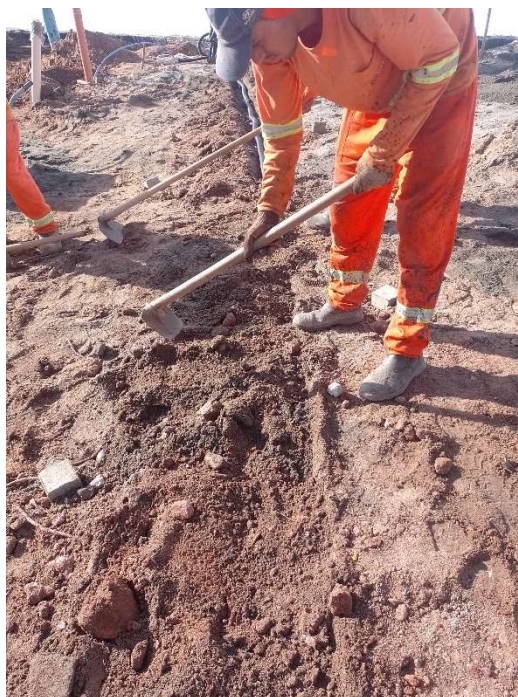
REATERRO DE CAVAS C/ COMPACTAÇÃO MANUAL
