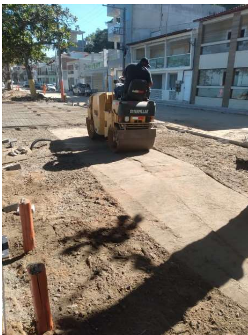
COMPACTAÇÃO DE ATERRO
