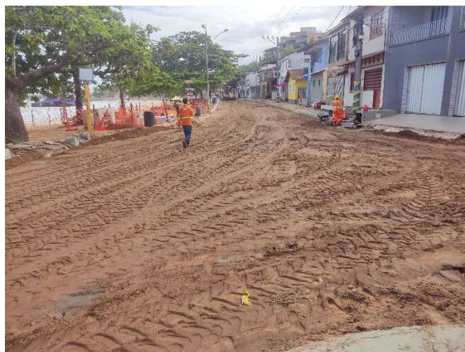
ESTABILIZAÇÃO GRANULOMÉTRICA DE SOLO S/ MISTURA
