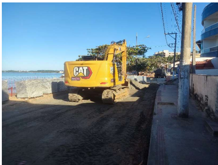
ESCAVAÇÃO MECÂNICA EM MATERIAL DE 1ª CATEGORIA
