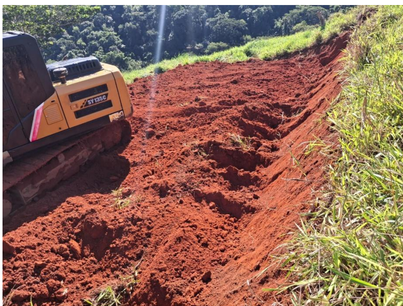
Figura 45 e 46: ITEM 04.01.01 – ESCAVAÇÃO MECÂNICA
