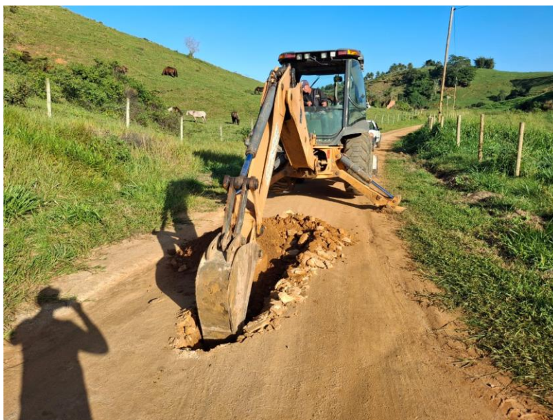
Figura 31 e 32: ITEM 03.02 – ESCAVAÇÃO MECANIZADA
