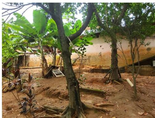
Figura 13 – Marca d'água mostrando o nível estático que o rio Itapemirim ficou após a sua última cheia (8m).
