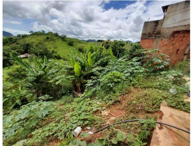
Figura 7 – Construção sobre aterro lançado e muito próxima da quebra de relevo.
