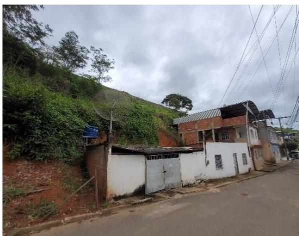
Figura 4 – Casas com cortes subverticais e muito próximas da encosta.
