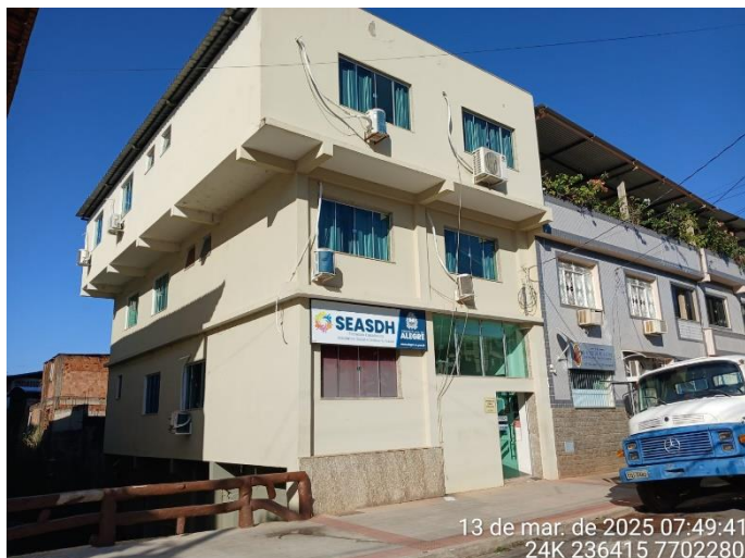
Foto 01: Fachada da Edificação.
