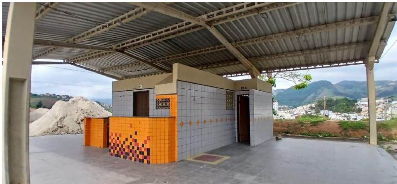
Foto 03: Foto das instalações do Bar 02 (não ocupado). Fonte: Acervo SEOSU, Nov./2024.
