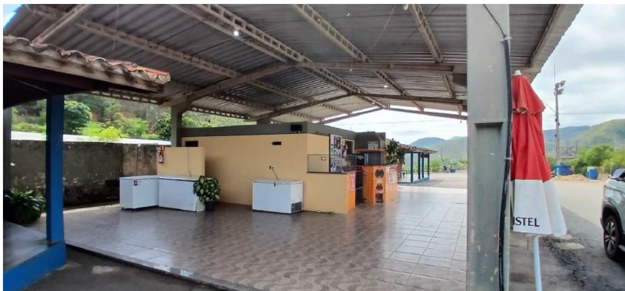
Foto 01: Instalações do Bar 01 (em uso). Fonte: Acervo SEOSU, Nov./2024.
