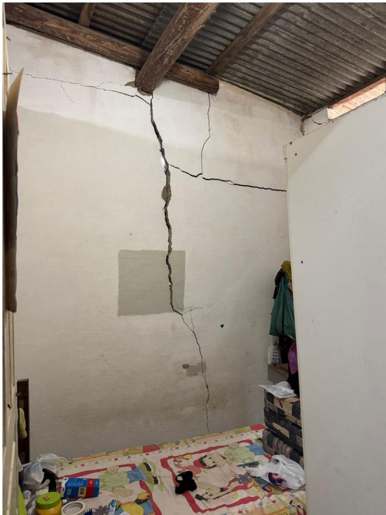
Figura 3 – Fenda vertical com trincas horizontais na parede proximo a estrutura de madeira do telhado.
