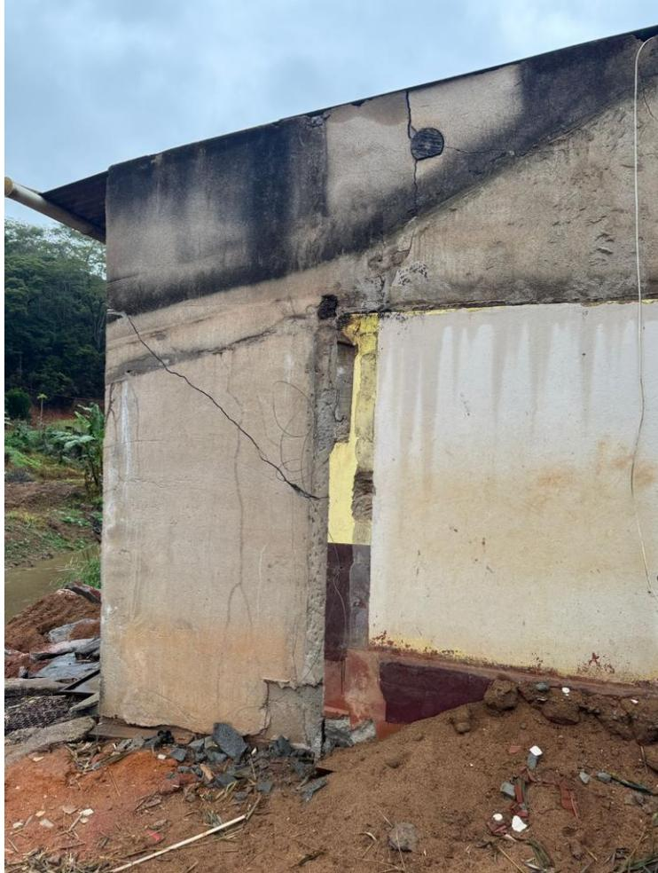
Figura 5 – Trincas na parte externa da casa.
