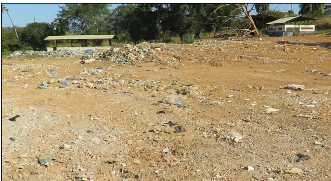
Foto 4 - Local de disposição com parte dos resíduos ainda sem o recobrimento. Fonte: Autoria da equipe.
