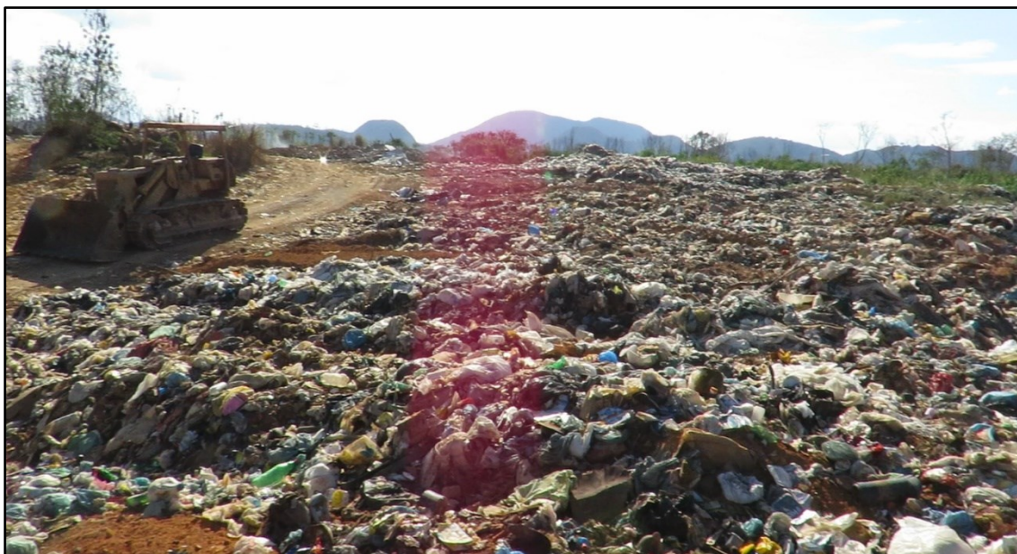
Foto 3 - Local de disposição ainda sem o devido recobrimento. Fonte: Autoria da equipe.
