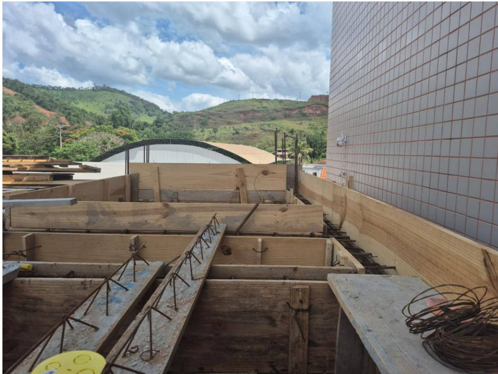
FOTO 8 ESCORAMENTO DE FÔRMAS DE LAJE
