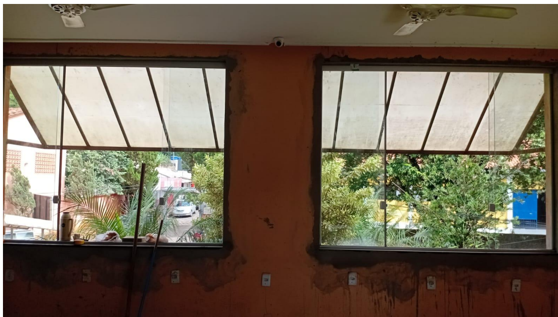
FOTO 14 JANELA DE ALUMÍNIO
