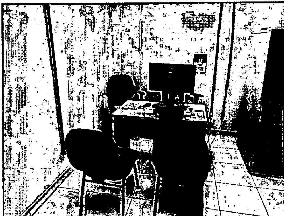
Figura 7: Sala de atendimento em bom estado de conservação.
