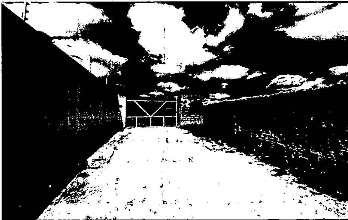
Figura 11: Acesso de entrada
