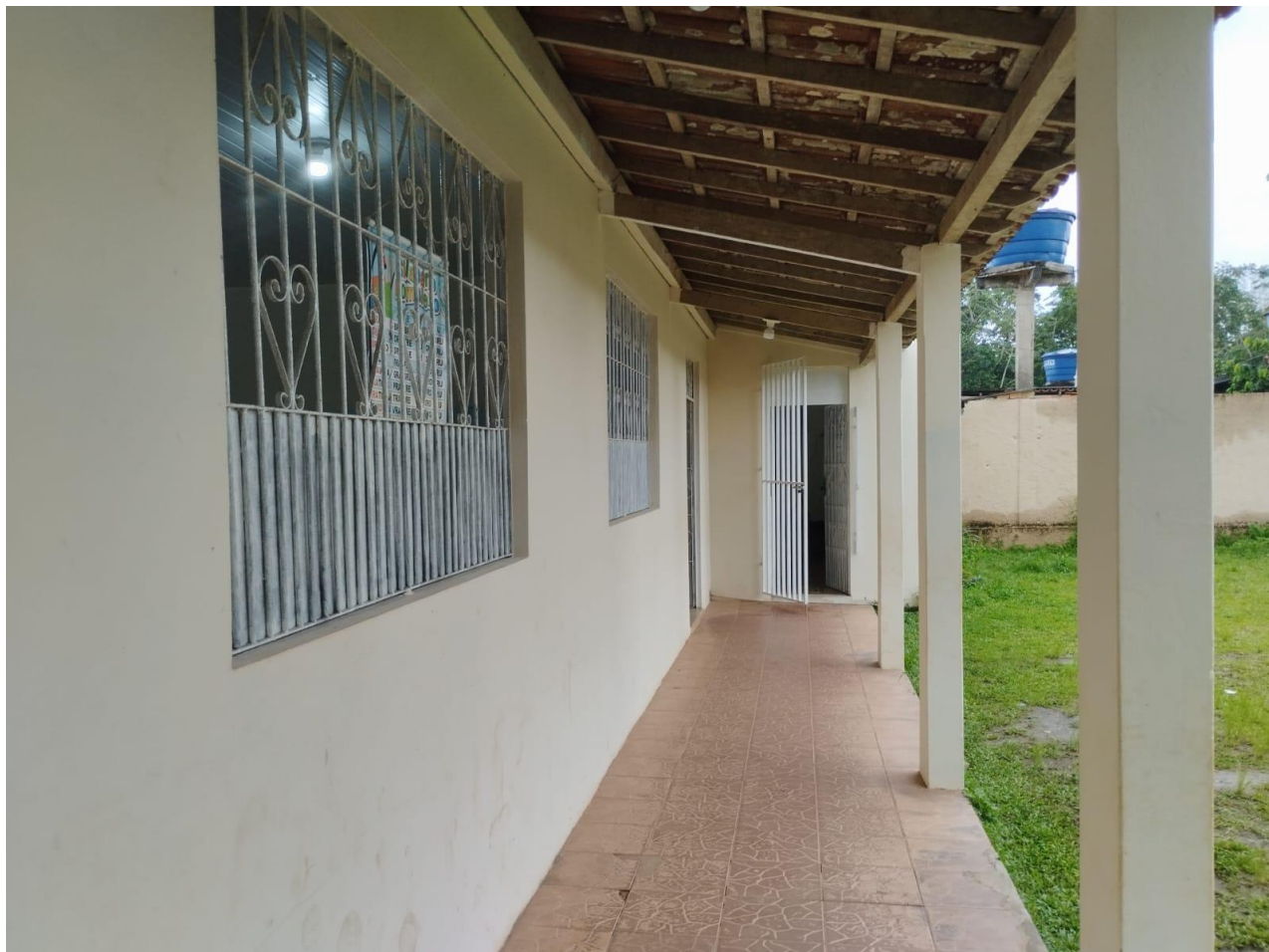
Manutenção da Escola Municipal Santa Rita
