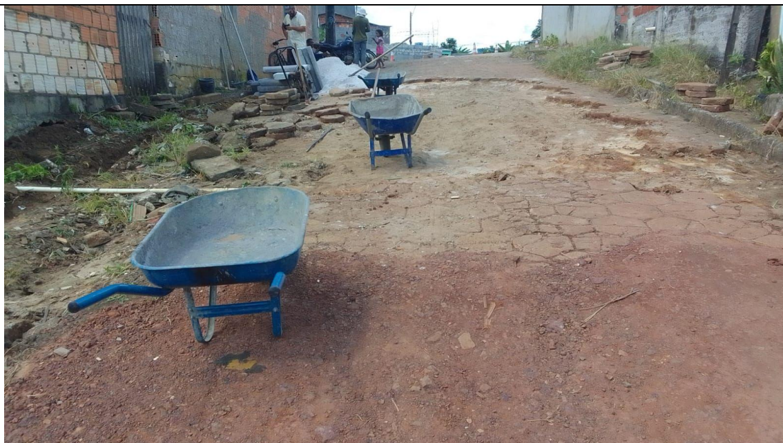
Recuperação da Rua Francisco da Silva no Bairro sucupira
