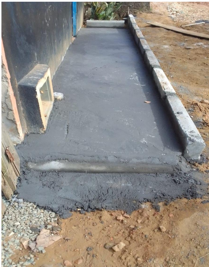
Recuperação de Passeios na Rua Francisco de Assis no Bairro Sucupira
