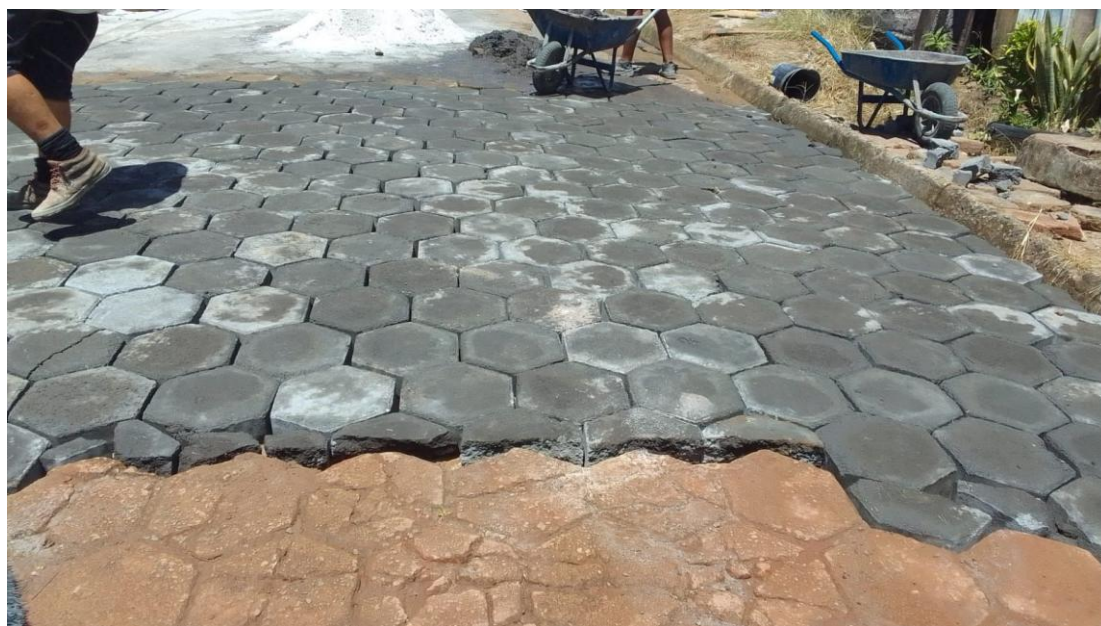
Recuperação de Rua São Pedro no bairro sucupira
