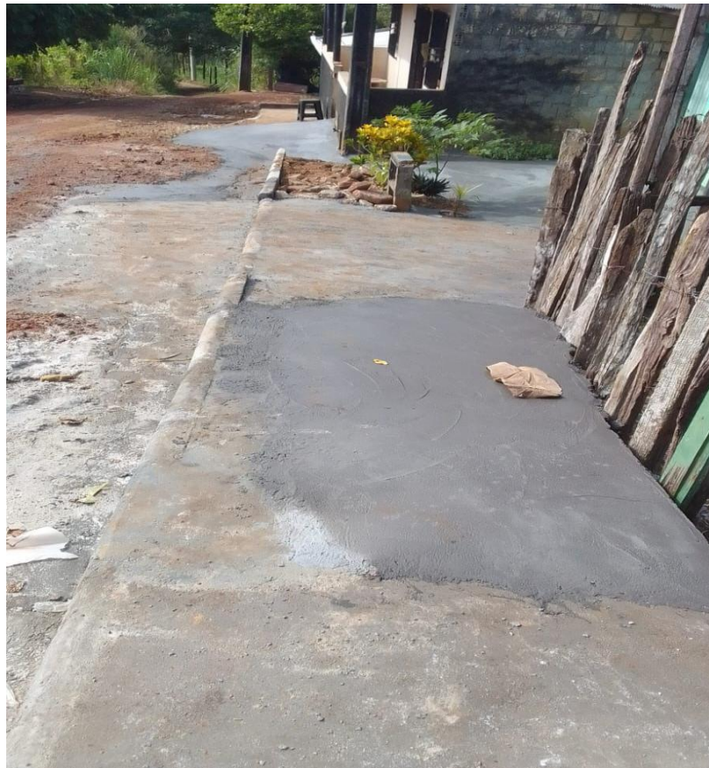
Recuperação de passeios na Rua São Pedro no bairro sucupira
