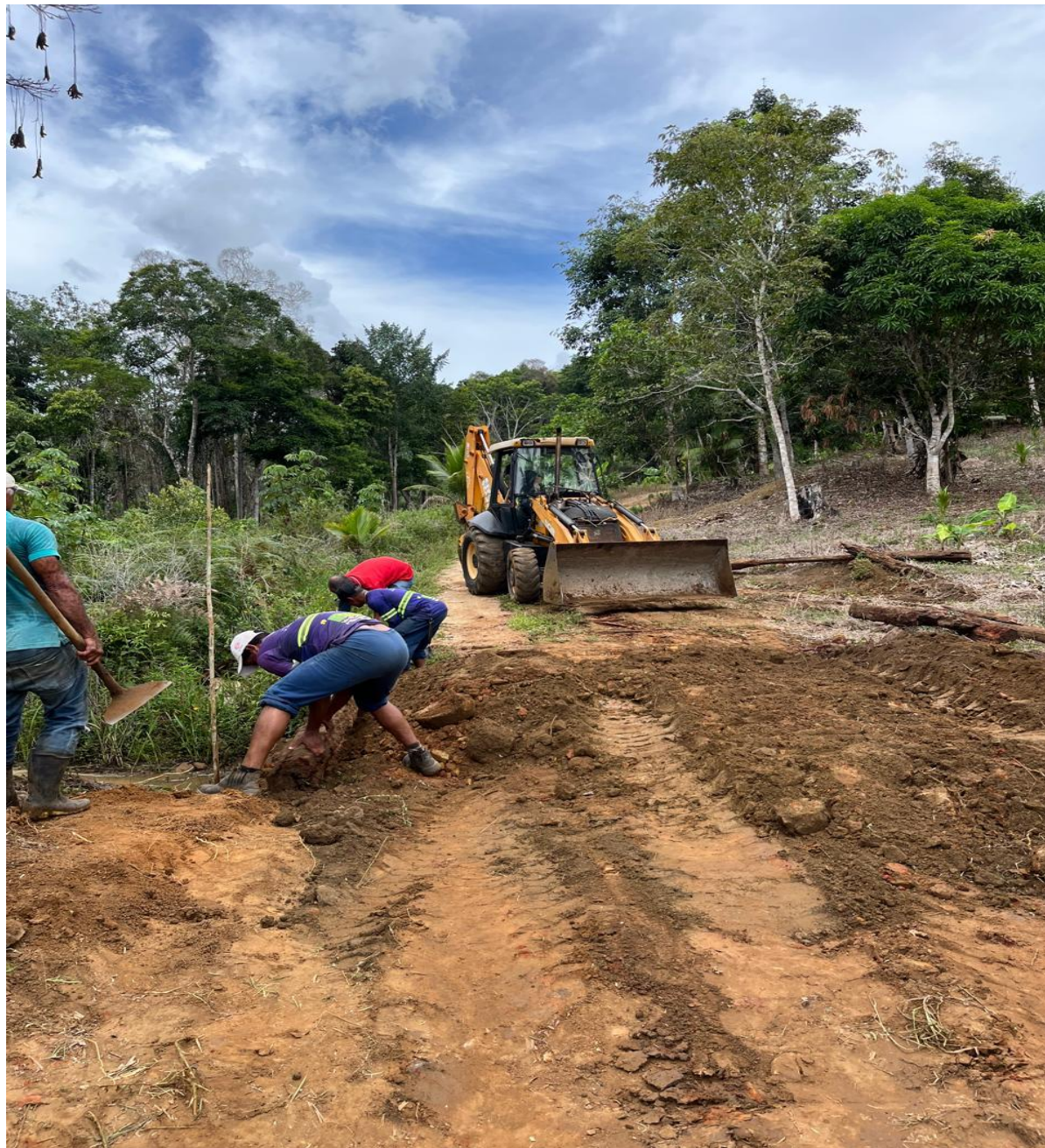
Manutenção de estrada rural – Estrada Rio da Serra – Independencia – Pedras de Una
