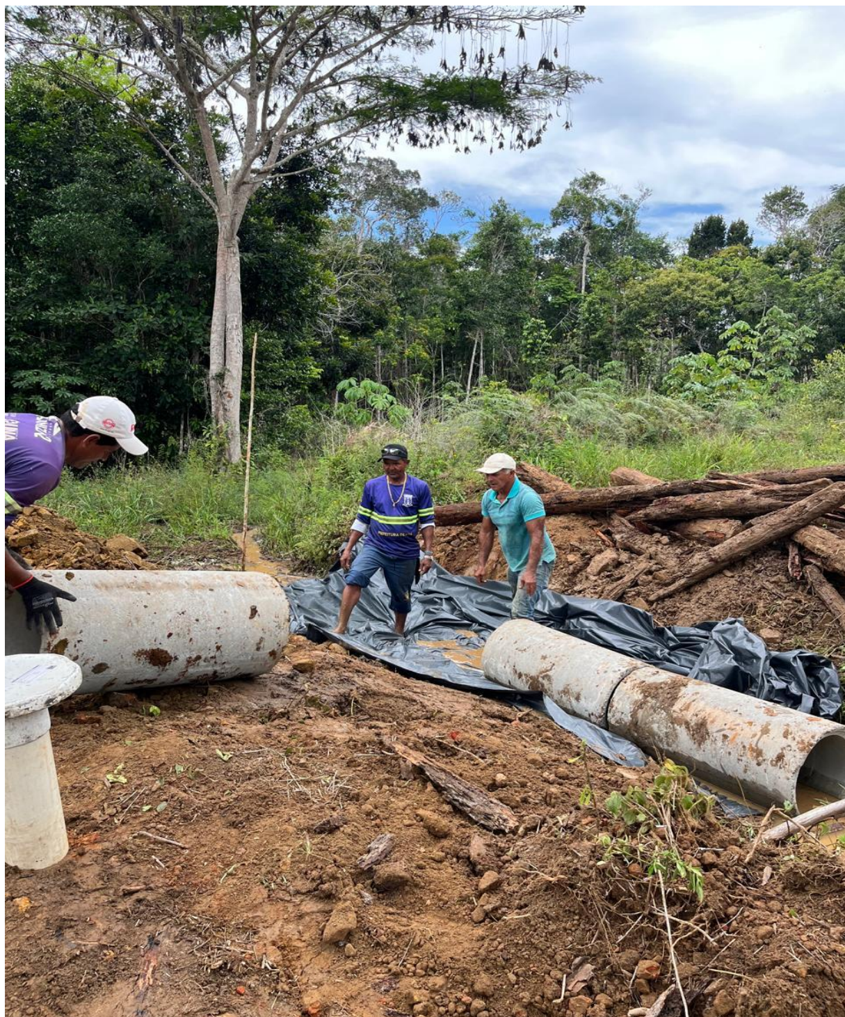
Manutenção de estrada rural e colocação de manilhas de concreto – Estrada Rio da Serra – Independencia – Pedras de Una
