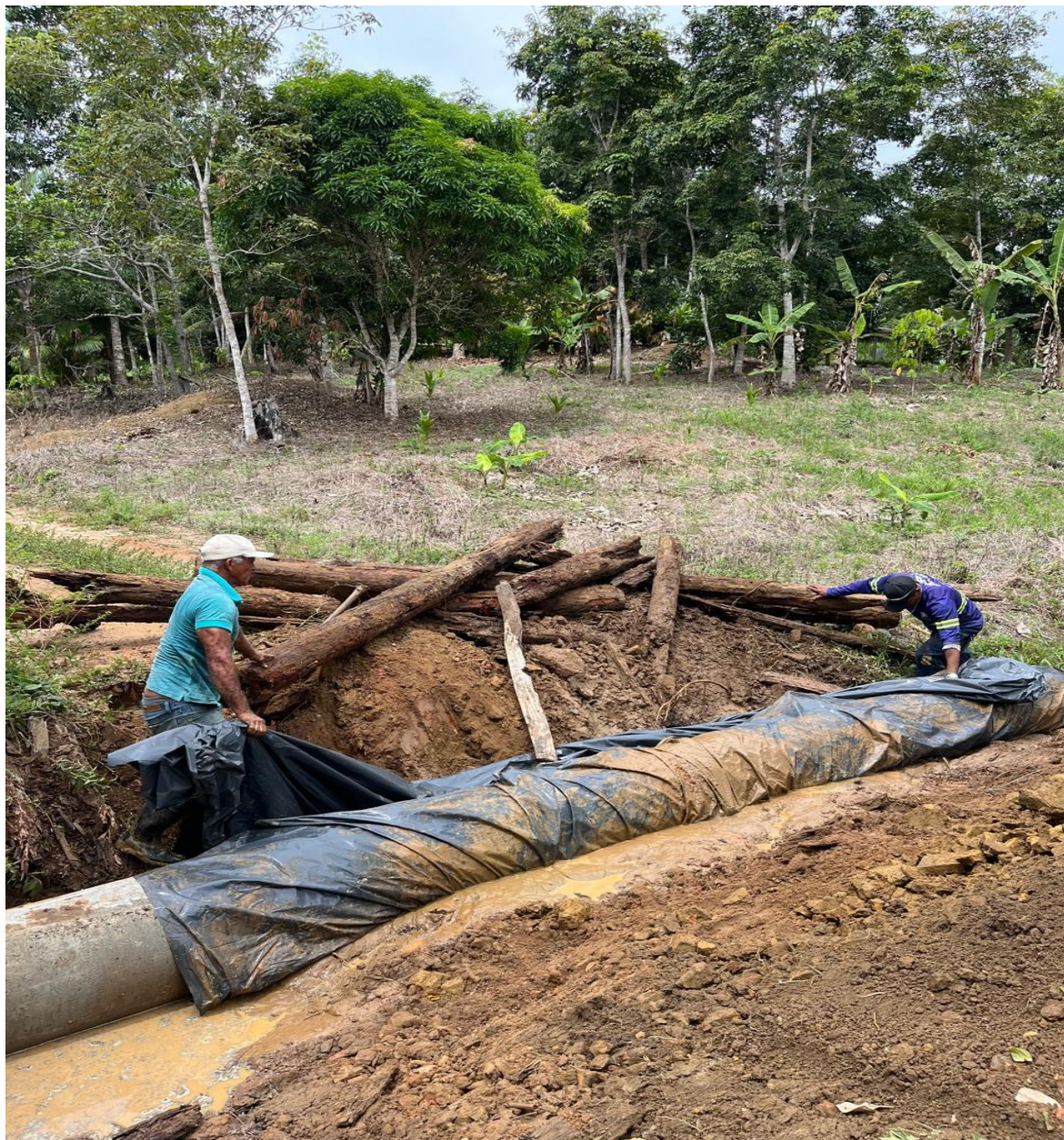
Colocação de manilhas de concreto – Estrada Rio da Serra – Independencia – Pedras de Una
