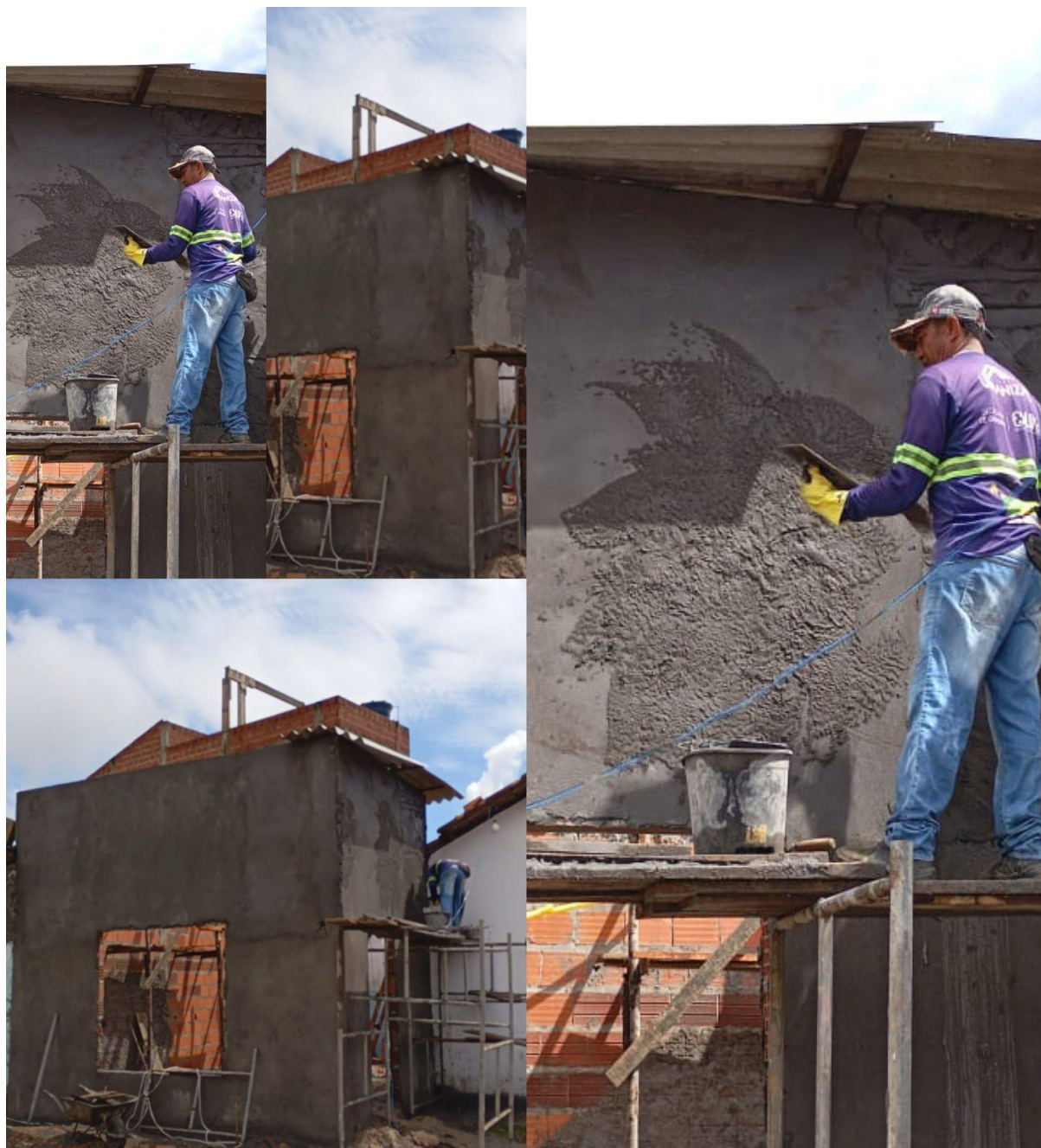
Construção da secretaria, 2 banheiros e sala dos professores.
