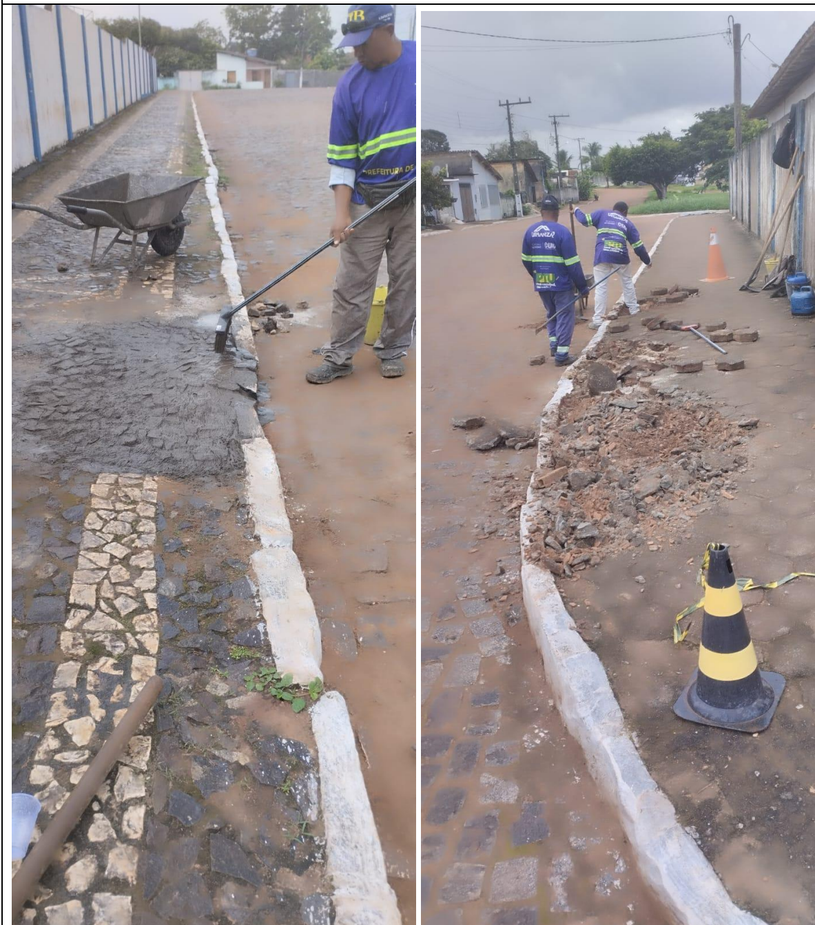
Manutenção de ruas e calçadas na Avenida Brasil no Distrito de Colônia de Una.
