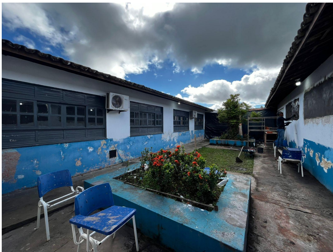
Manutenção do Colégio Municipal Alice Fuchs de Almeida
