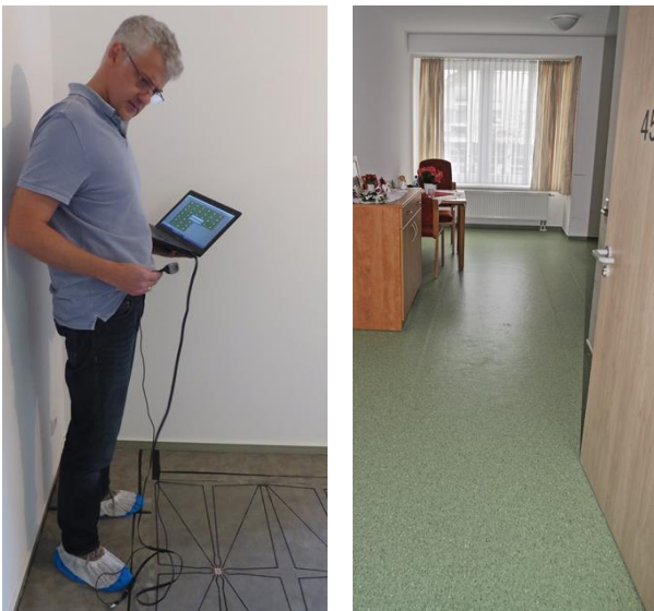
Bild 3 Boden geschliffen (oben links), SensFloor verlegt (oben rechts), Funktionsprüfung (unten links) und PVC verlegt (unten rechts)
